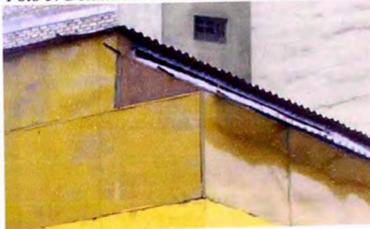
Foto 5: Detalle de la cobertura.
