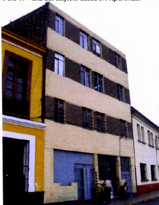
Foto 1: Vista del edificio desde Jr. Apurímac.
