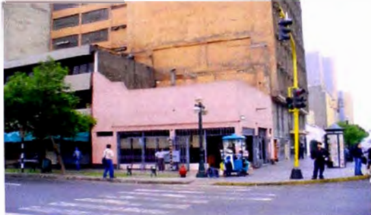
Foto 2: Vista del inmueble desde el Jr. Lampa.
