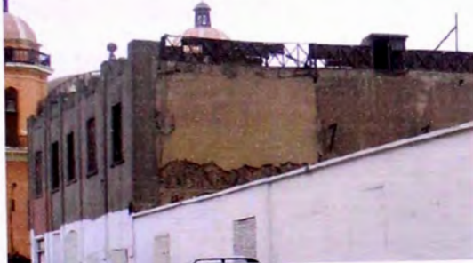
Foto 8: Estructura de quincha en 2° nivel, 2006
