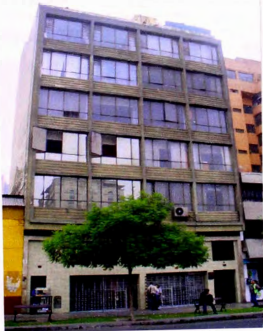
Foto 1: Edificio desde la Av. Nicolás de Piérola.
