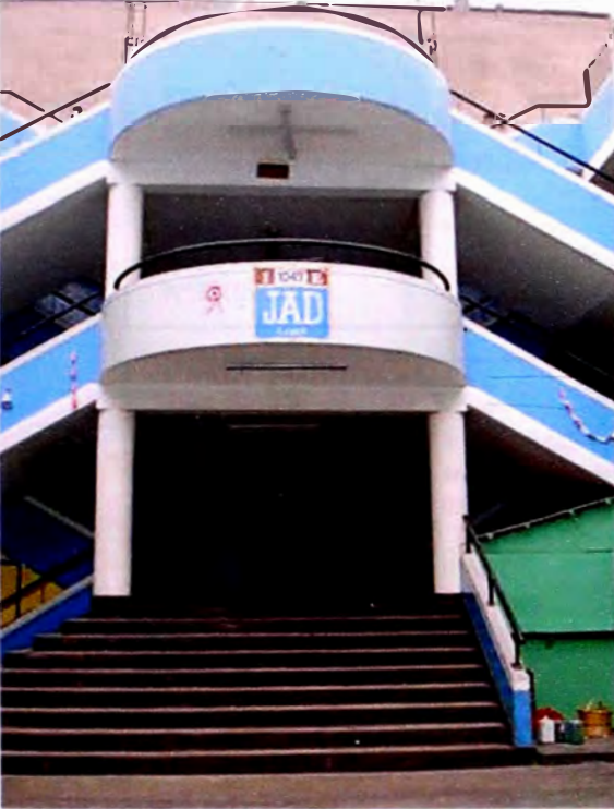
Foto 8: Obra nueva, escalera principal, 2007.
