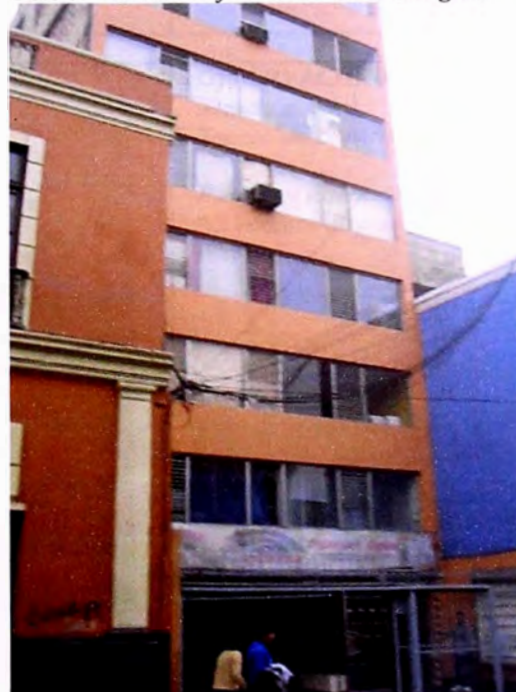
Foto 3: Vista del edificio desde el Jr. Azángaro.
