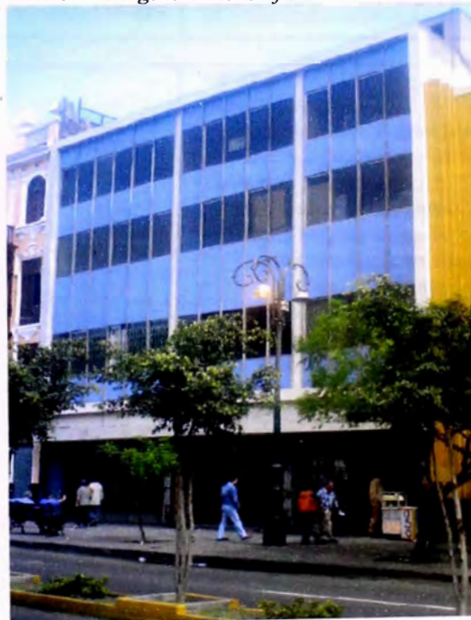
Foto 3: Vista general del edificio.
