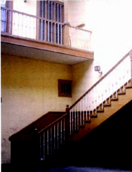
Foto 3: Escalera principal, en el primer patio.
