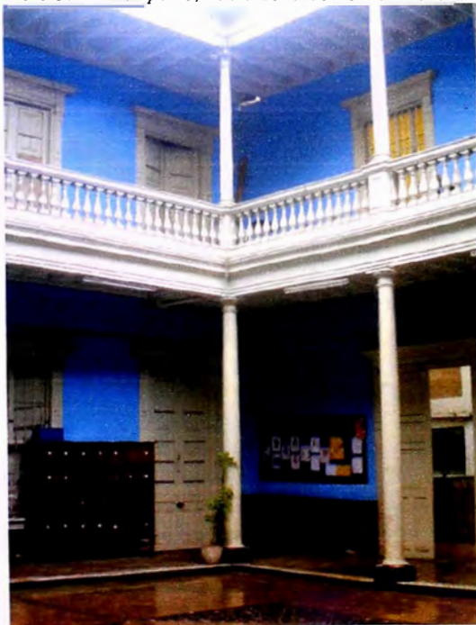
Foto 5: Primer patio, hacia zona con obra nueva.
