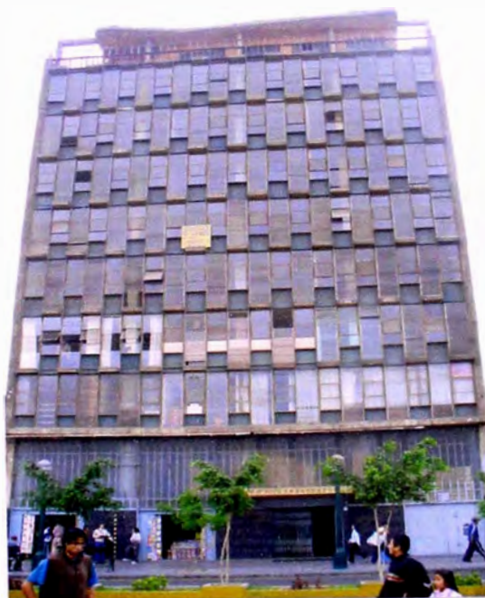
Foto 2: Vista general del edificio.
