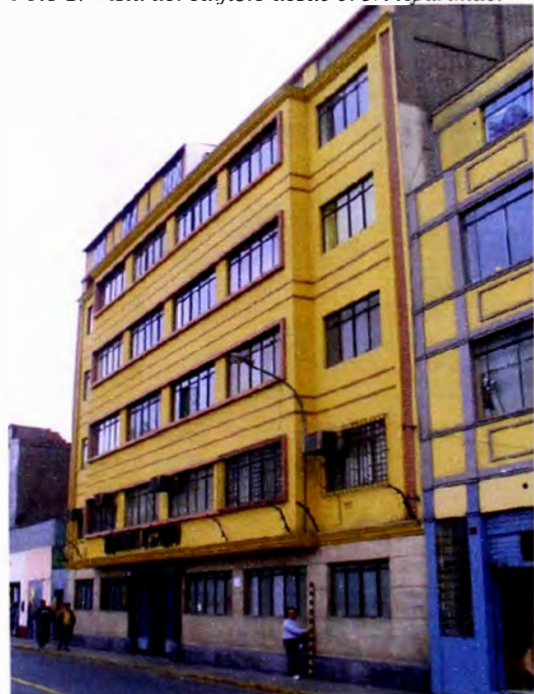
Foto 2: Vista del edificio desde el Jr. Apurímac.
