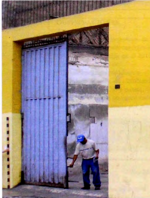
Foto 3: Vista del acceso.
