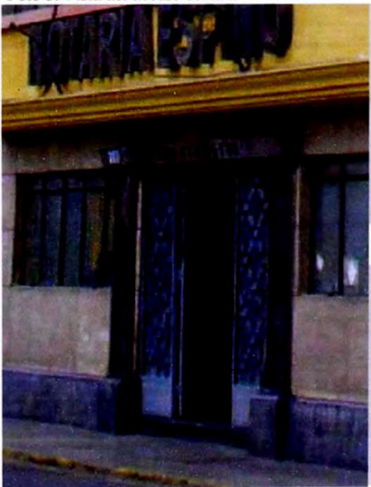
Foto 3: Vista del acceso común.
