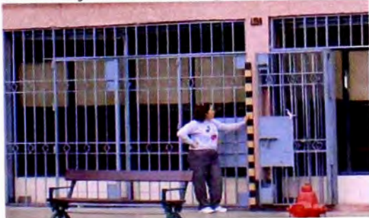
Foto 4: Rejas metálicas de seguridad.
