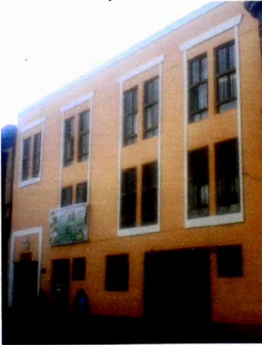
Foto 3: Vista del edificio desde el Jr. Puno, 2007.
