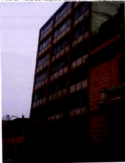
Foto 2: Vista del edificio desde el Jr. Azángaro.
