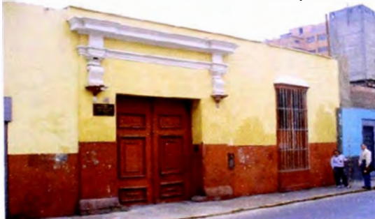
Foto 2: Vista del inmueble desde el Jr. Apurímac.
