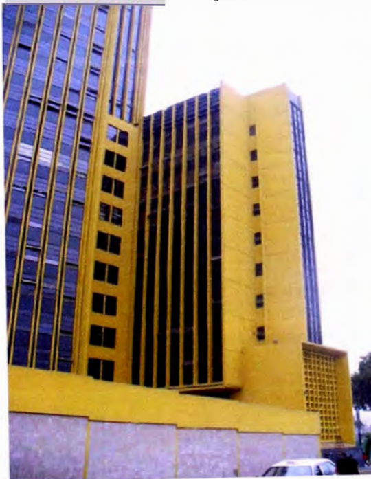
Foto 1: vista posterior del edificio.
