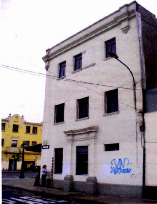
Foto 3: Vista del inmueble desde el Jr. Apurímac.
