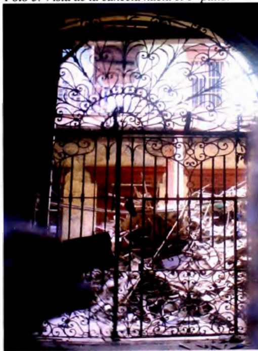
Foto 3: Vista de la cancela hacia el 1° patio.
