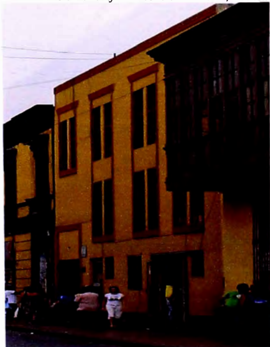
Foto 2: Vista del edificio desde el Jr. Puno, 2010.
