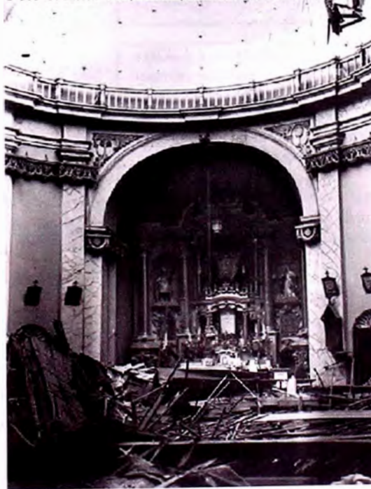
Foto 6: Altar mayor después del terremoto, 1940.
