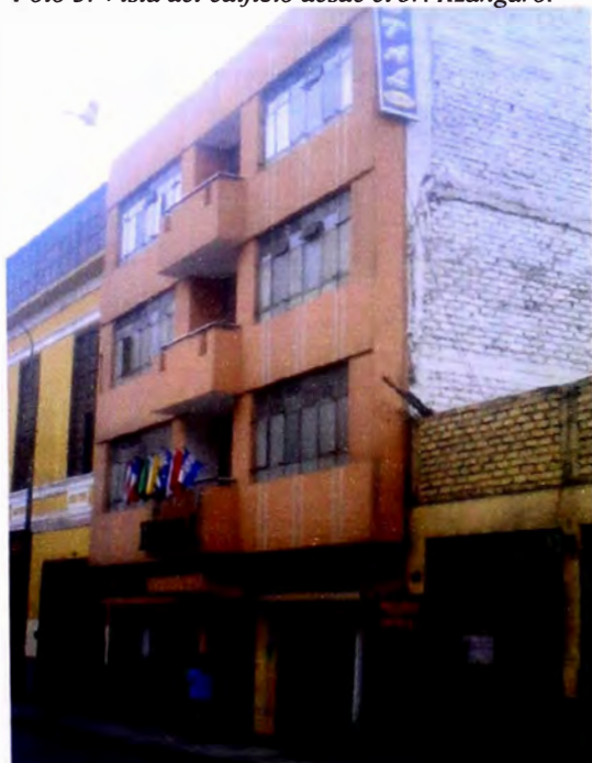
Foto 3: Vista del edificio desde el Jr. Azángaro.
