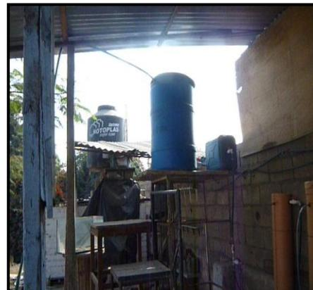
*Fig. N°22: Llenando el Reservorio Elevado del efluente del RAFA.*
