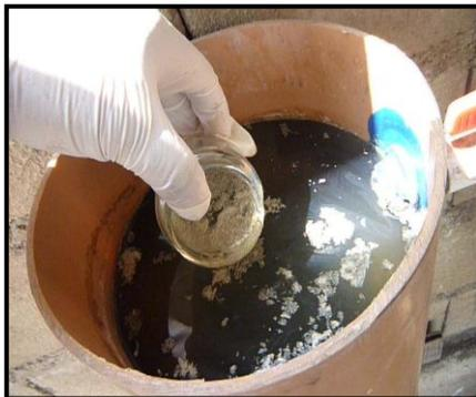
*Fig. N°26: Limpieza de natas en el Reactor Anaerobio.*
