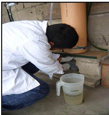
*Fig. N°24: Purgado y Limpieza de filtro para evitar la colmatación.*
