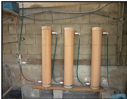
*Fig. N°6: Conexión en serie de los Filtros Anaerobios*
