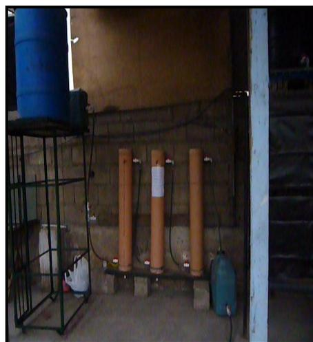
*Fig. N°9: Al final de la Batería se ubica la unidad de Recolección y su conexión hacia el alcantarillado.*
