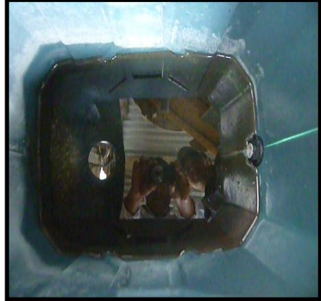
*Fig. N°51: Vista dentro de la Unidad de Recolección, llega el agua del tercer filtro y sale mediante conexión hacia la red de alcantarillado .*
