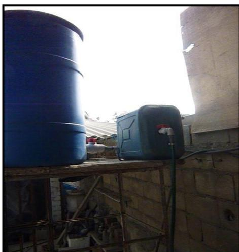
*Fig. N°8: Reservorio Elevado y Cámara Reguladora de carga hidráulica*
