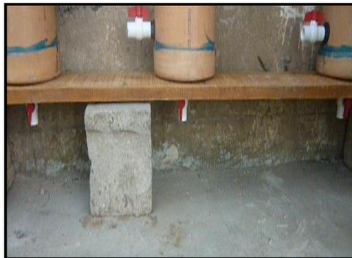
*Fig. N°7: Válvulas de Limpieza y eliminación de Lodos.*
