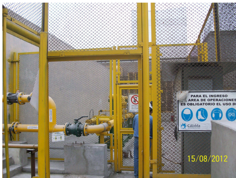
Figura 6.9: Parte del city gate ubicado en Lurín
