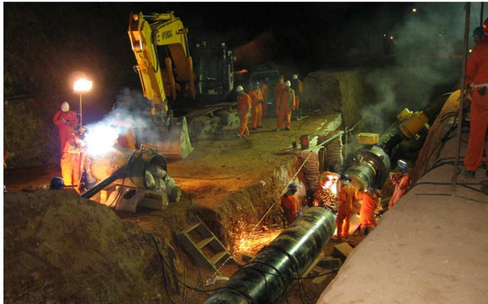
Figura 6.5: Construcción del loop costa
