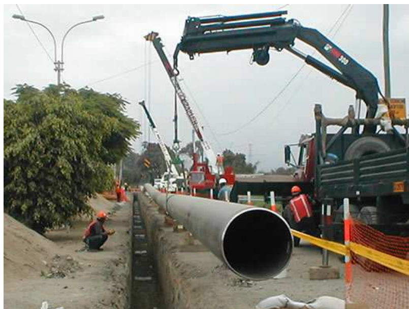
Figura 6.8: Construcción de la red principal en Lima y Callao
