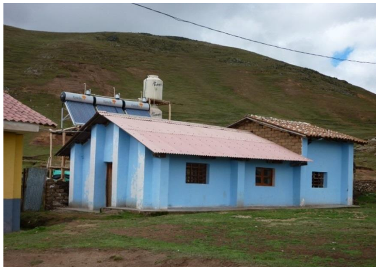
Figura A.2.6. Vista frontal de la Planta para elaborar queso y yogurt.
