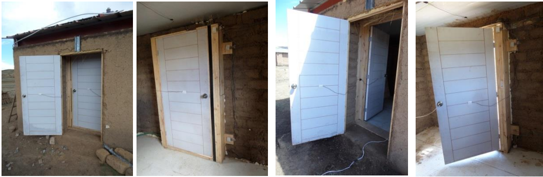
Figura 3.2.8. Serie de imagines que ilustran la forma y posición de la esclusa formada entre la puerta de la habitación y la contrapuerta en el pórtico interior.
