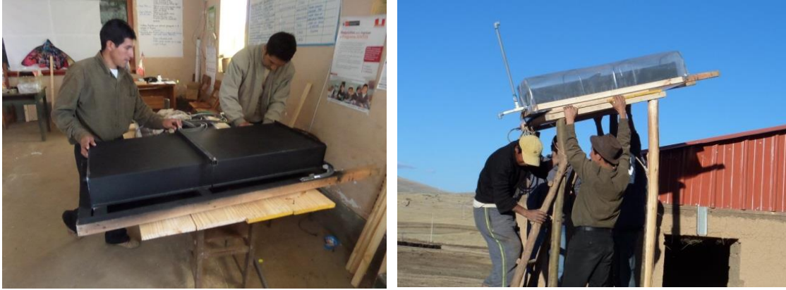
Figura 3.3.5. La imagen de la izquierda deja ver la “batería” del colector en proceso de armado; a la derecha se observa al colector sobre el soporte preparado para su montaje mirando al norte, puede notarse la cubierta de plástico que envuelve a la batería metálica.
