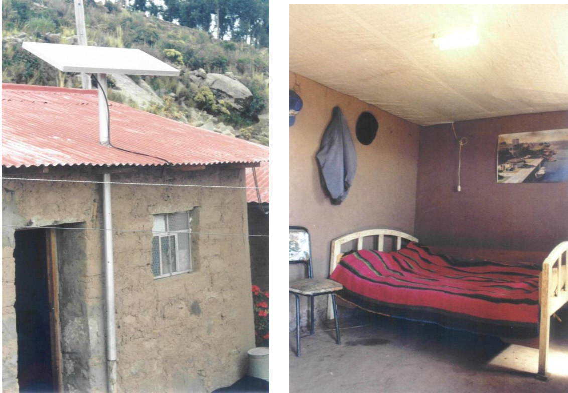
Figura 1.3.3. Fotografías que reproducen detalles de casas rurales de la isla Taquile del lago Titicaca del departamento de Puno (3800msnm). La de la izquierda permite apreciar el grosor de los muros de adobe con que se construyen y ventanas pequeñas; la de la derecha muestra el interior de la casa, el dormitorio, y deja apreciar el falso techo. Muros gruesos, ventanas pequeñas y falso techo, proveen a la vivienda de mejores condiciones de confort respecto a la temperatura. Puede apreciarse también, el módulo fotovoltaico (izquierda) y la lámpara interior (derecha), partes componentes del SFD instalado.
