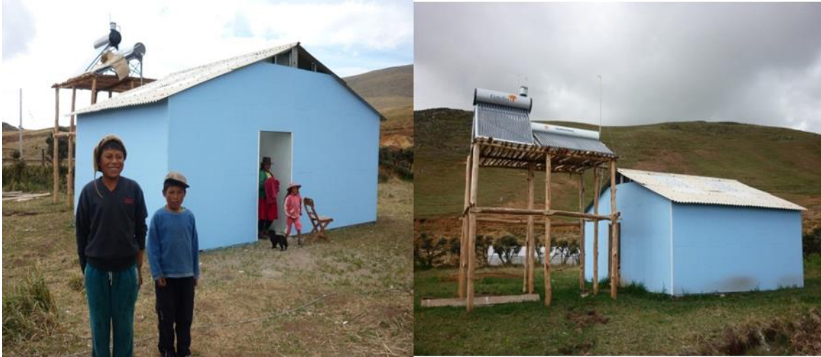
Figura A.2.7. Frontis del módulo sanitarios, a la derecha se observa las termas solares utilizadas para abastecer de agua caliente a las duchas comunales del módulo.
