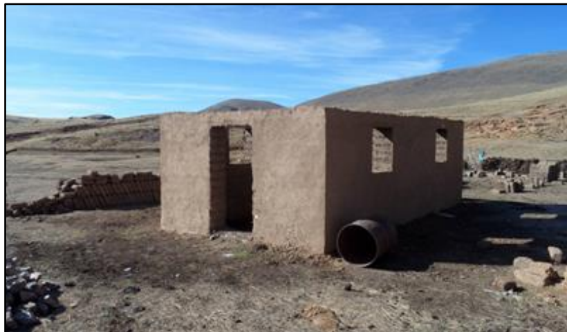
Figura 3.3.1. Imagen real de los cerramientos del MEV en la Comunidad de SFR, Vilcashuamán, Ayacucho, a 3 700 msnm.
