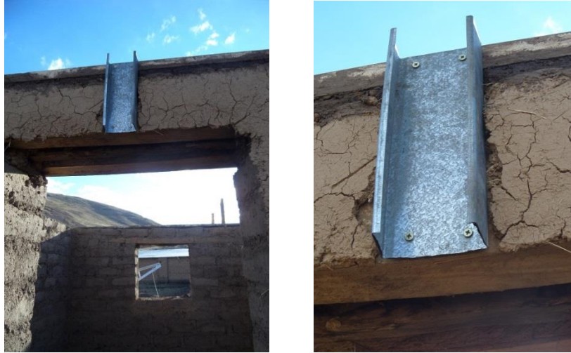
Figura 3.2.7. Las imágenes ilustran la forma de sujeción de la viga collar a la estructura del MEV haciendo uso del dintel de una puerta atornillando una viga de acero de 0,3m de longitud a la viga y al dintel. Antes se explicó que los tijerales de la estructura del techo se atornillaron a la viga collar, por lo tanto quedaron firmemente unidos el techo con los muros del MEV.
