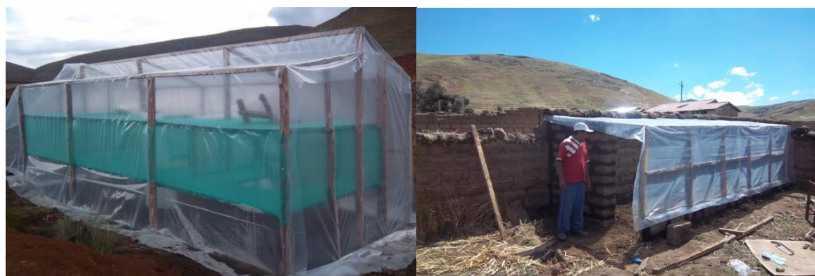
Figura A.2.5. Dos imágenes de biohuerto familiar, terminado y en construcción.
