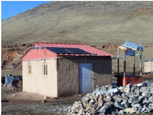
Figura 3.3.7. Las fotografías de arriba muestran, a la izquierda, la imagen de una ventana en posición cerrada vista desde el exterior, a la derecha se observa el colector solar tipo rejilla instalado sobre el ala del techo que mira al norte. Las fotografías de abajo muestran la imagen final del MEV.
