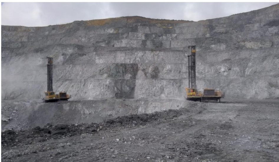
Figura 2, 10 Perforación con equipos DML
