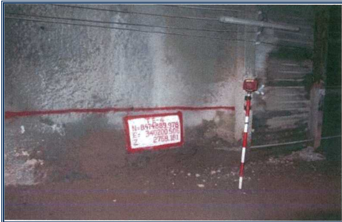
Foto 3.5 Punto base TE4, ubicado en el piso del túnel al hastial derecho, aproximadamente en la progresiva 00+256
