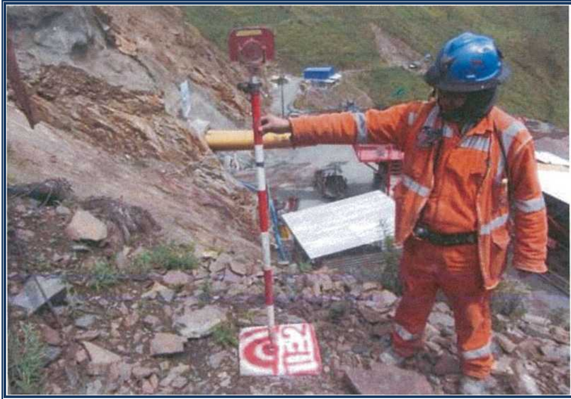
Foto 3.2 Punto base TE3, ubicado a 0.20 metros del eje del túnel en el ingreso
