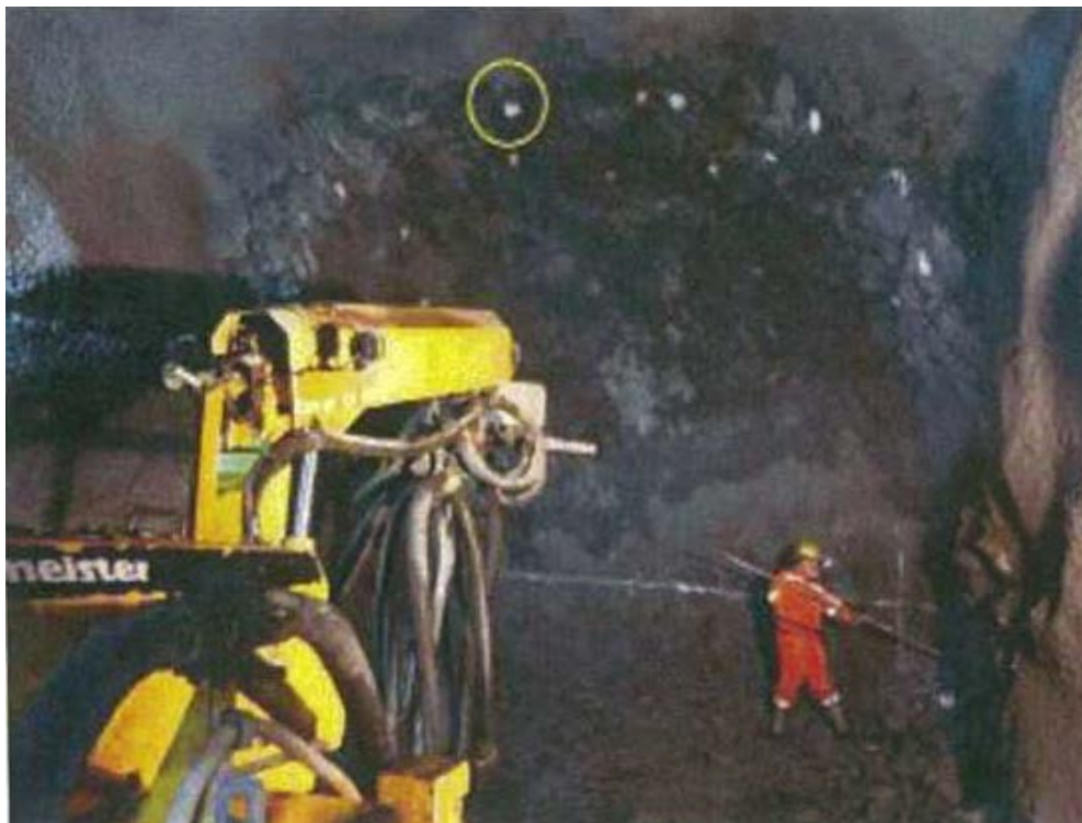
Foto 3.6 Calibradores instalados en los perimetrales
