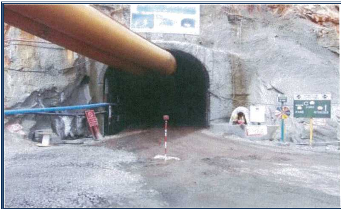
Foto 3.2 Punto base TE3, ubicado a 0.20 metros del eje del túnel en el ingreso
