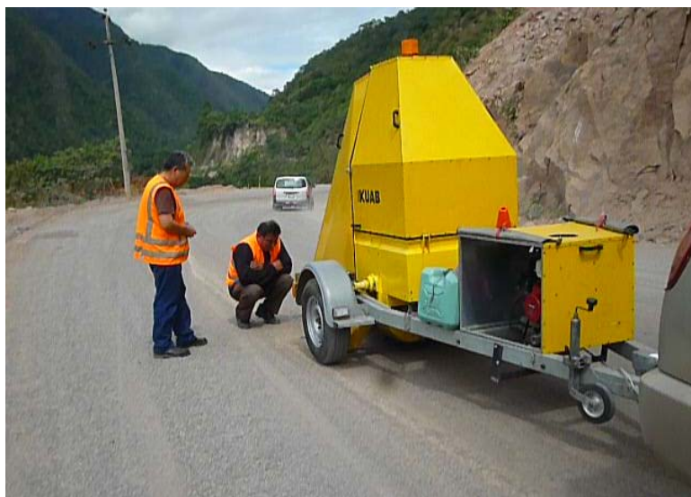
Fotografía 5.3 Medición de deflexiones sobre capa base con deflectómetro de Impacto Marca KUAB Fuente: Elaboración Propia
