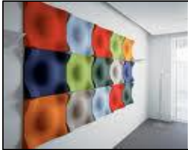
Figura 57: Materiales fonoabsorbentes en paredes.
