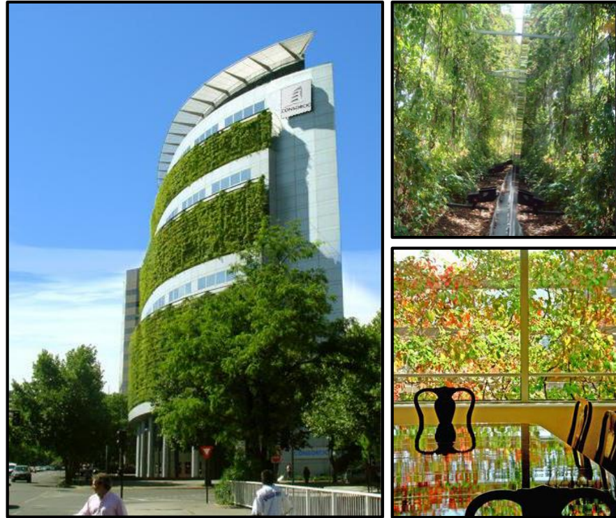
Figura 43: Fachadas naturales que ayudan a controlar el ingreso de la luz a la vivienda, pero se debe dejar un retiro necesario para la cobertura exterior de la fachada, disminuyendo el área de construir final.
