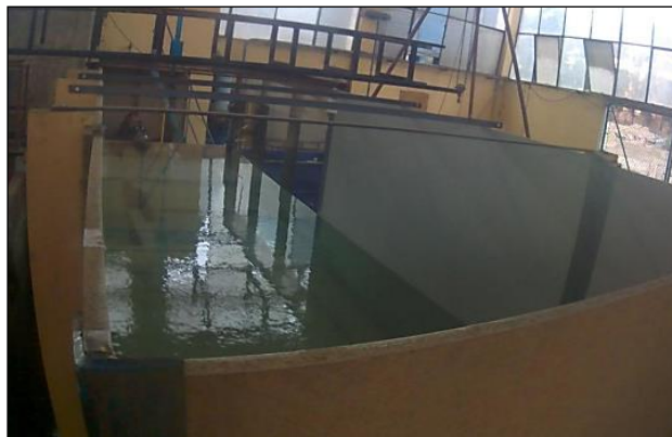
Foto 3: Cámara de carga
