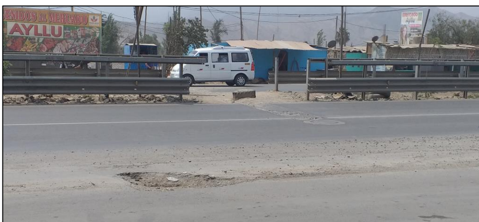
FOTOGRAFÍA N°8.7: Zona del 1er puente peatonal (2021) Fuente: Elaboración propia
