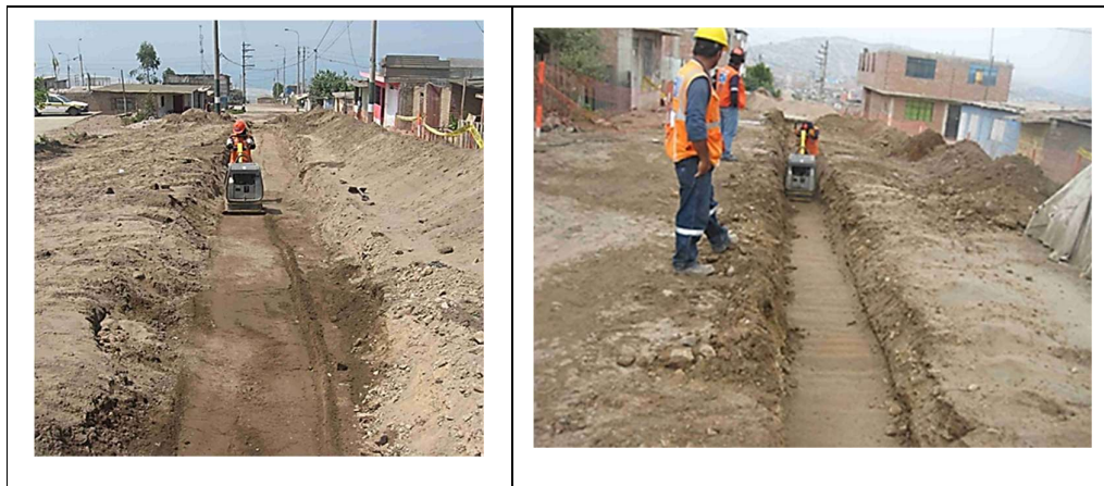
Figura N° 22 Conformación de rellenos con equipos menores
