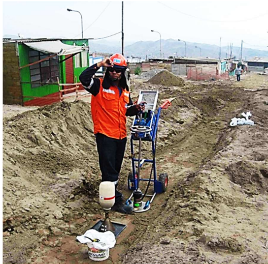
Figura N° 35 Control de calidad con LWD en conexiones domiciliarias
