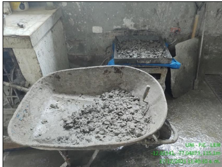
Figura 139. Separación de la Pasta de Concreto, con la Mesa Vibradora. (Capítulo 5.1.3; pág. 51)
