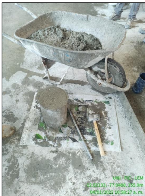
Figura 137. Llenado y Compactado del Concreto. (Capítulo 5.1.2; pág. 48)
