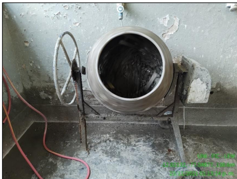
Figura 135. Mezclado del Concreto para los Diseños de a/c: 0.25,0.30 y 0.35. (Capítulo 5.1.2; pág. 48)
