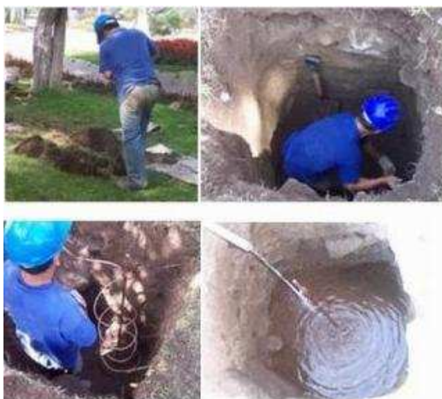
Figura 4.36 Instalación del sistema de puesta a tierra
