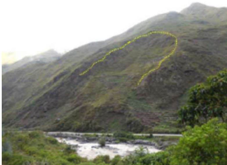
Figura N° 8 Deslizamiento a la altura de la progresiva 241+500
