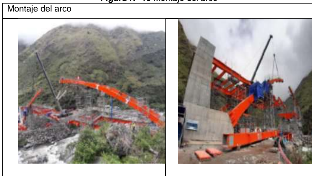
Figura N° 15 Montaje del arco
