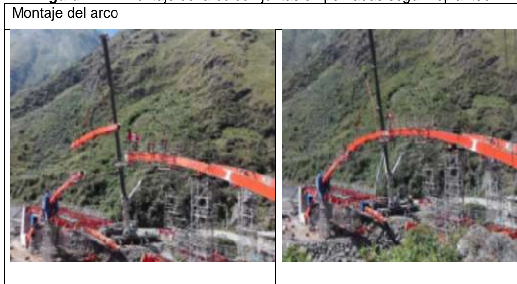
Figura N° 14 Montaje del arco con juntas empernadas según replanteo
