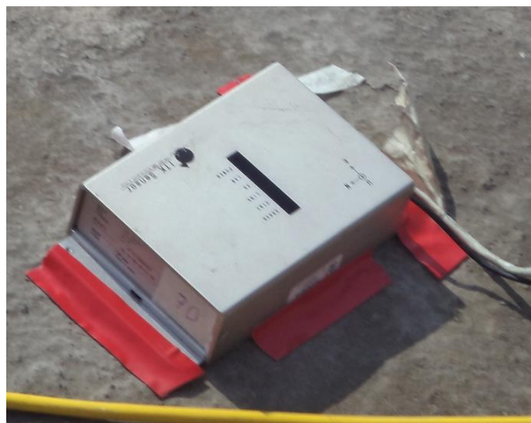
Figura N° E.3 Instalación del sensor P03.
