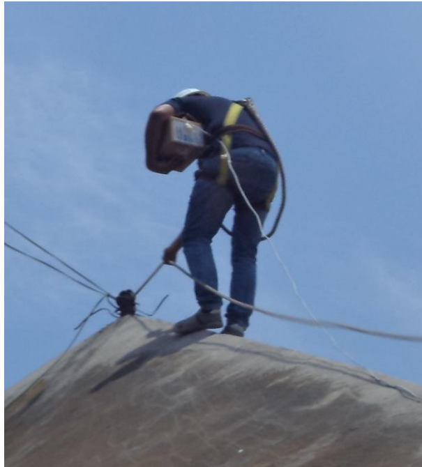
Figura N° E.2 Utilización de equipos de seguridad para la instalación de sensores.
