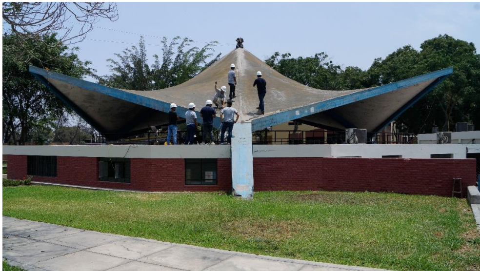
Figura N° E.7 Equipo de trabajo asignado para el ensayo de vibraciones ambientales.
