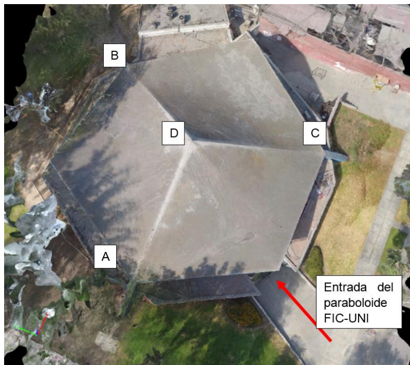
Figura N° B.1 Descripción de vértices en estudio del paraboloide hiperbólico FIC-UNI
