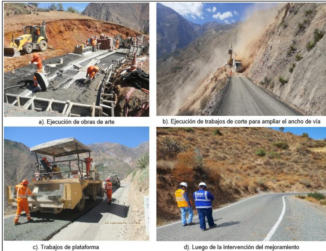
Figura 3.3 Trabajos de intervención en el mejoramiento
