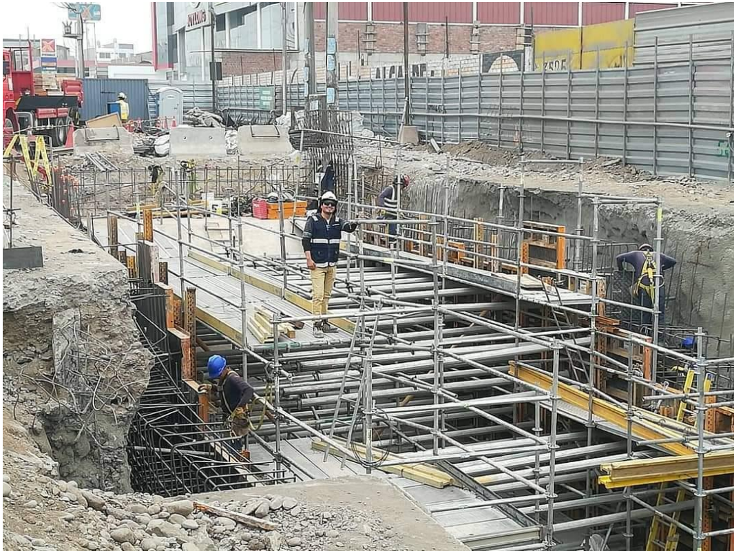
Foto 11. Encofrado de muros laterales del Acceso Sur.
