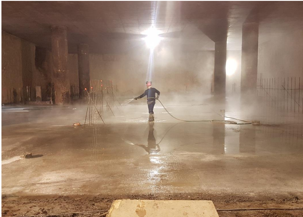
Foto 7. Proceso de curado de losa de hormigón a nivel de vestíbulo.
