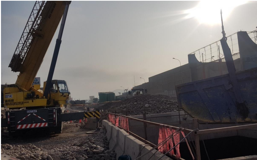
Foto 9. Extracción vertical de tierras con balde basculante y grúa telescópica.
