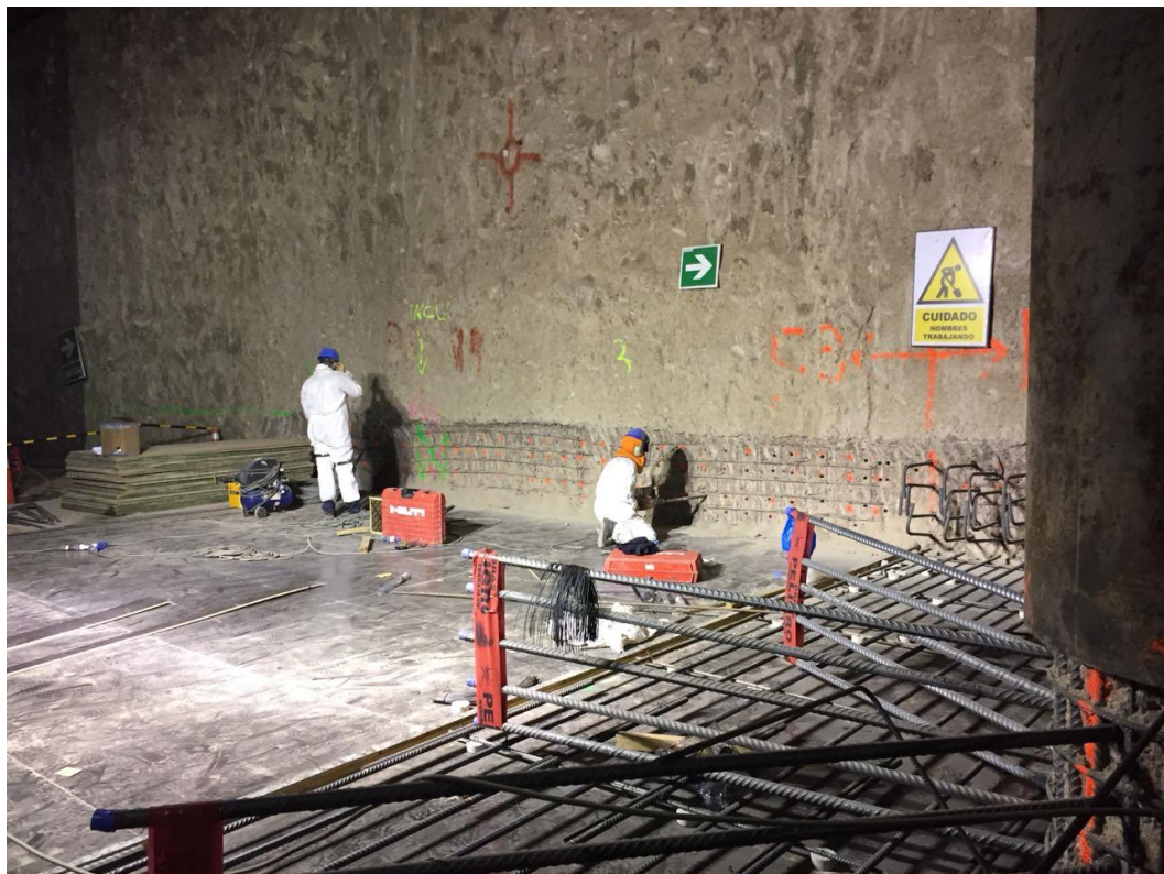
Foto 5. Proceso de anclajes de barras de acero a pantallas de concreto.
