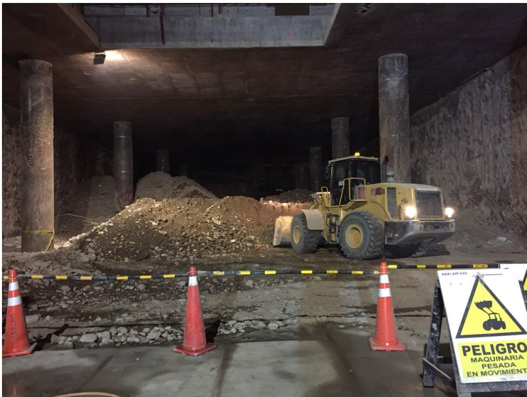
Foto 3. Corte y carguío de tierras a nivel de vestíbulo.
