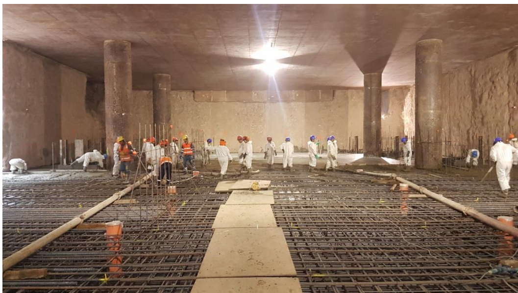
Foto 6. Hormigonado masivo de una fase de losa de nivel de vestíbulo.
