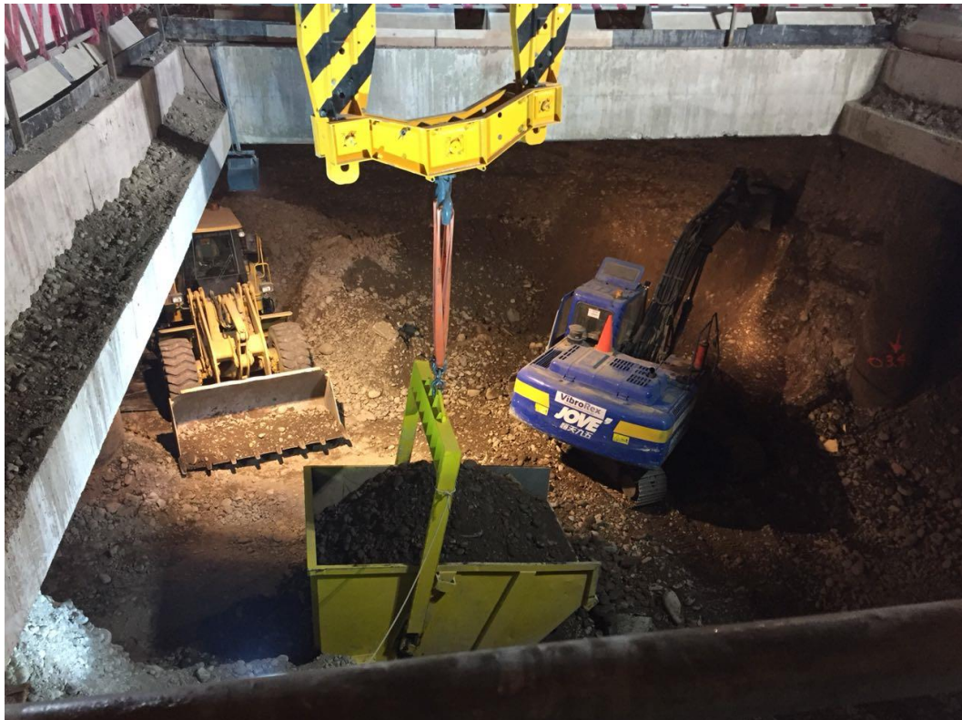
Foto 2. Extracción vertical de tierras del nivel de vestíbulo.
