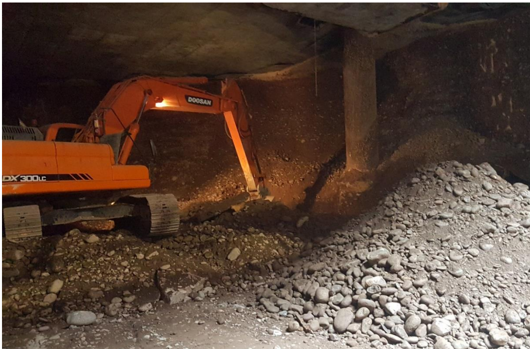
Foto 8. Corte de terreno a nivel de losa de fondo.
