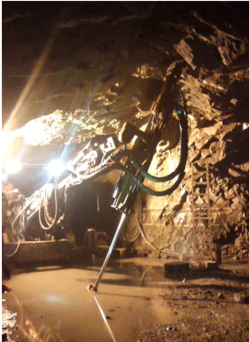
Figura 5 Equipo de Perforación Rocket Boomer 282.
