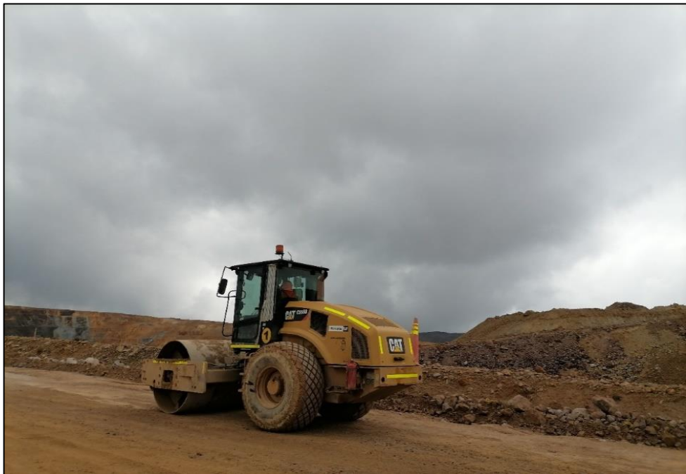
Figura 25: Rodillo 20 TN realizando la compactación de la vía minera antes de la aplicación del aditivo.
