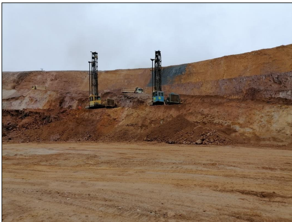
Figura 05: Perforación primaria con perforadoras DM45
