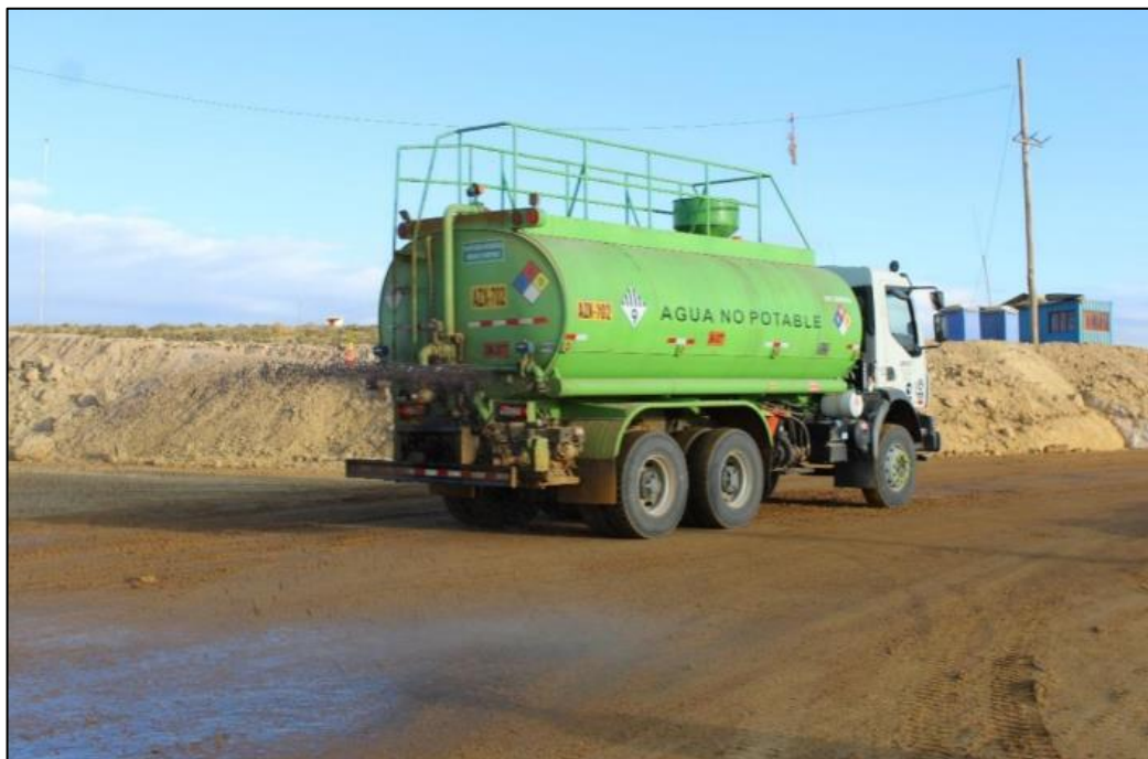
Figura 27: Cisterna aplicando el aditivo una segunda vez para reforzar la primera aplicación.
