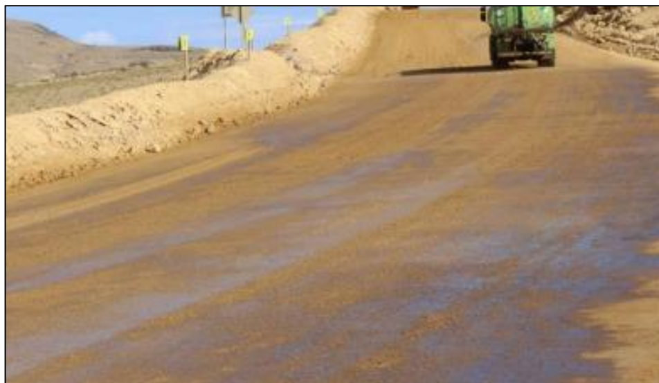
Figura 15. Estabilización química de vías no pavimentadas.
