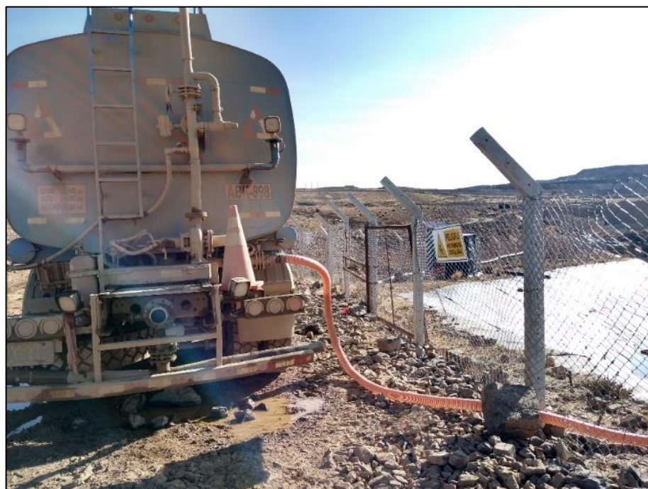
Figura 19: Abastecimiento de cisterna de agua no potable por succión en el dique 02.
