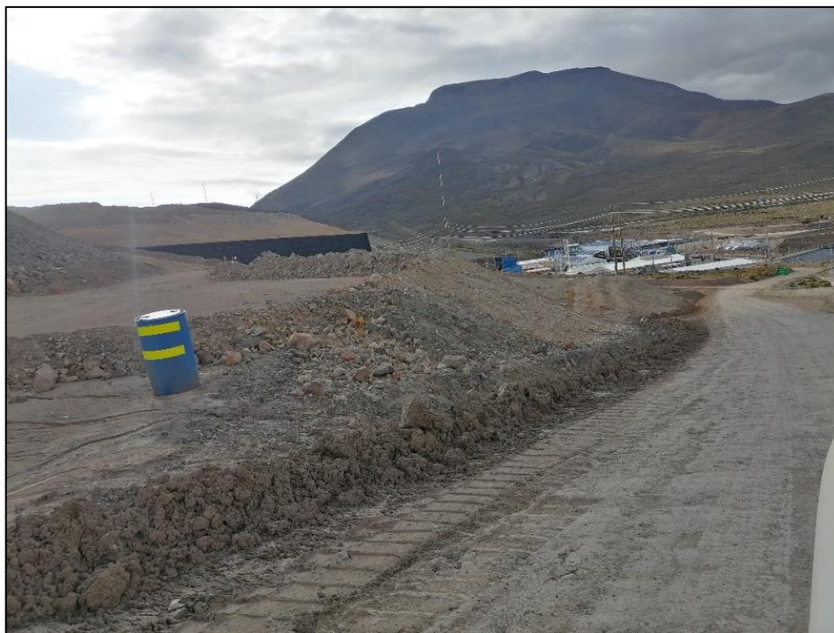
Figura 13. Vía auxiliar en una operación minera a Tajo Abierto
