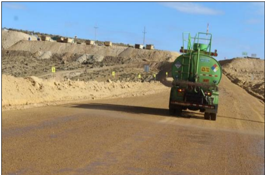
Figura 26: Cisterna aplicando por primera vez el aditivo en la vía minera.
