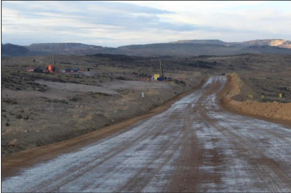
Figura 28: Vía minera con el aditivo aplicado.
