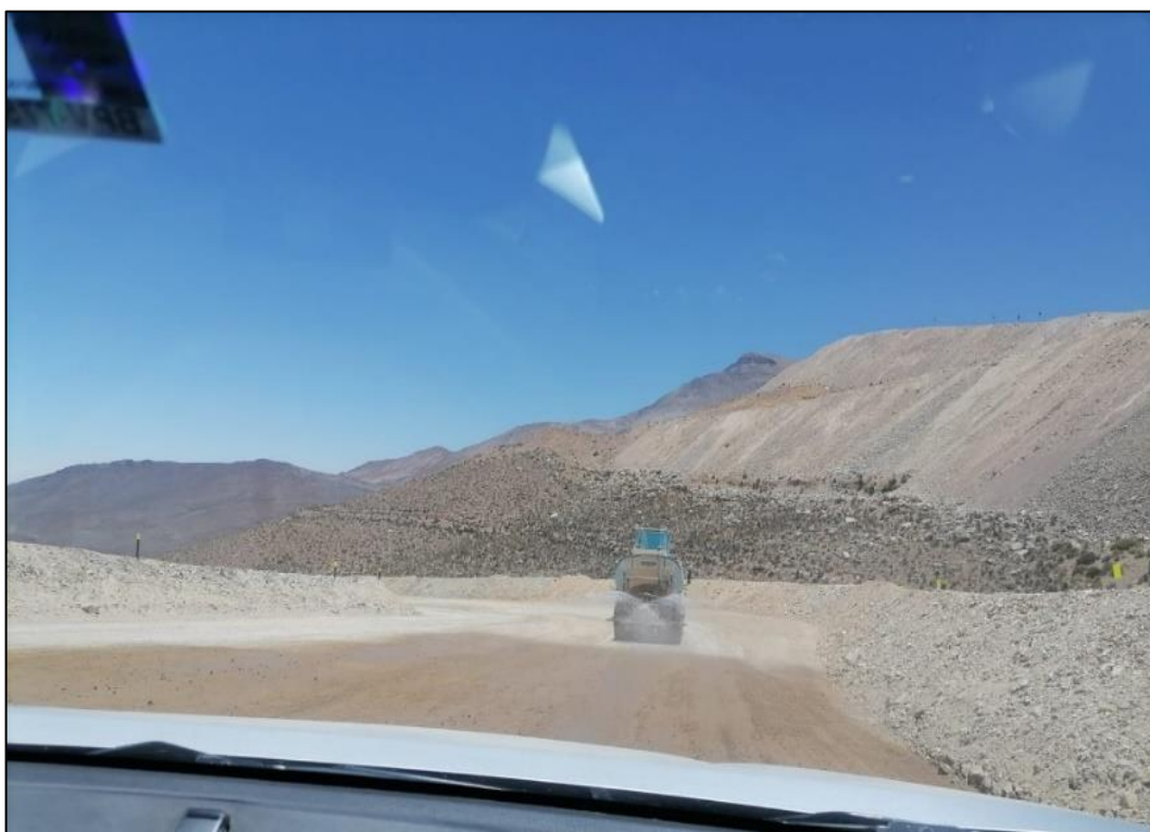
Figura 23: Cisterna de agua no potable realizando el riego de la vía minera antes de aplicar el aditivo.
