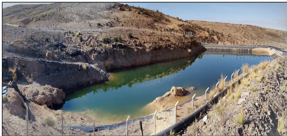
Figura 17. Dique 02 con el agua almacenada destinada para el riego de vías.
