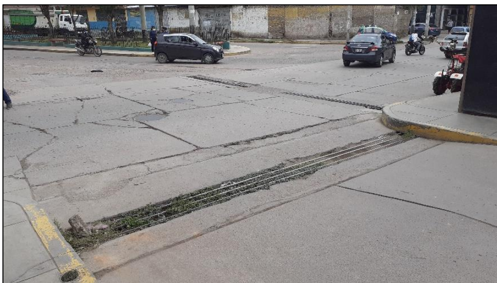
Figura 3.11 Sumideros en el cruce del colector Francisco Pizarro y el colector Mario Ramos
