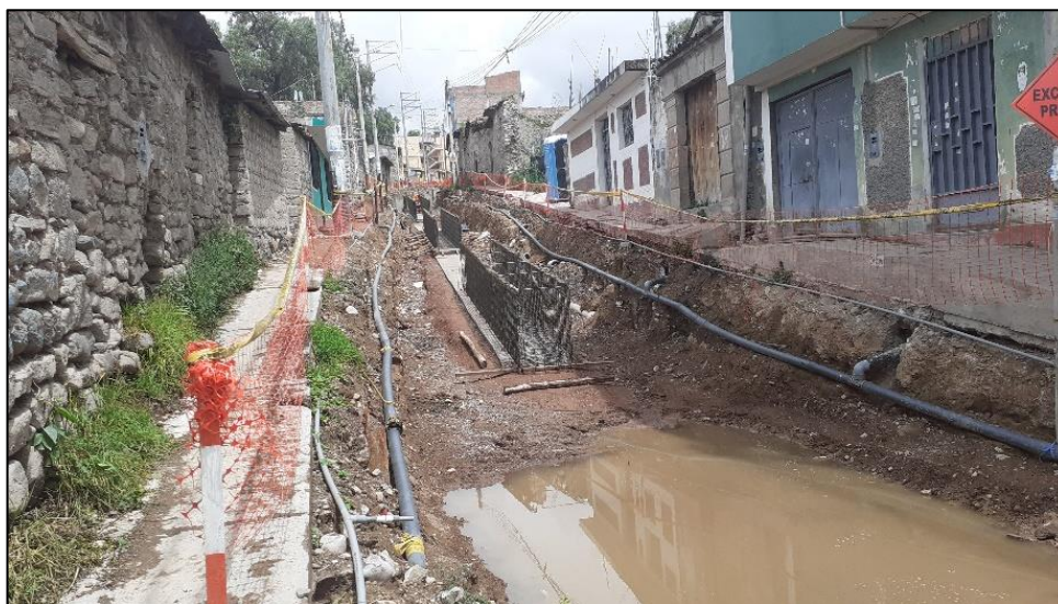
Figura 3.13 Construcción de la alcantarilla en el colector Cangalio
