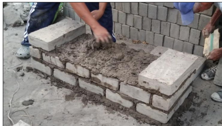
Figura N° 11: Proceso de elaboración del muro de adobe
