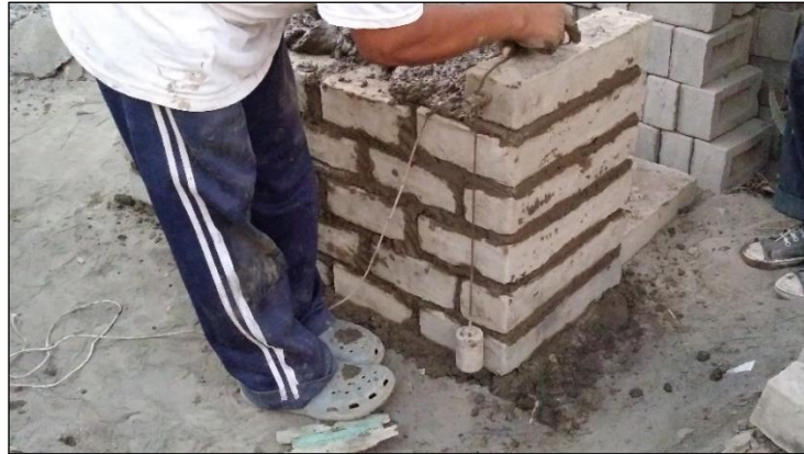
Figura N° 12: Controlando la verticalidad del muro de adobe Fuente: Elaboración propia
