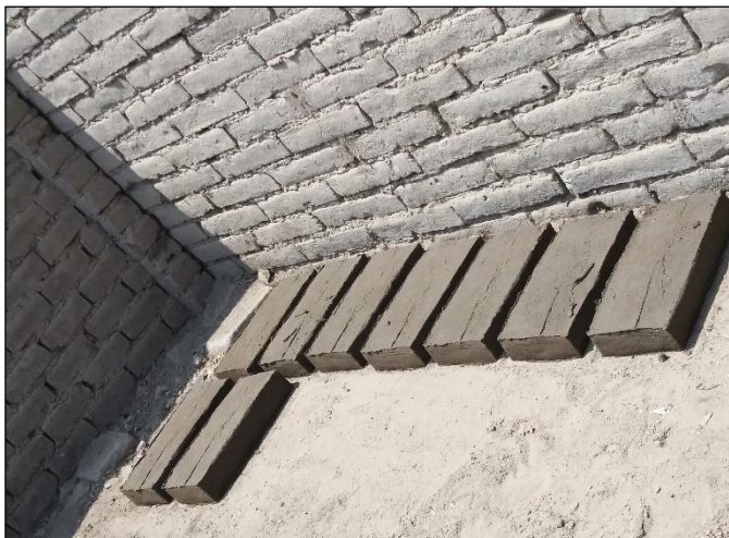
Figura N° 10: Adobes almacenados en un lugar seco y limpio Fuente: Elaboración propia
