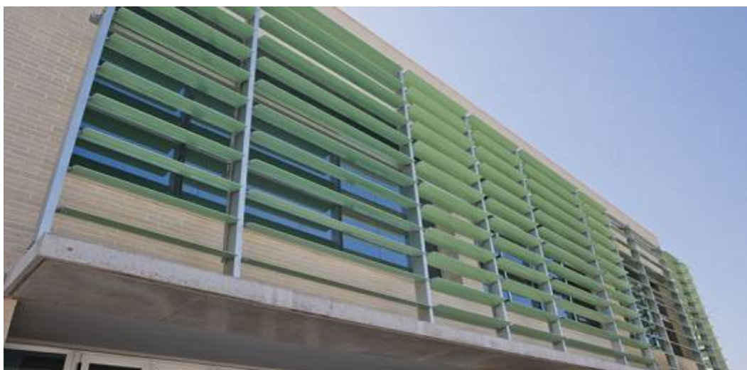
GRAFICO 119: Lama horizontal fija.
