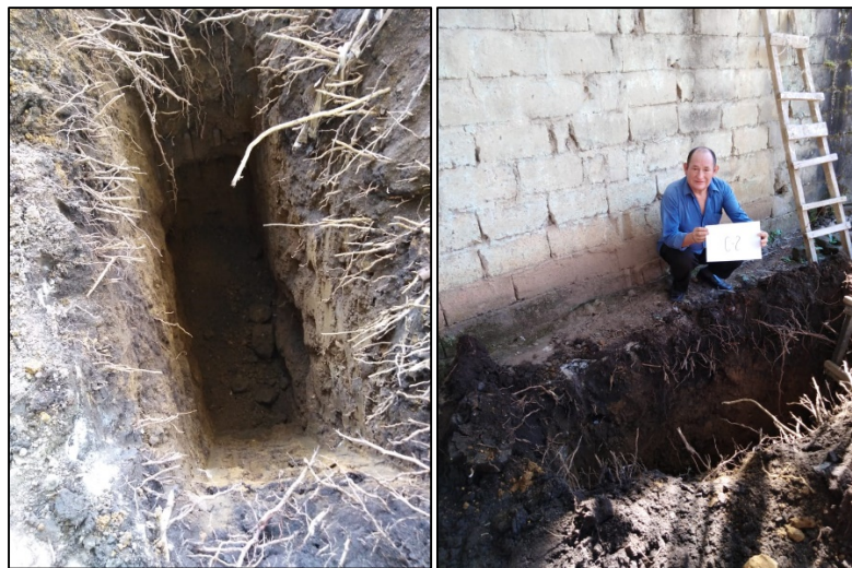
FIG. 04. Calicata N o 02 con Hprofundidad = 3.00 M.
