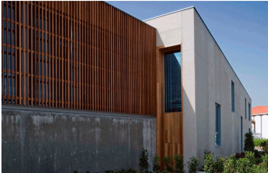
GRAFICO 123: Contraste entre materiales modernos y tradicionales. Lamas de madera fijas con estructura de concreto, vidrio y madera. Fuente: https://www.google.com/search?q=lamas+de+madera
