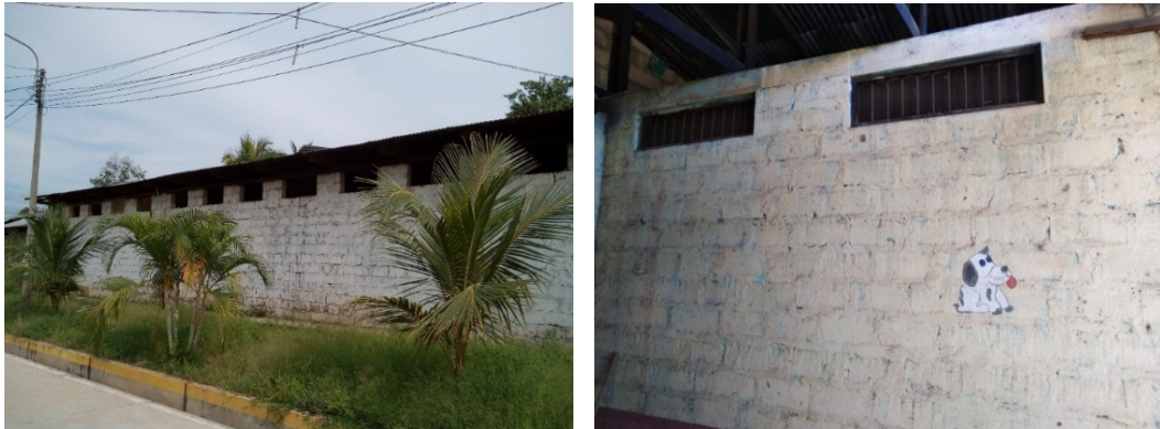
GRAFICO 81: Fachada Calle Carrera Oeste. A la derecha, depósito de materiales.
