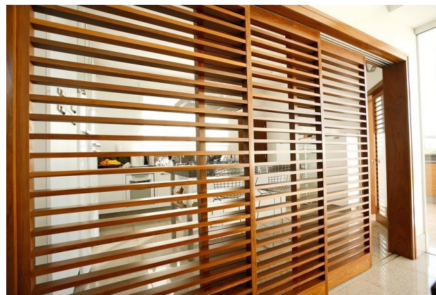
GRAFICO 122: Bastidor corredizo de lamas de madera fijas.
