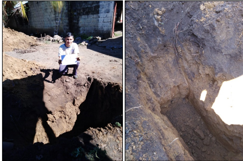
FIG. 03. Calicata N a 01 con Hprofundidad = 3.00 M.
