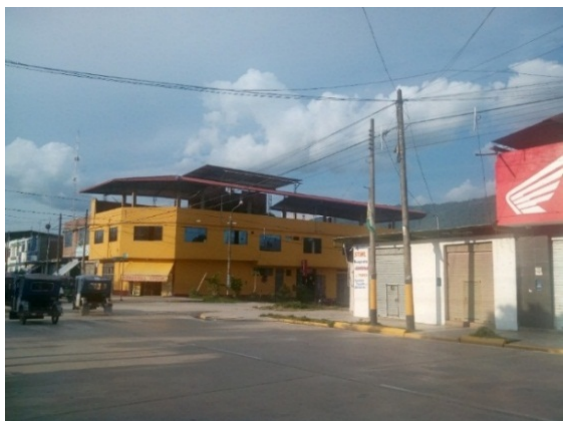
GRAFICO 108: Uso de coberturas de protección frente a las lluvias, en las azoteas.
