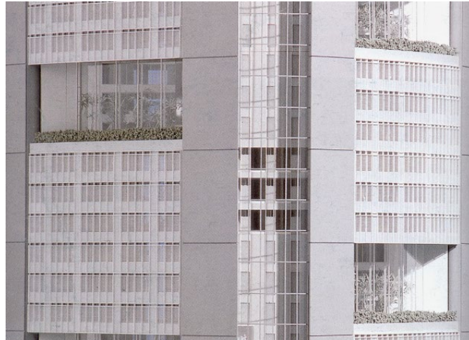
GRAFICO 79: Fachada del edificio.
