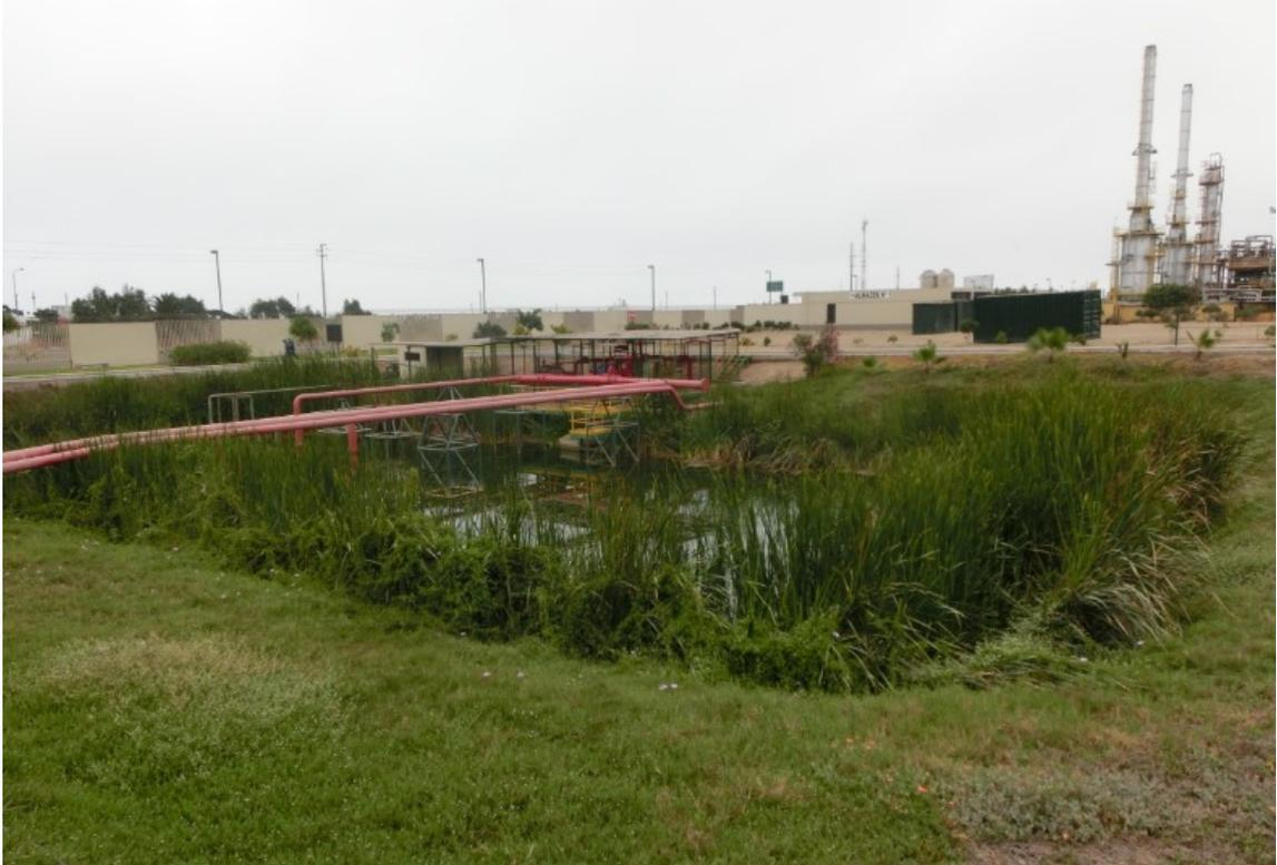
Nota: Foto registrada del sistema de captación de agua de la laguna, utilizado para el sistema contra incendio de la refinería. A la derecha se observa los hornos de destilación de hidrocarburos, de la planta de procesos de refinería Conchán.
