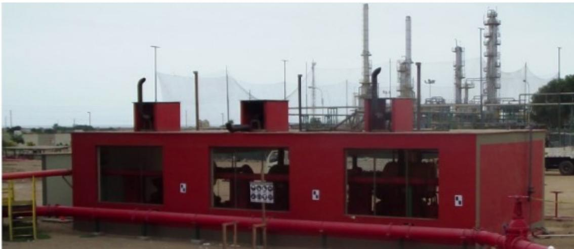
Así mismo, para mantener presurizado el sistema se cuenta con una electrobomba jockey, la cual mediante un sistema de control en base a un presóstato mantiene la presión del sistema en 150 psig. Se ha comprobado que la presión en el punto más alejado del sistema es de 70 psig, la cual constituye una pérdida de carga de más del 50% producto del desnivel mencionado previamente de 52.5m y de los accesorios que conforman el sistema tales como válvulas, codos, reducciones etc.
