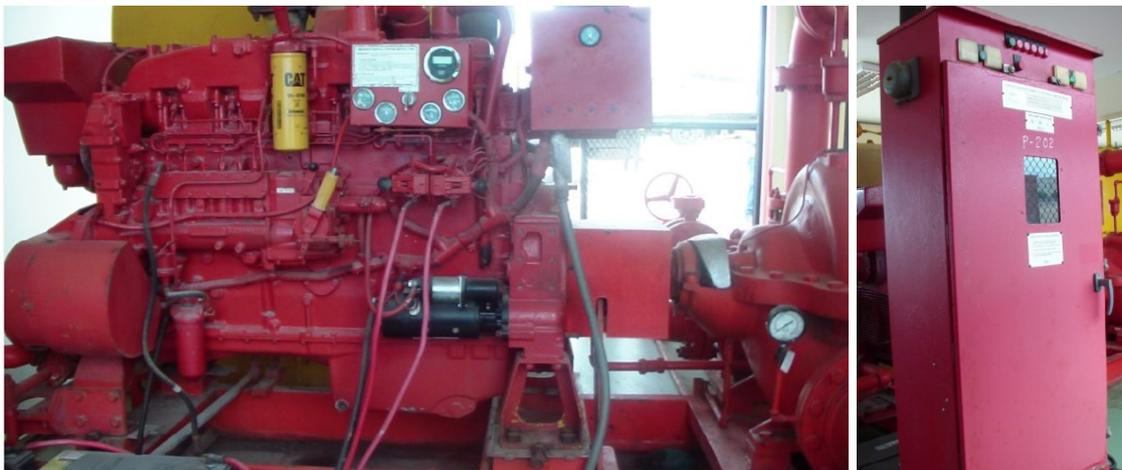
Para el control de la bomba jockey, se cuenta con un tablero controlador, el cual es activo por un presóstato ubicado a la salida de la bomba P-203, el cual detecta una caída de presión inferior a 125 psi, activando la bomba jockey cuando se llegue a este límite inferior.
