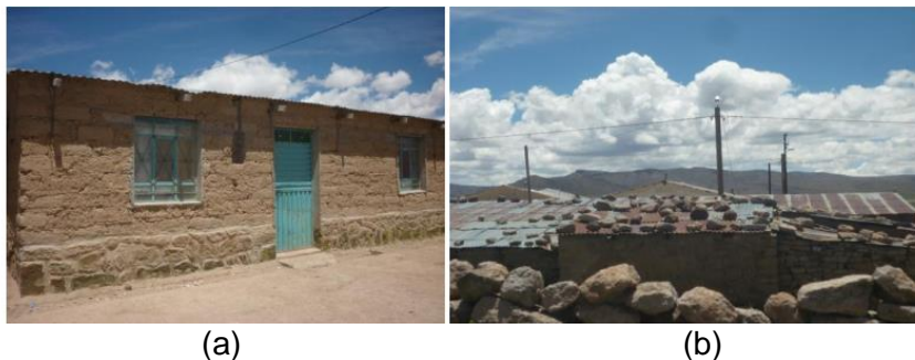
Figura 4. Vivienda típica en Imata (a) puerta de calamina y ventanas de vidrio con marco metálico, (b) techos de calamina [109].
