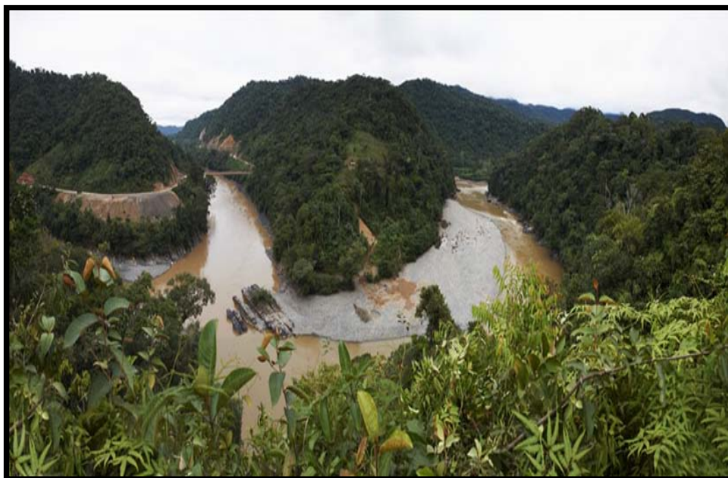
Figura 4.4 Confluencia de los ríos Inambari y Arazá, zona de construcción de la presa.
