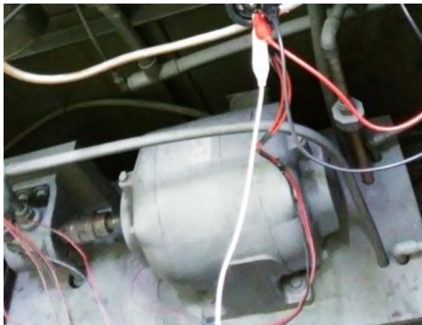
Figura 7: Bomba hidráulica en máquina de tracción
