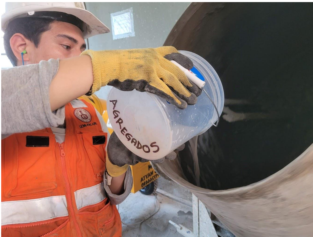
Adición de nitrato de calcio y bacterias a la mezcla de concreto.
