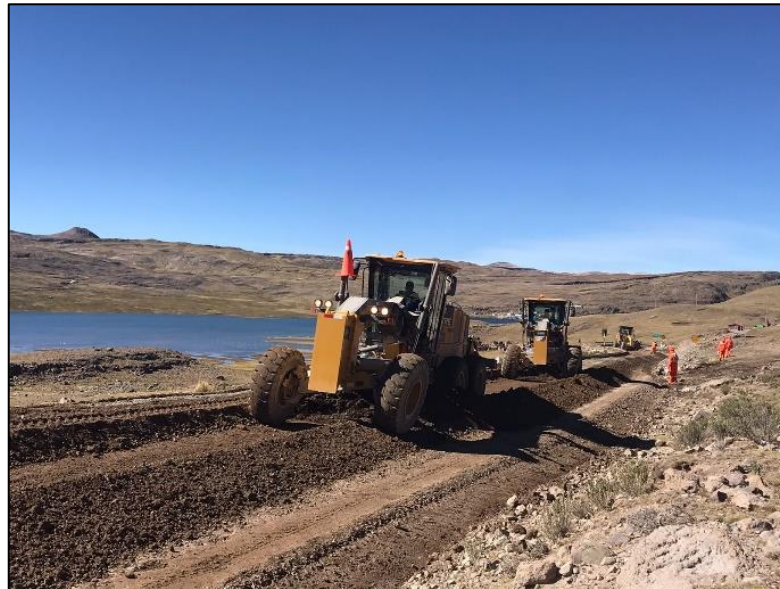
FIGURA N° 16.- Conformación de Base Estabilizada.
