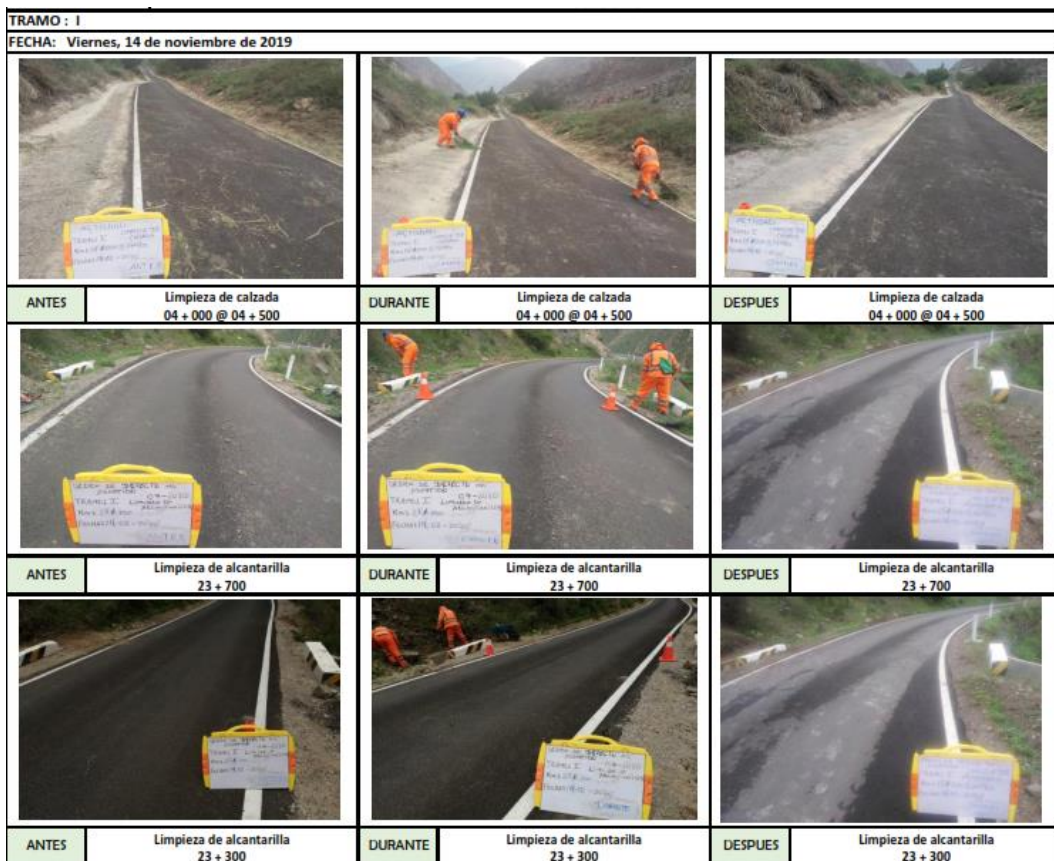
FIGURA N° 14.- Ejecución de las Actividades de la Conservación Rutinaria.
