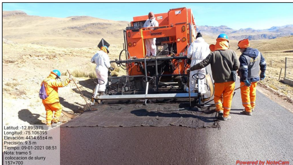
FIGURA N° 19.- Colocación de Slurry.
