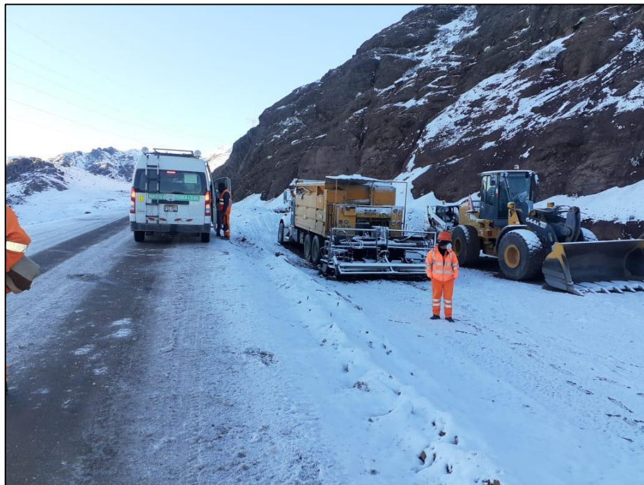
FIGURA N° 17.- Trabajos en Climas Extremas
