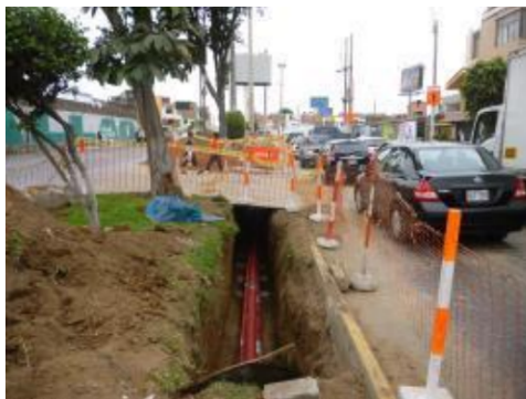
(a) Canalizado de línea de transmisión en Av. Insurgentes con Av. Benavides
