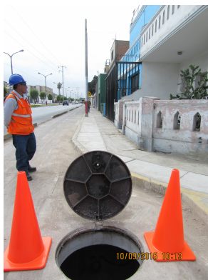
(a) Cámara construida en esquina de Av. Benavides con Psje. Arica
