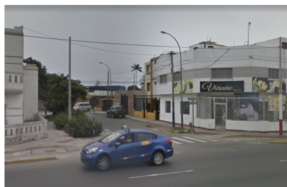
(b) Cámara construida y poste instalado en cruce de Av. Benavides con Psje. Arica
