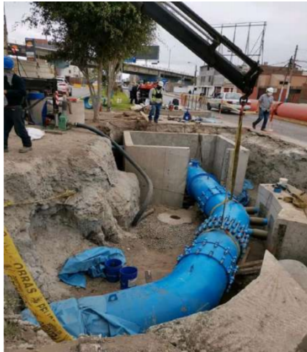
Figura N° 5.22: Empalme N°2 de agua potable red primaria Ø800mm, Av. Benavides alt. Jr. Grau Fuente: Panel fotográfico de Valorización N° 09
