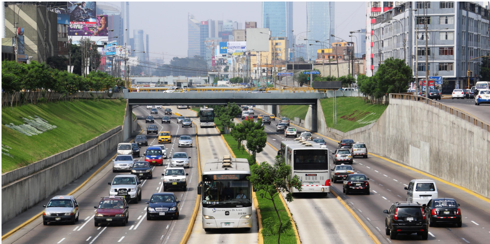
Figura N° 2.1: Metropolitano, Vía Expresa - Lima Fuente: Metropolitano (2022)
