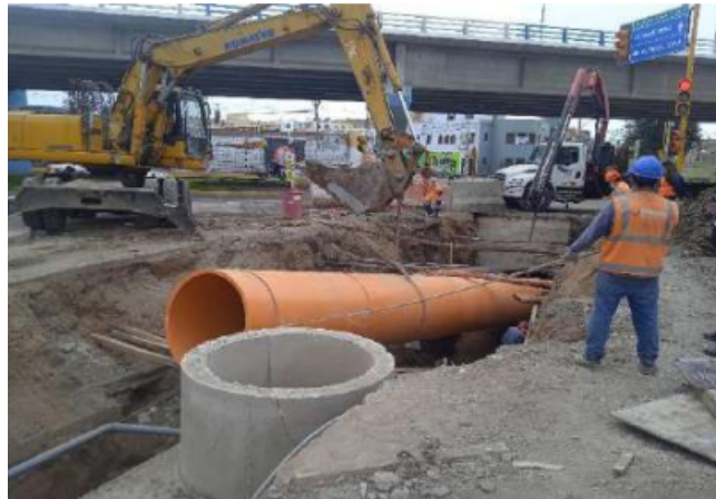
Figura N° 5.24: Bajado e instalación de tubería de alcantarillado de HDPE Ø1400mm en Av. Buenos Aires altura de Av. Guardia Chalaca
