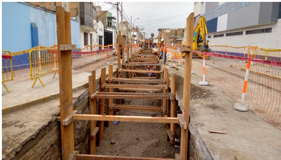
(b) Excavación e instalación de tubería de Alcantarillado de HDPE Ø1200mm en Av. Buenos Aires
