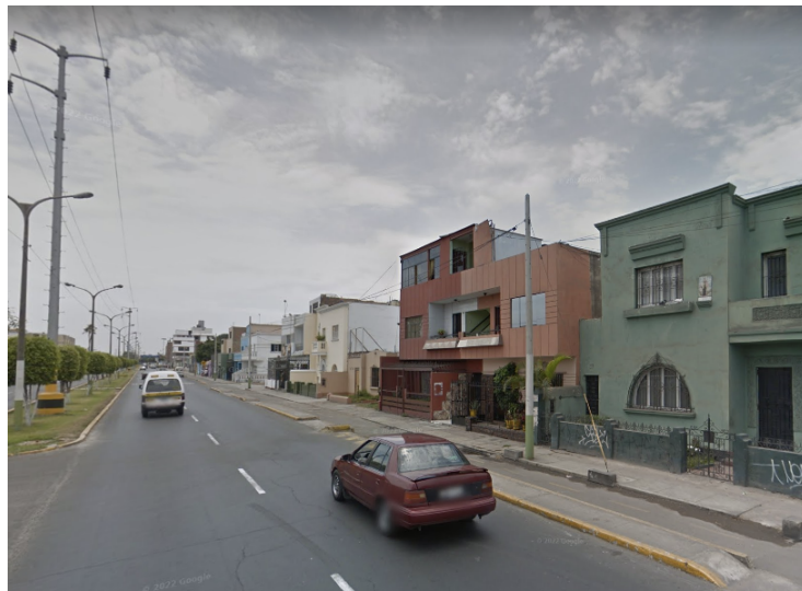
Figura N° 4.10: Poste de Claro identificado como Interferencia en la Av. Óscar R. Benavides Fuente: Captura de Google Street View, febrero del 2015
