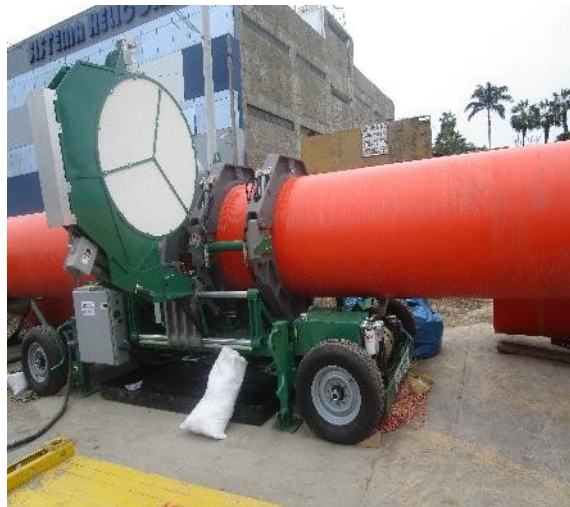
(a) Unión mediante proceso de termofusión de tubería HDPE Ø1200mm
