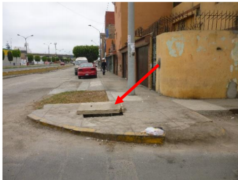
(a) Construcción de cámara de registro en esquina de Av. Benavides con Ca. 4
