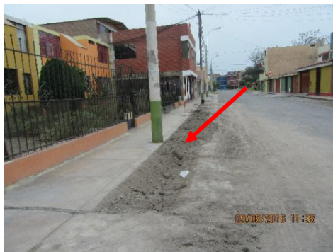
(a) Canalización por borde de vereda en Ca. 2
