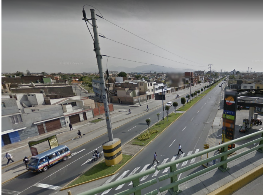
Figura N° 4.18: Línea de transmisión L-645, sector Av. Óscar R. Benavides Fuente: Captura de Google Street View de diciembre del 2014
