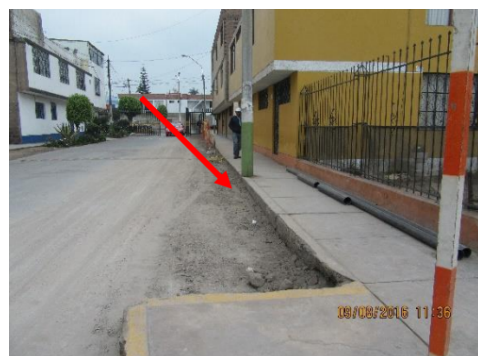
(b) Canalización por borde de vereda en Ca. 4
