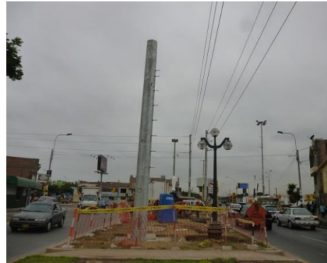
(b) Instalación de poste en Av. Insurgentes con Av. Benavides
