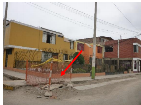
(b) Construcción de cámara de Registro en esquina de Ca. 4 con Ca. 2
