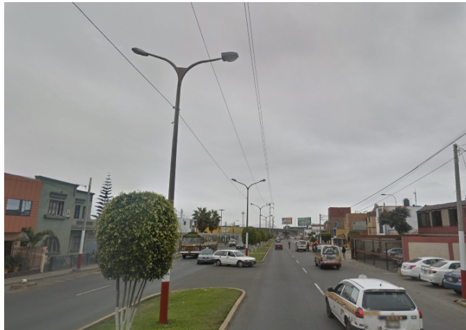
Figura N° 4.15: Redes existentes de propiedad de Viettel soportadas por postes de luz de Edelnor en Av. Óscar R. Benavides
