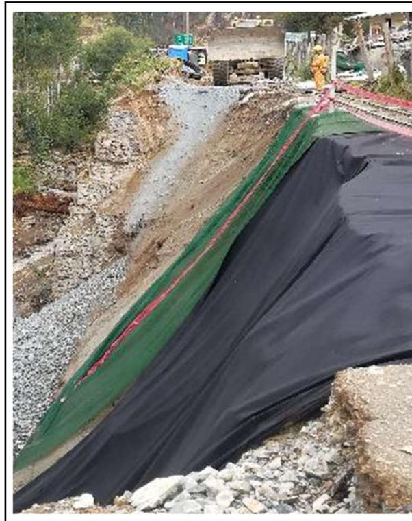
Figura N°5.4: Colocación de malla en talud para protección
