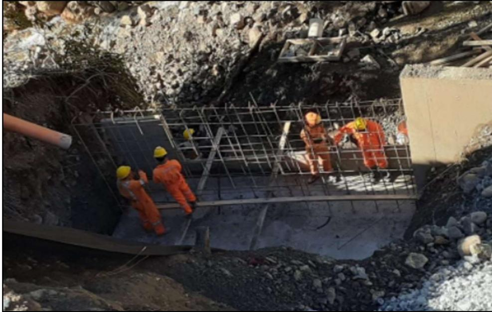
Figura N°5.8: Colocación de acero en zapata.
