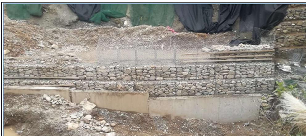
Figura N°5.20: Colocación de material rocoso en mallas de gavioneria - Terramesh
