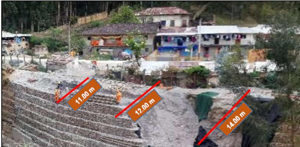
Figura N°5.25: Ancho de material de relleno según perfil
