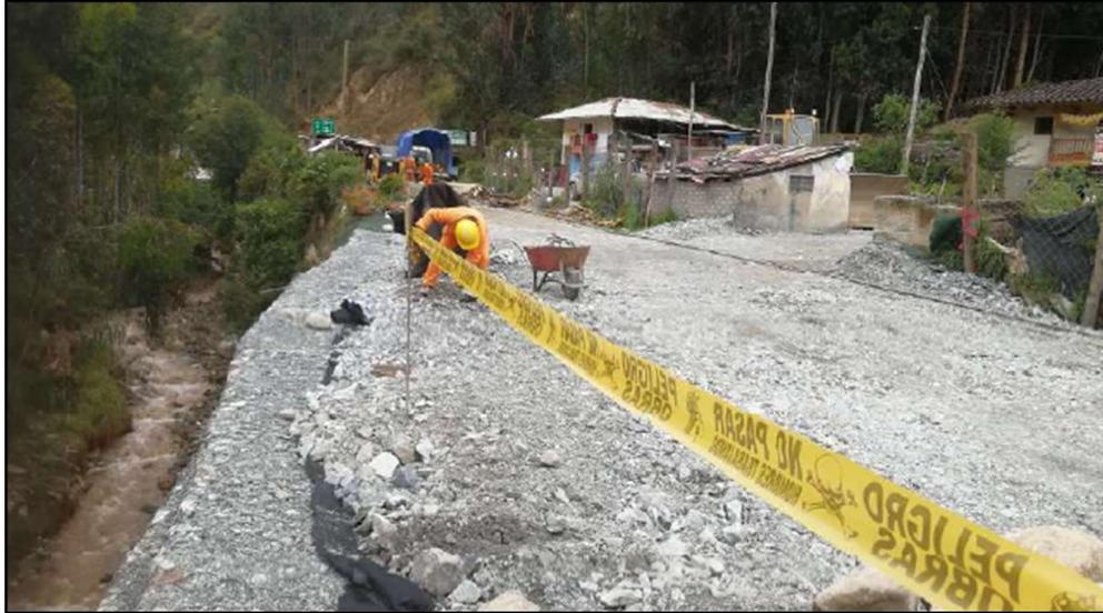
Figura N°7.5: Colocación de cinta de seguridad.
