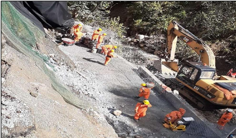
Figura N°5.17: Relleno y compactación de material
