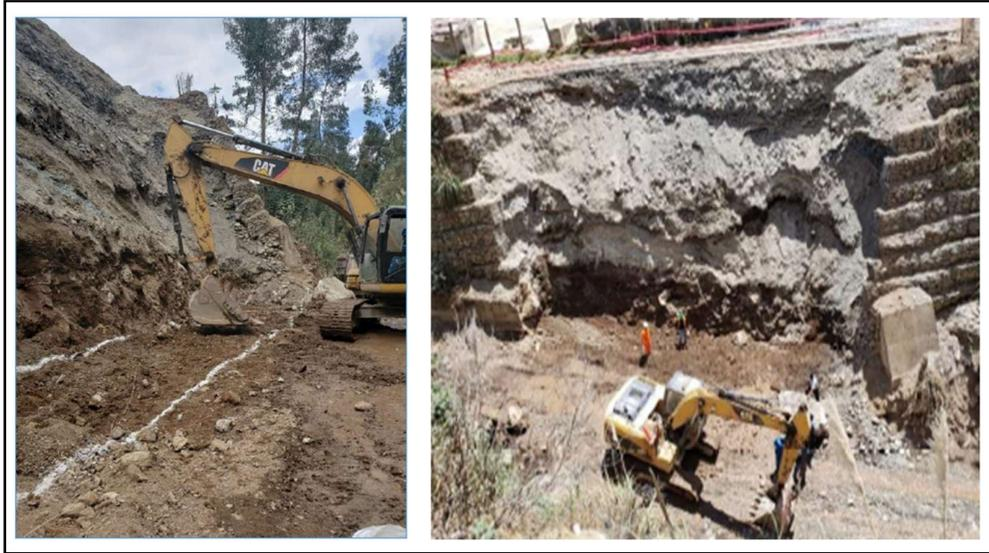
Figura N°5.3: Corte y excavación masiva con equipo
