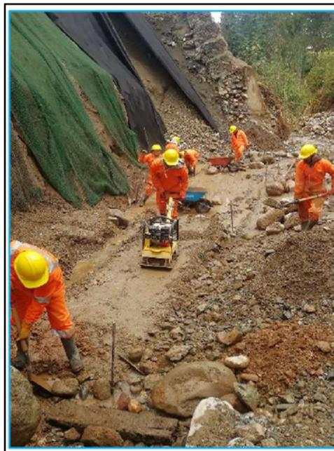
Figura N°5.5: Compactación de base para zapatas
