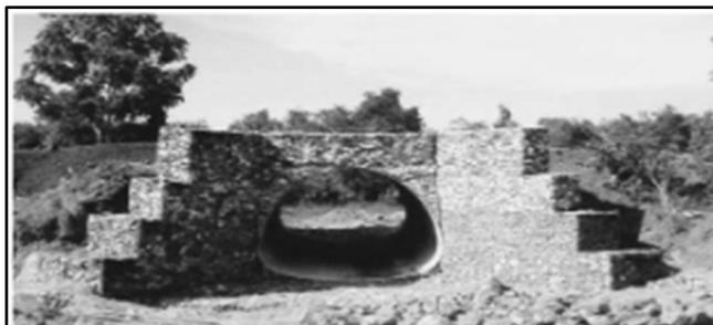
Figura N°2.6: Muro de gaviones en alcantarilla.
