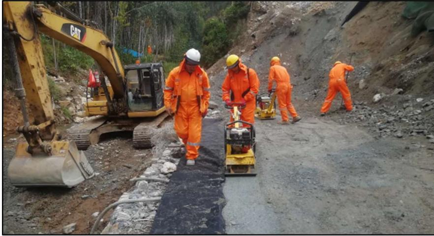
Figura N°5.21: Colocación de geotextil, relleno y compactación de material.
