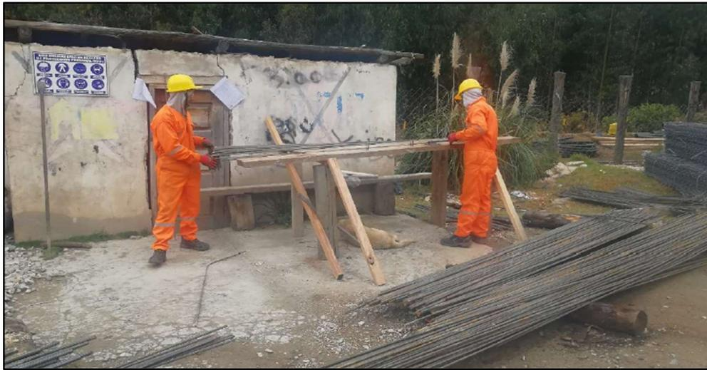
Figura N°5.6: Habilitado de acero vertical
