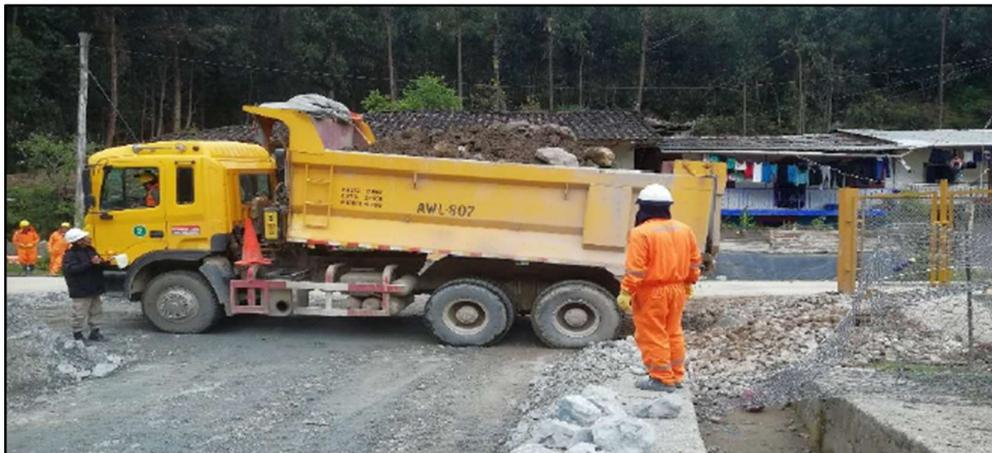
Figura N°5.19: Traslado de material rocoso a obra.
