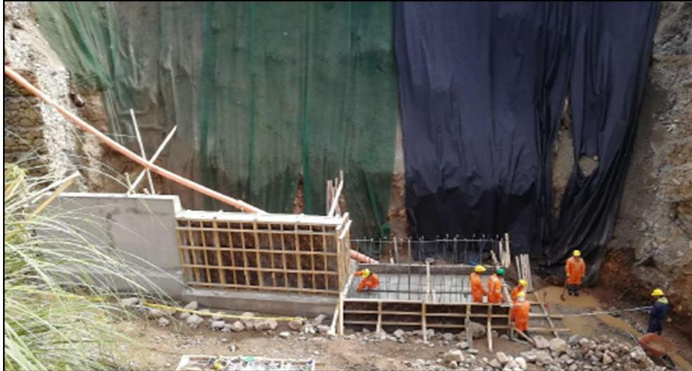
Figura N°5.12: Encofrado de muro – Paño 03
