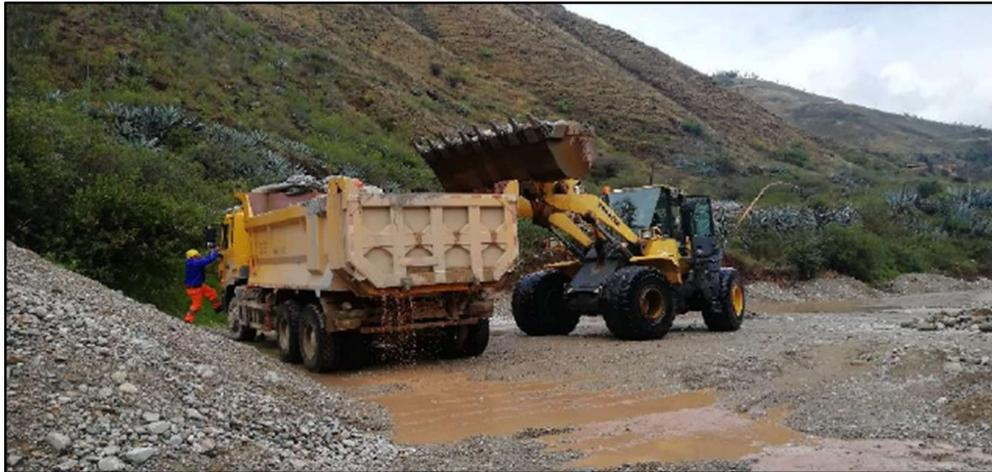
Figura N°5.18: Carguío de material rocoso para gavioneria desde cantera.
