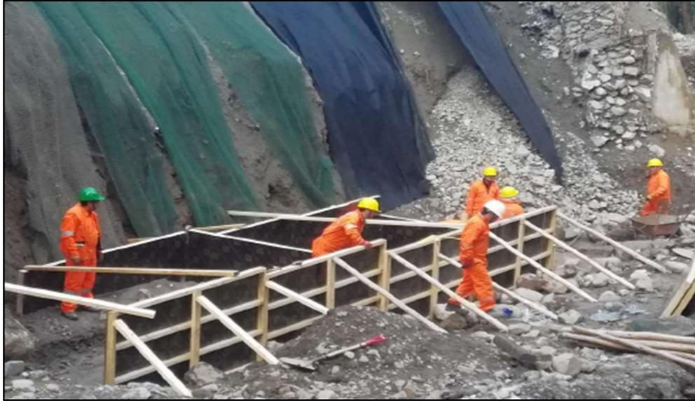
Figura N°5.10: Encofrado de zapata – Paño 02
