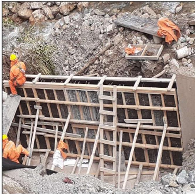
Figura N°5.11: Encofrado de muro – Paño 02
