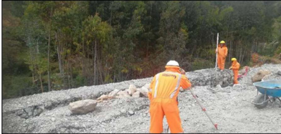
Figura N°5.1: Trazo y replanteo de obra
