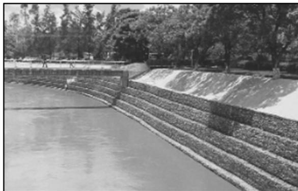
Figura N°2.2: Muro de gaviones longitudinal con escalones externos
