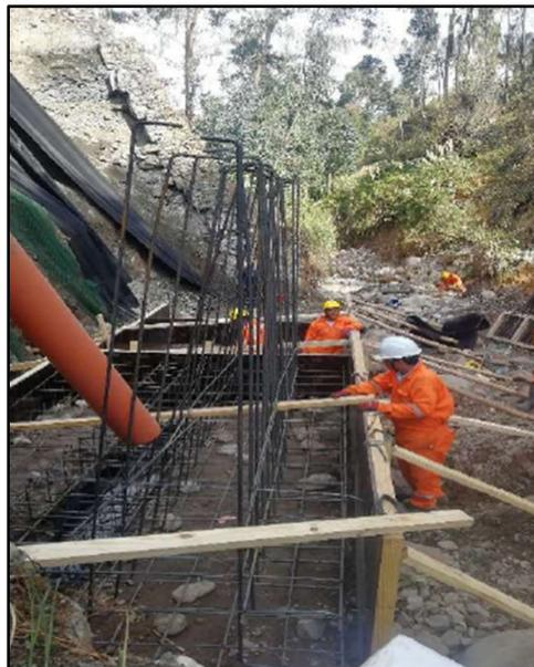
Figura N°5.9: Encofrado de zapata – Paño 01
