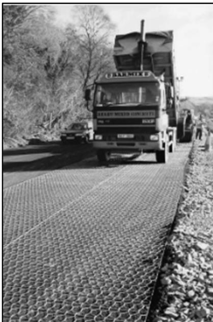
Figura N°2.7: Malla doble torsión reforzada en pavimentos.
