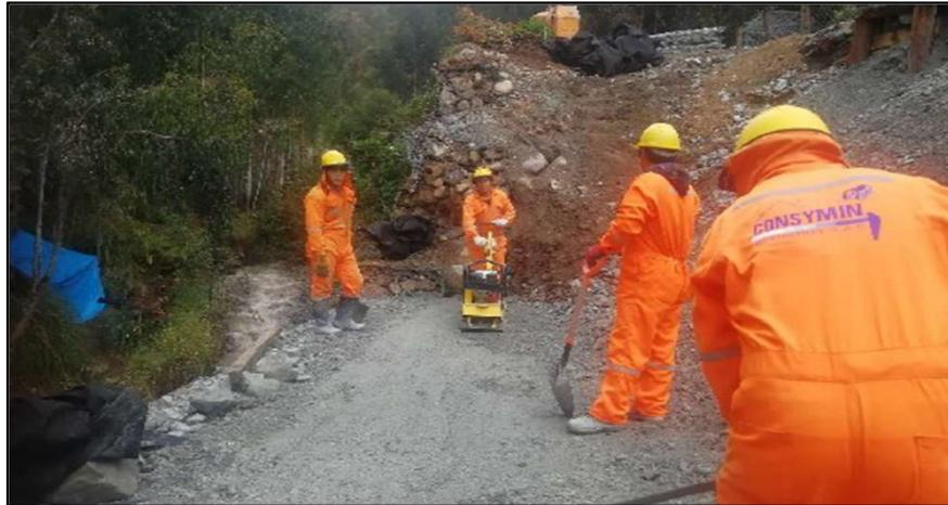
Figura N°5.22: Nivelación y compactación de material de relleno.
