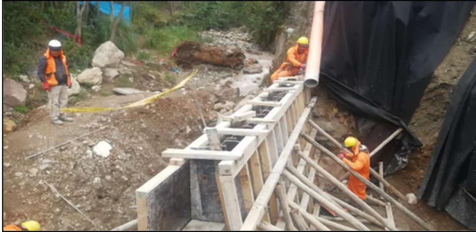
Figura N°5.14: Concreto en muro – Paño 01 – Vista inferior
