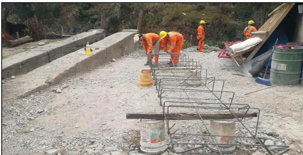
Figura N°5.7: Habilitado de acero para estribos
