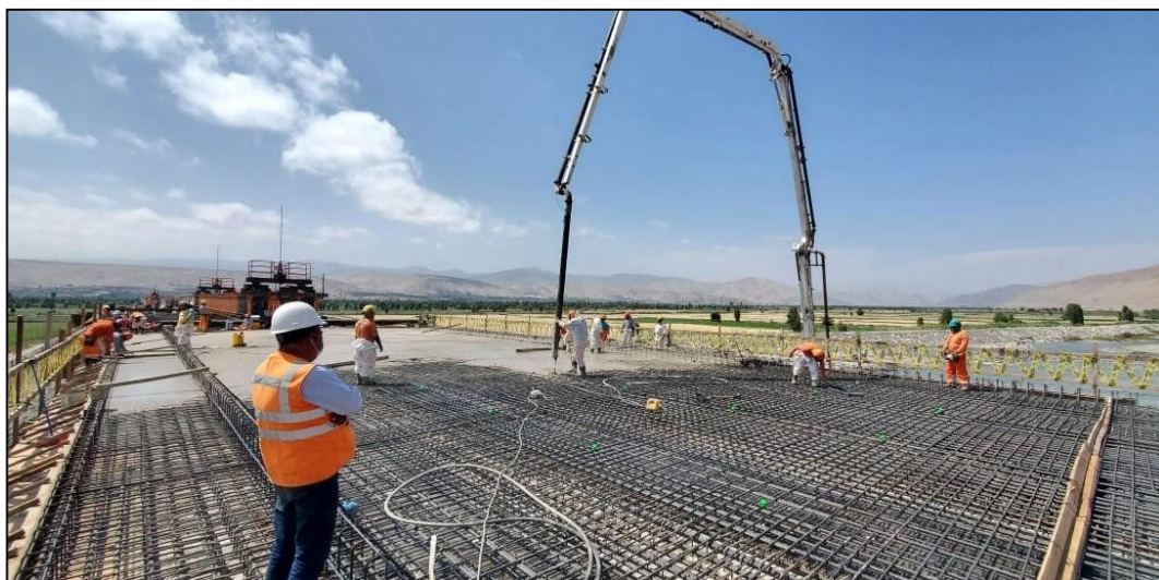
Figura N°3.11 Vertido de concreto f'c 280kg/cm 2 en losa de tablero central
