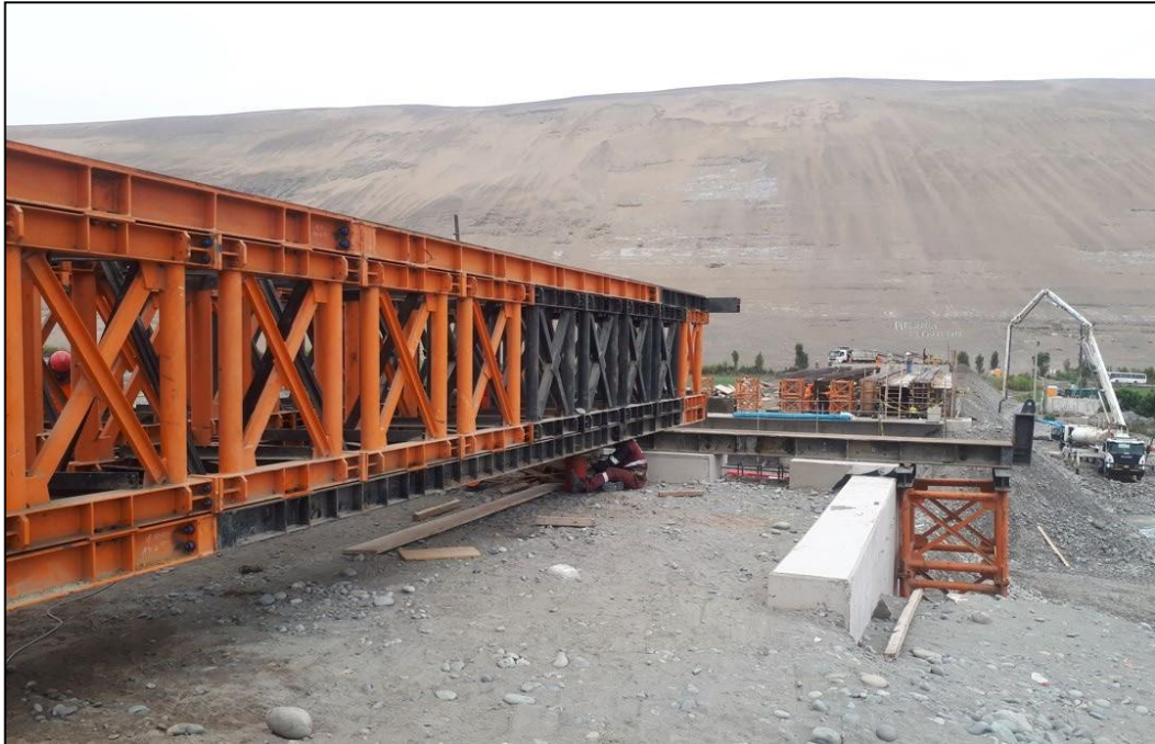
Viga lanzadora sobre torres de apeo centrales.
