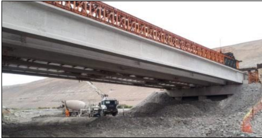
Figura N°5.5 Termino del izaje de 6 vigas VP-1 del tramo derecho.
