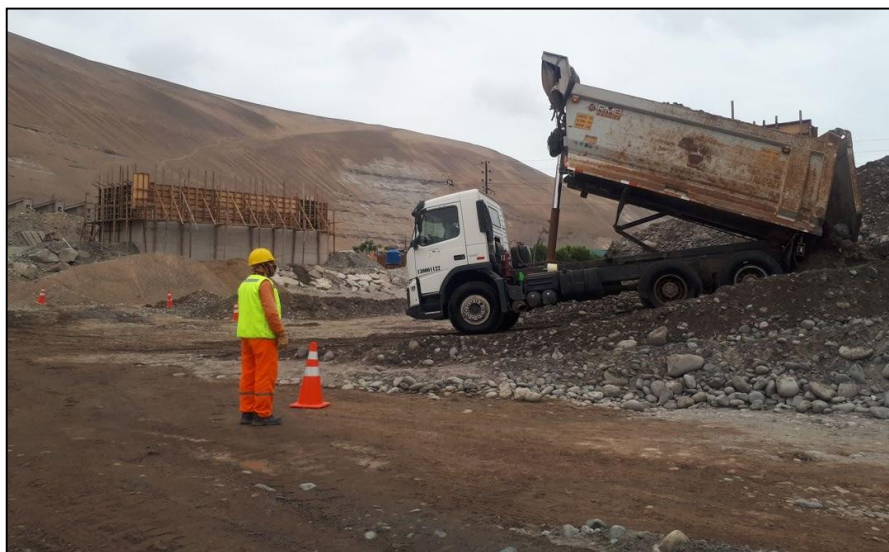
Acopio de material de relleno entre pilares.
