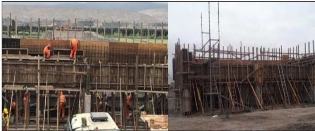
Encofrado de zapata y colocación de acero en columnas del Pilar
