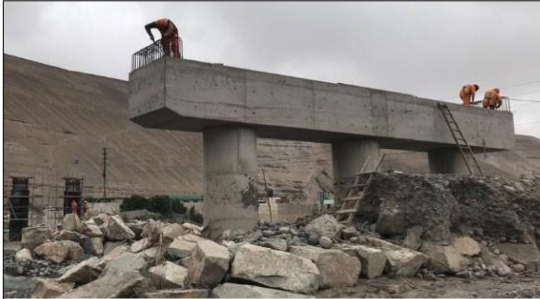
Figura N°3.7 Construcción de viga cabezal en Pilares
