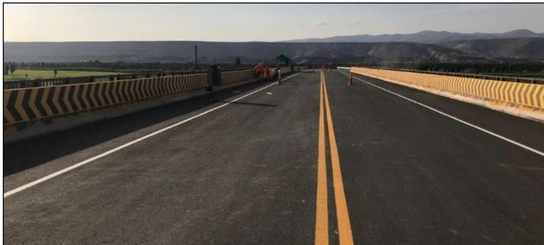
Figura N°3.12 Marcas en el pavimento y pintado de muros New Jersey
