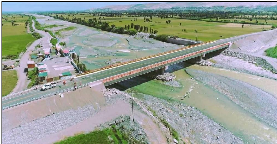
Figura N°3.13 Panorámica del puente Freyre concluido
