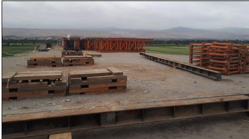
Viga Lanzadora sobre el relleno estructural del estribo derecho
