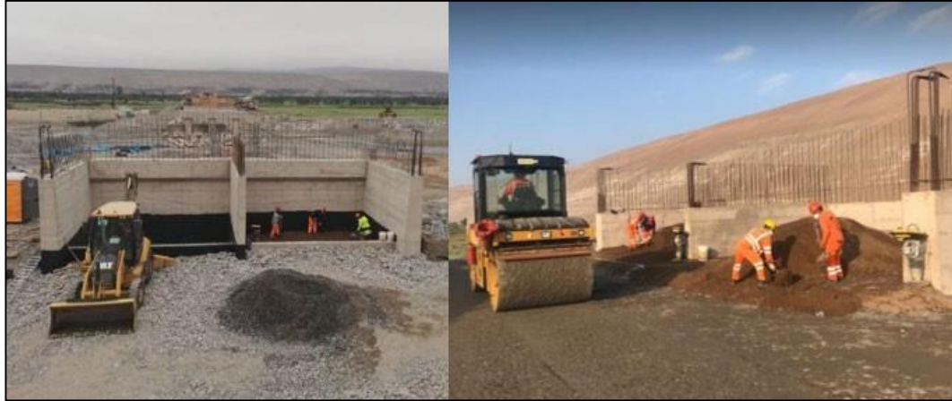
Encofrado de 3ra etapa en Estribos
