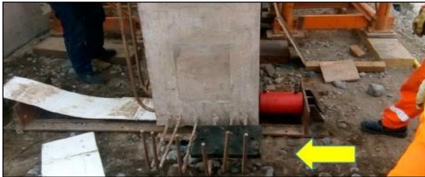
Transporte y desplazamiento de la 5ta viga
