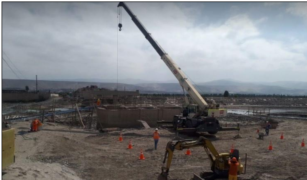
Figura N°3.4 Miniexcavadora y grúa listas para el Hincado de Caisson
