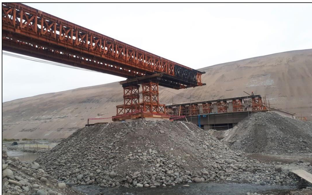
Viga lanzadora sobre torres de apeo centrales.
