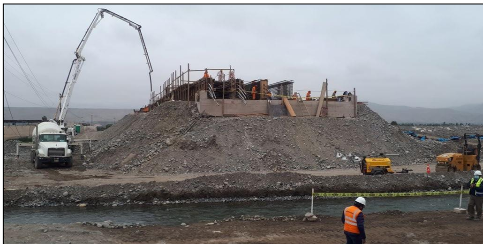
Figura N°5.6 Vertido de concreto f'c 490 kg/cm 2 en vigas VP-2
