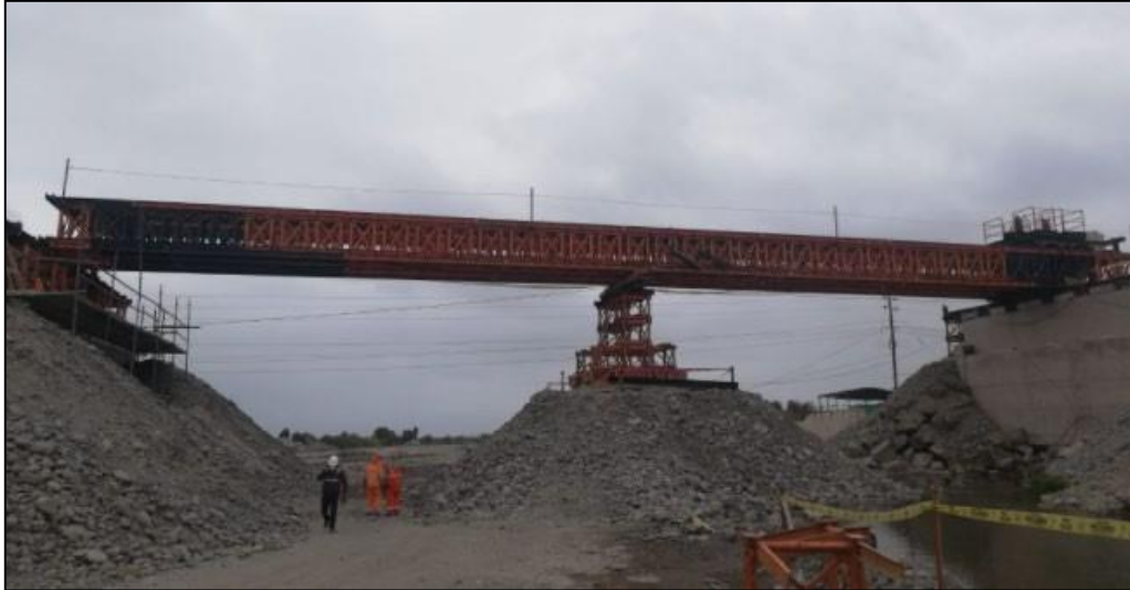
Levantamiento de viga de concreto postensado.
