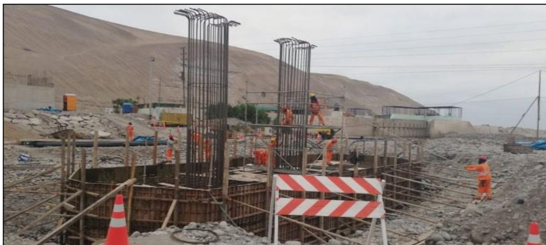
Encofrado de zapata y colocación de acero en columnas del Pilar
