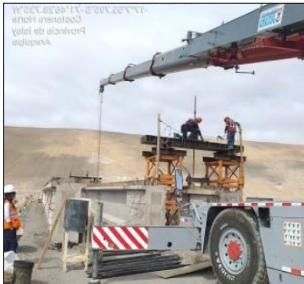
Levantamiento de viga de concreto postensado.
