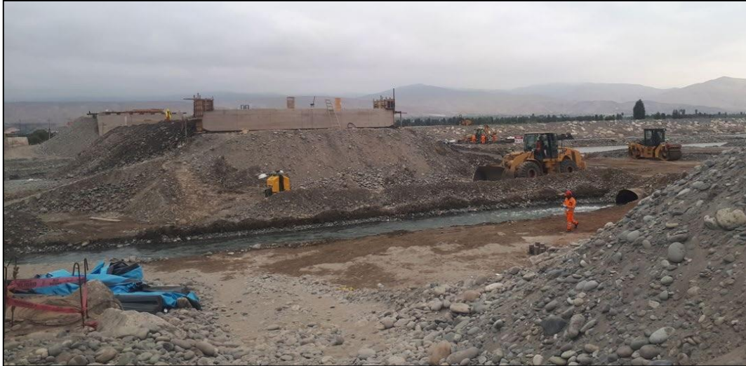
Acopio de material de relleno entre pilares.
