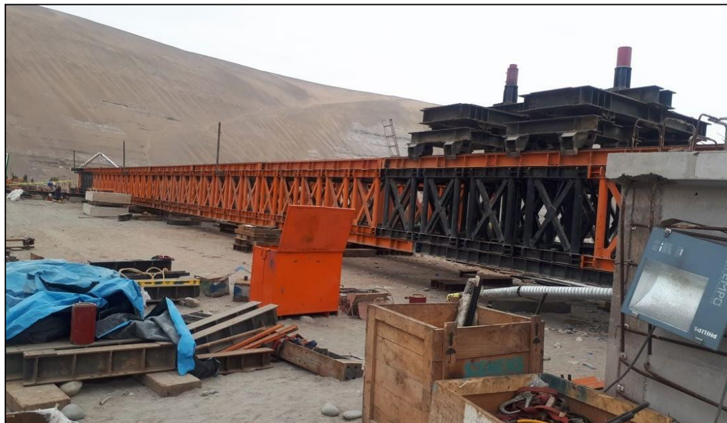
Viga Lanzadora sobre el relleno estructural del estribo derecho
