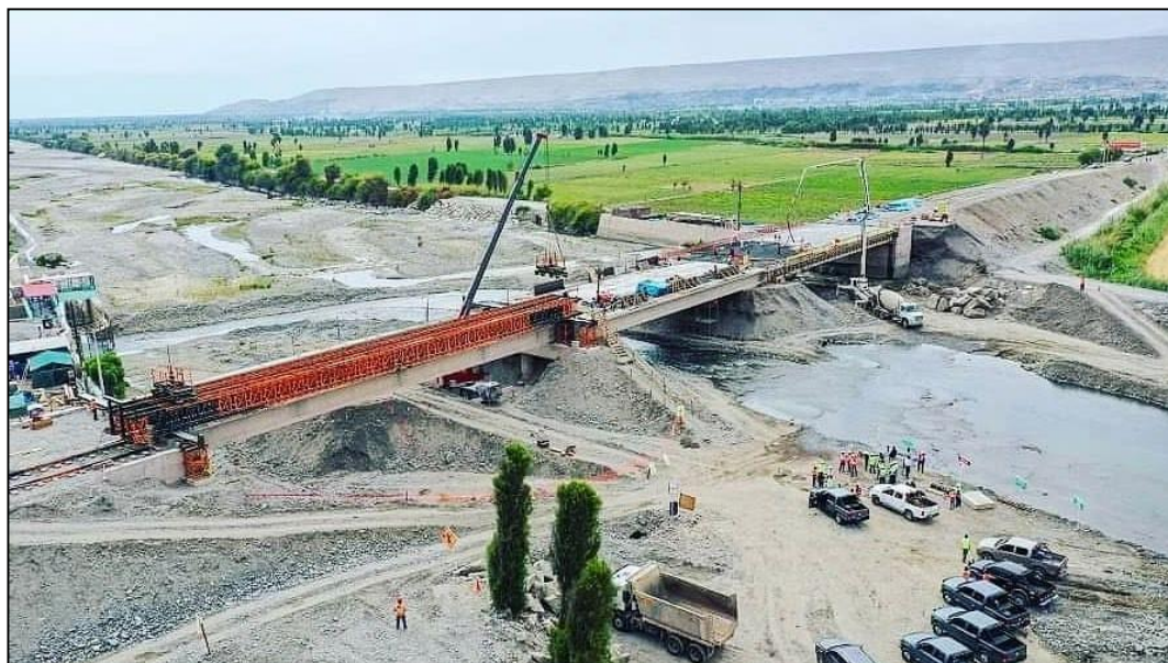
Figura N°3.10 Ejecución del Puente Freyre
