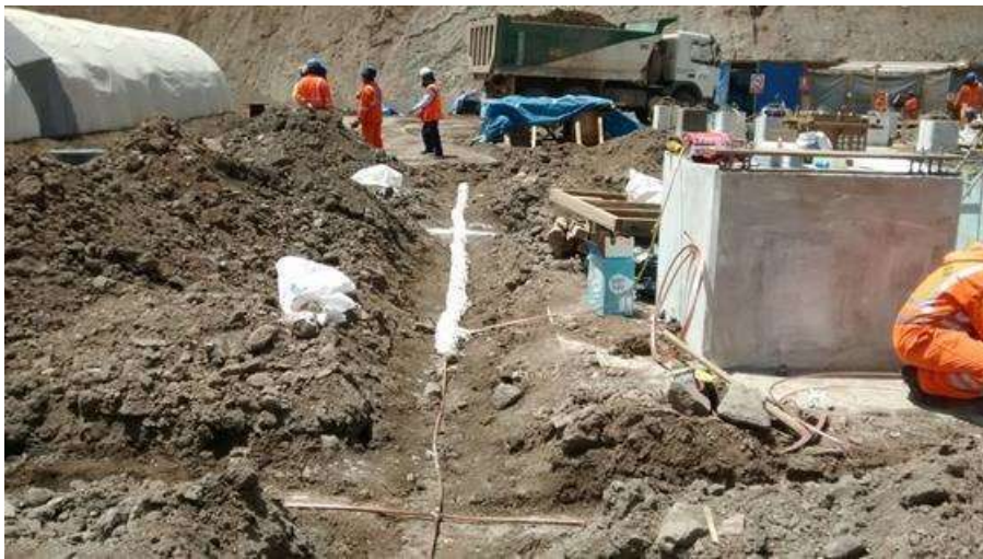
Imagen 6: Instalación de malla a tierra en patio de llaves.
