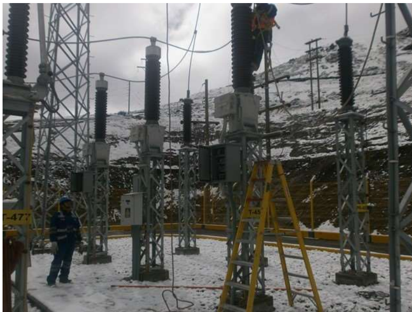
Imagen 14: Montaje de equipos electromecánicos en patio de llaves
