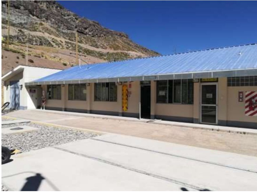
Imagen 21: Sala de control Trabajo – vista frontal
