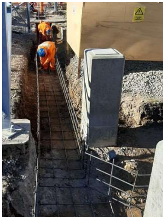
Imagen 12: Colocación de acero de refuerzo para canaletas en patio de llaves.
