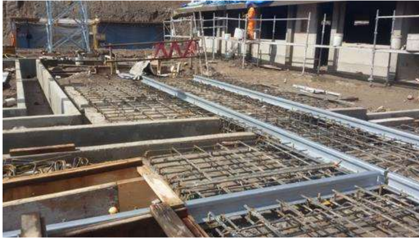
Imagen 13: Disposición de rieles para transporte de Transformador de potencia
