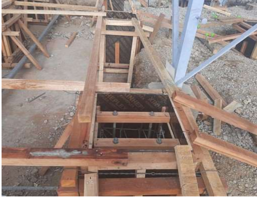
Imagen 11: Encofrado de Pedestales, se aprecia el alineamiento y aseguramiento de pernos de anclaje para ser embebidos en el vaciado de concreto de primera etapa. Se deberá de tener en cuenta la cota de nivel superior del perno, así como la distancia entre ellos.
