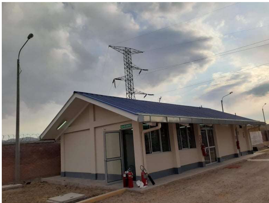
Imagen 22: Sala de control Trabajo – vista lateral
