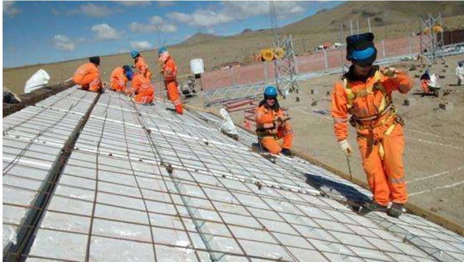
Imagen 3: Construcción de losa aligerada, colocación de acero de temperatura.
