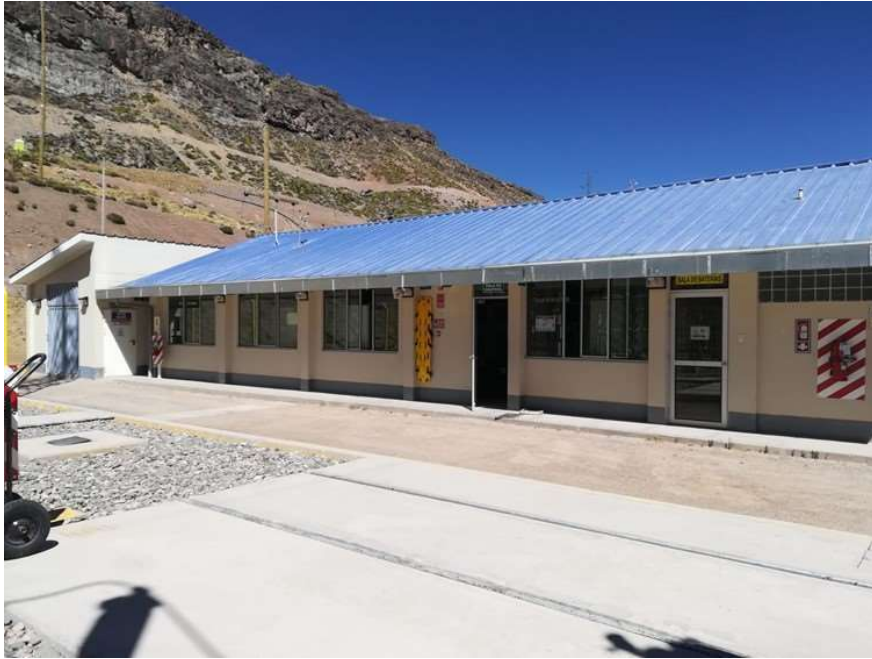
Imagen 15: Vista principal de frontis de sala de control
