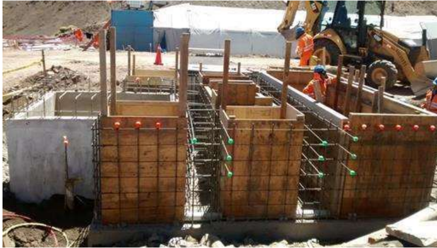
Imagen 5: Transformador de potencia, encofrado de poza de contención de aceite.
