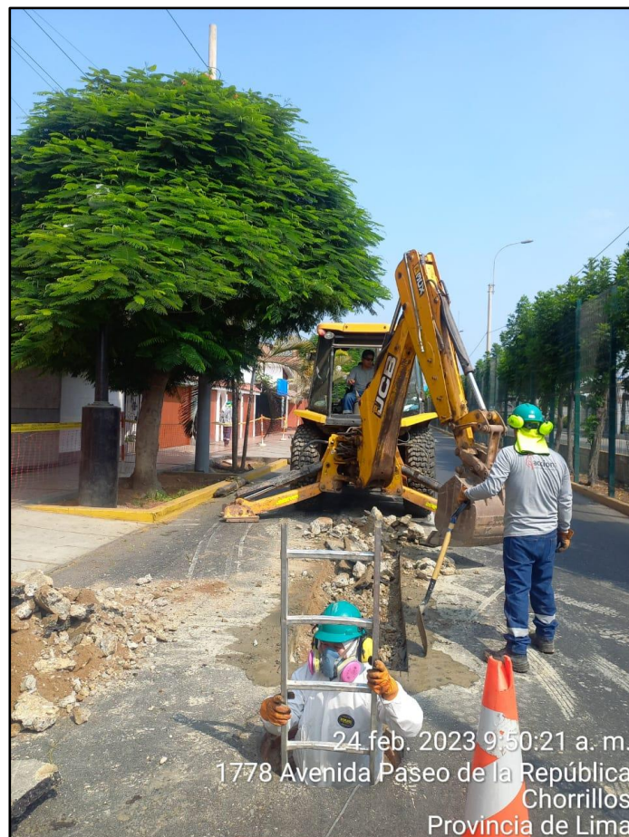
Excavación de ventana de lanzamiento
