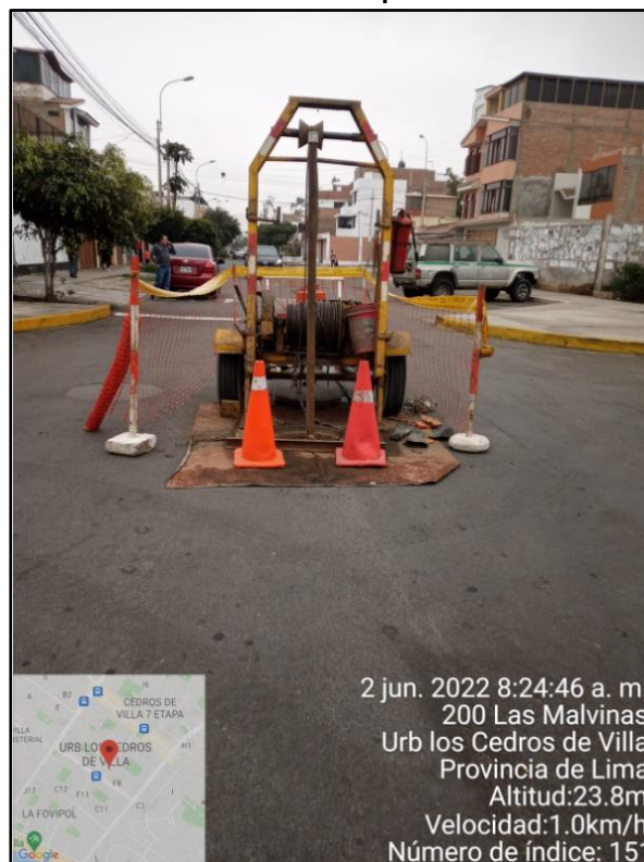
Instalación de la máquina de balde
