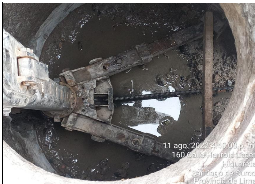
Instalación del Winche
