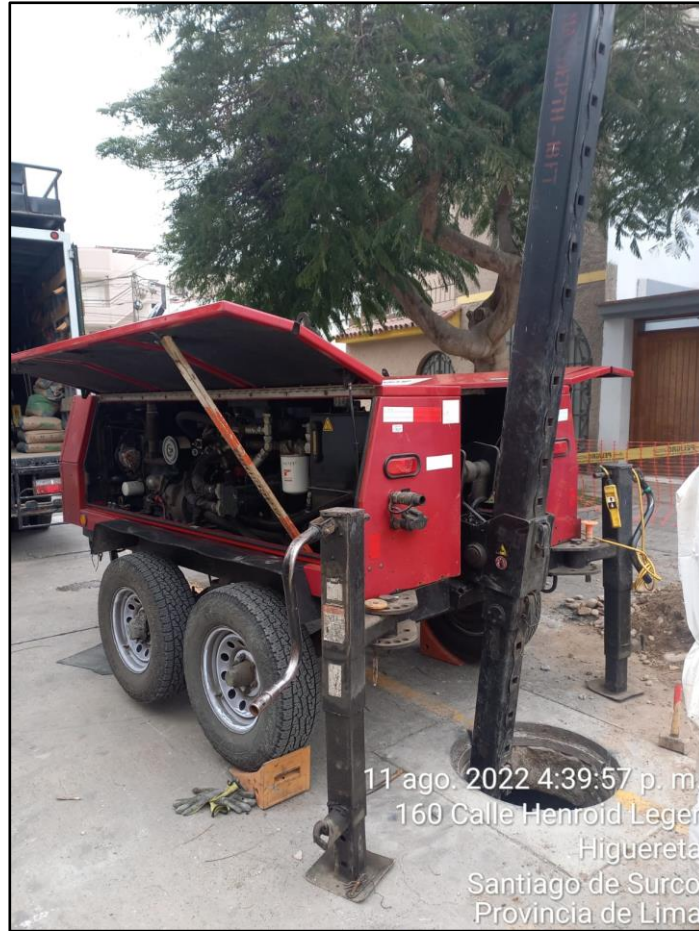
Instalación del Winche
