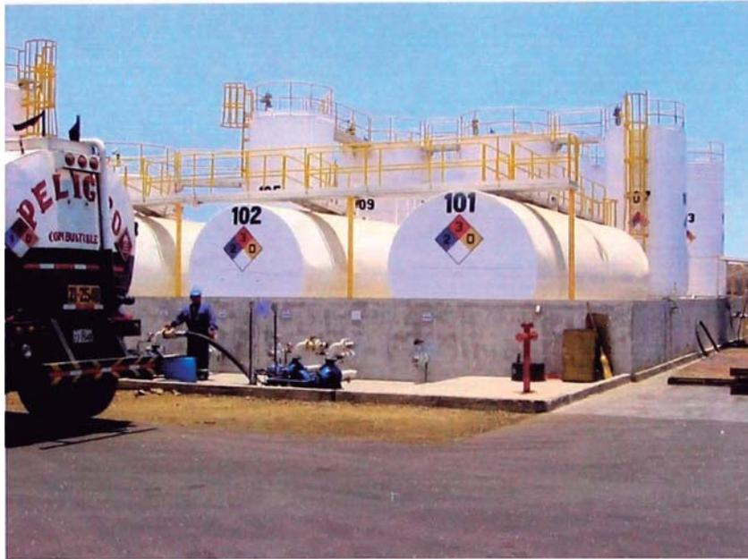
*Figura N° 12: Descarga Cisterna a Tanques de Almacenamiento*
