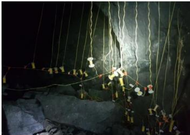
Detonadores electrónicos instalados
