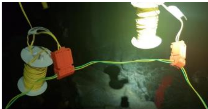
Amarre de detonadores electrónicos
