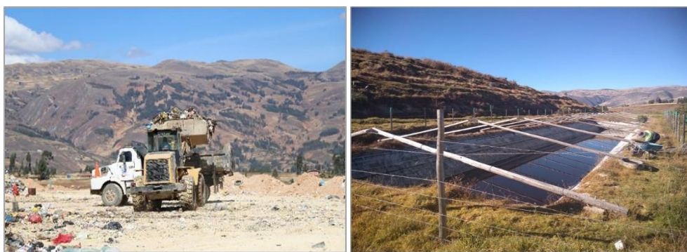
Figura 7: Celda de disposición final de residuos sólidos municipales y poza de lixiviados en el relleno sanitario de Cajamarca
