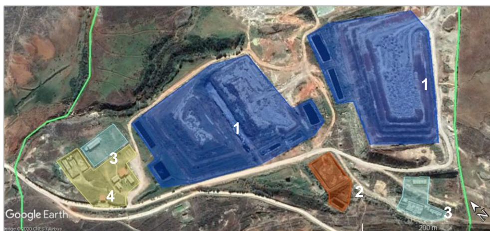
Figura 6: Instalaciones en el relleno sanitario de Cajamarca
