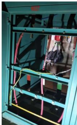
Reconexión del cable 2.3 kV
