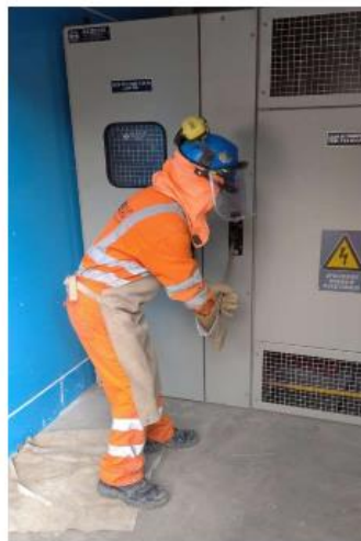
Energización de celda de llegada 2.3 kV
