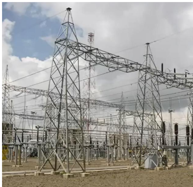
Figura 5.23 Barraje flexible de AAC Fuente: [Elaboración propia]
