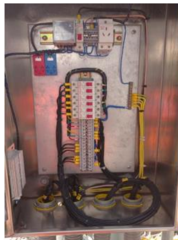
CONEXIONADO DE LA CAJA DE AGRUPAMIENTO CONCLUIDO
