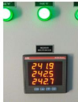
MEDICIÓN INICIAL DE LA TENSIÓN FASE-NEUTRO
