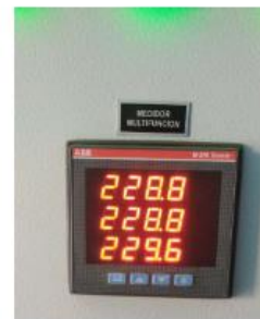
MEDICIÓN FINAL DE LA TENSIÓN FASE-NEUTRO
