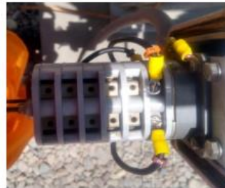
CONEXIONADO DE CABLE DE CONTROL AL SL CONCLUIDO
