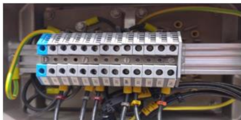
IDENTIFICACIÓN DE TERMINALES SECUNDARIOS DEL TC
