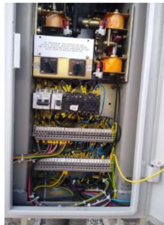
CONEXIONADO DE CABLES DE CONTROL Y ENERGÍA CONCLUIDOS
