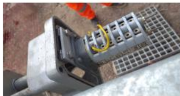
IDENTIFICACIÓN DE CONTACTOS AUXILIARES DEL SPT
