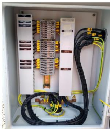
CONEXIONADO DE LA CAJA DE AGRUPAMIENTO CONCLUIDO
