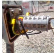
CONEXIONADO DE CABLE DE CONTROL AL SPT CONCLUIDO
