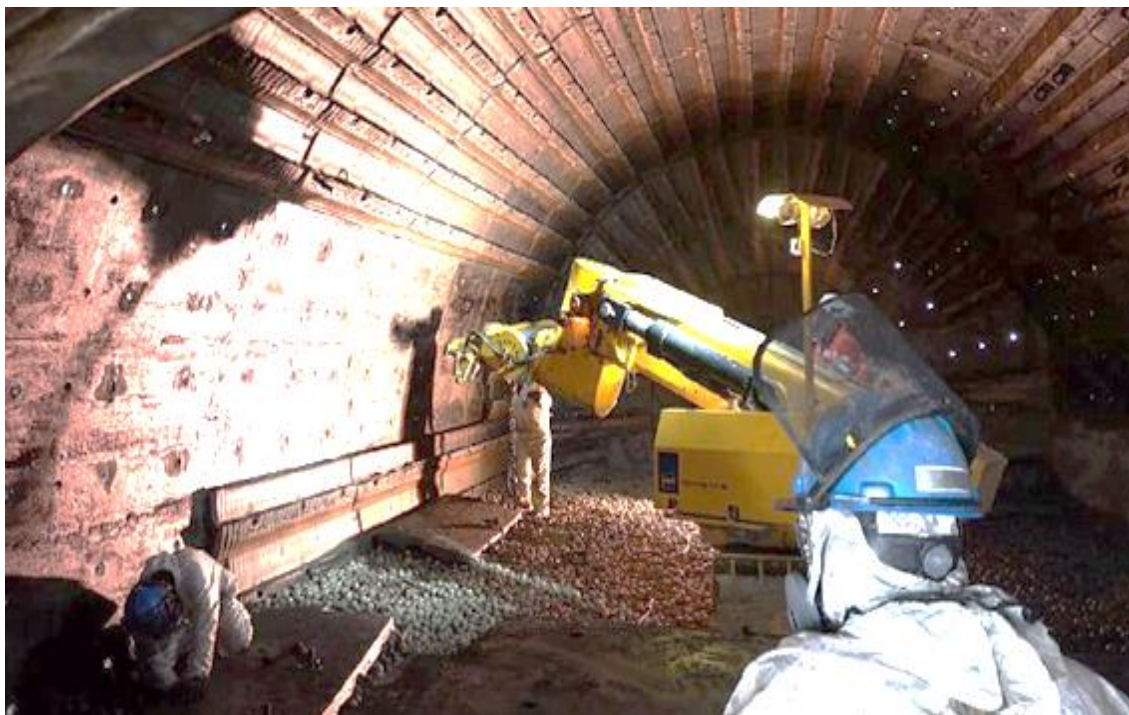
Figura N°62: Maquina enlainadora marca brokk 160, usado en el recubrimiento de liners.
