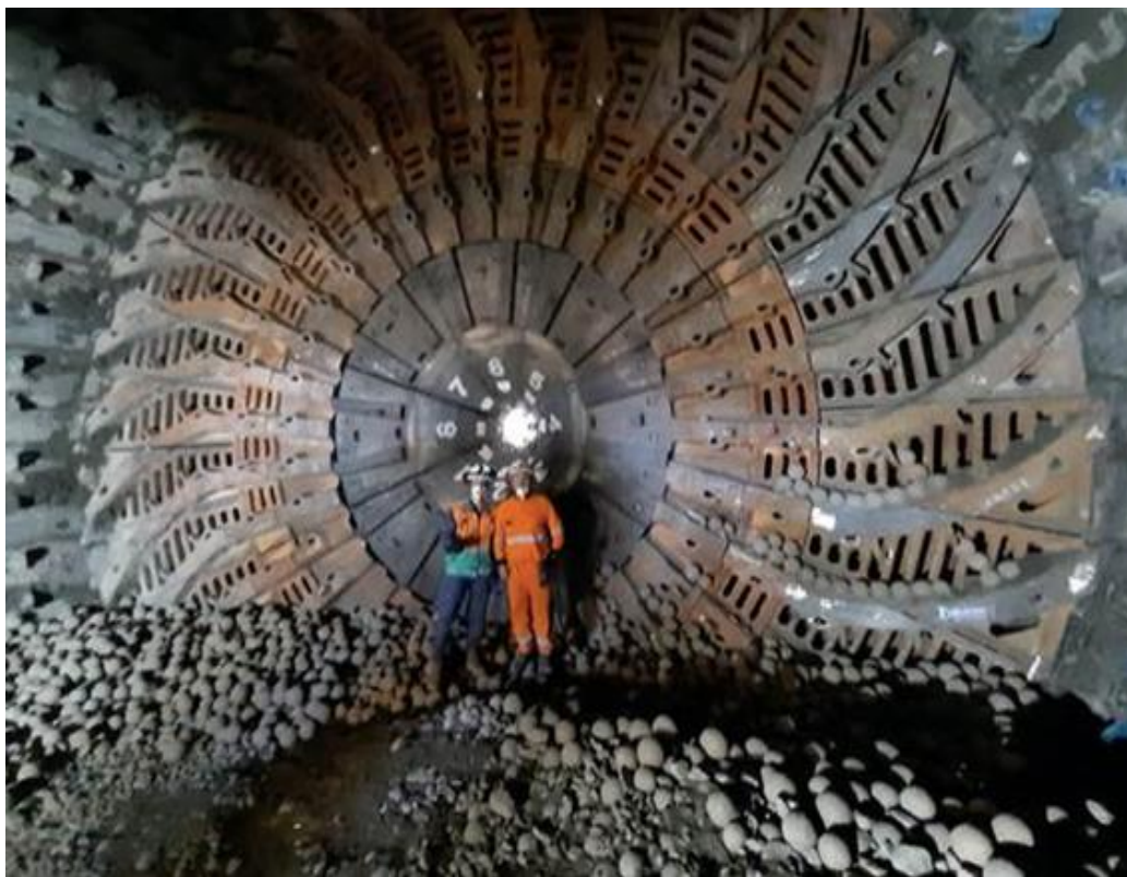
Figura N°24: Recubrimiento interno del molino de bolas outotec 24'x36'.
