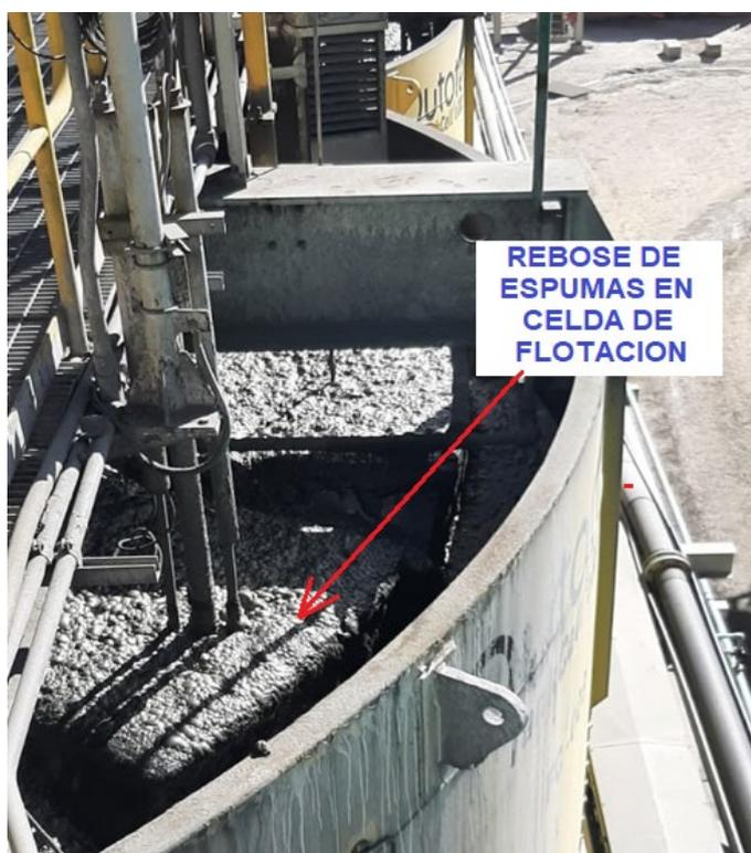
**Figura 5.6:** Sistema Colector de espumas de una celda e300
