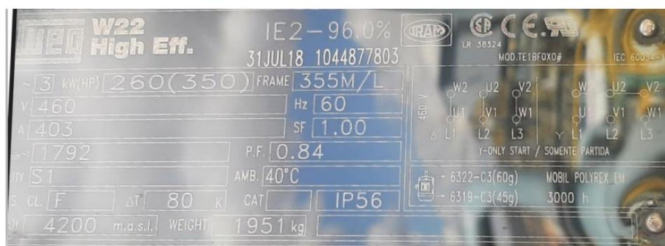
**Figura 6.3:** Placa de motor de accionamiento de la celda de flotación Rougher
