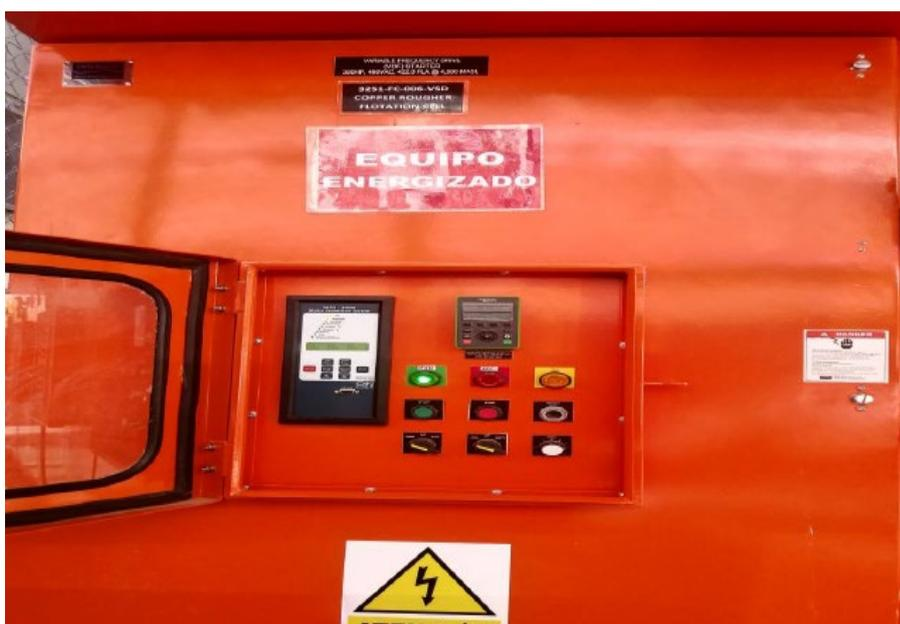
**Figura 6.1:** Tablero de Alimentación Eléctrica de celda de flotación FC006 energizado
