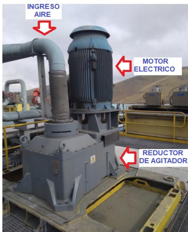
**Figura 5.7:** Sistema de accionamiento de una celda de flotación e300
