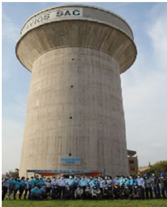
Figura 24. Reservorio elevado de agua potable
