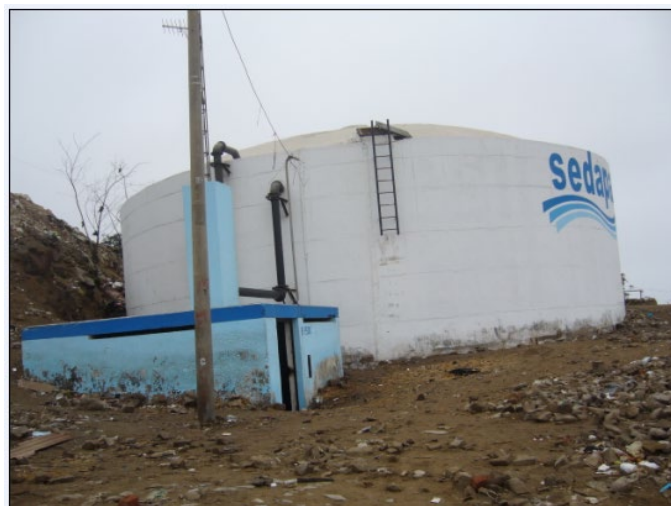
Figura 52. Vista de Reservorio RA-91C
