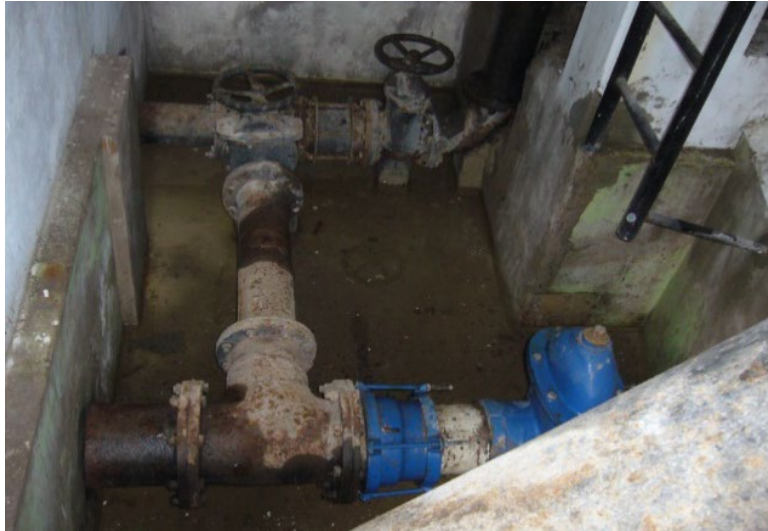
Figura 48. Árbol Hidráulico del RE-89B
