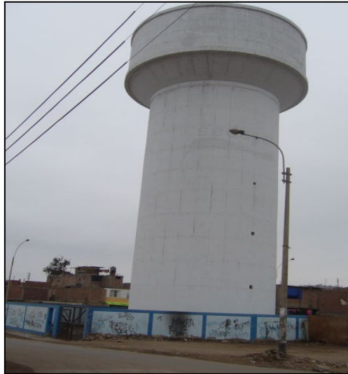
Figura 41. Vista de Reservorio RE-87A Fuente: Propia
