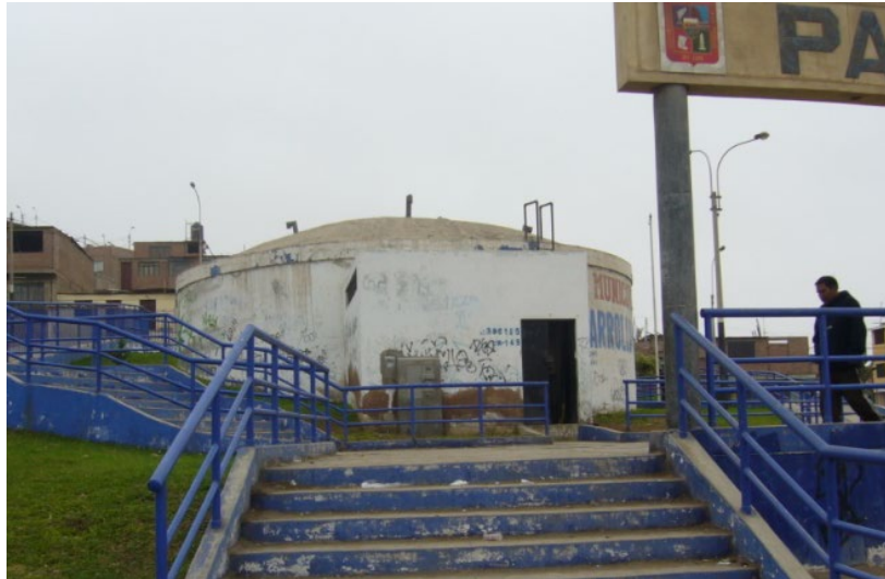
Figura 51. Vista de Reservorio RA-91A
