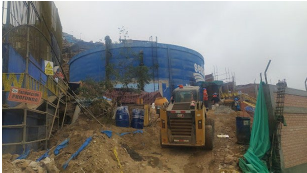
Figura 58. Vista de Reservorio RE-97B
