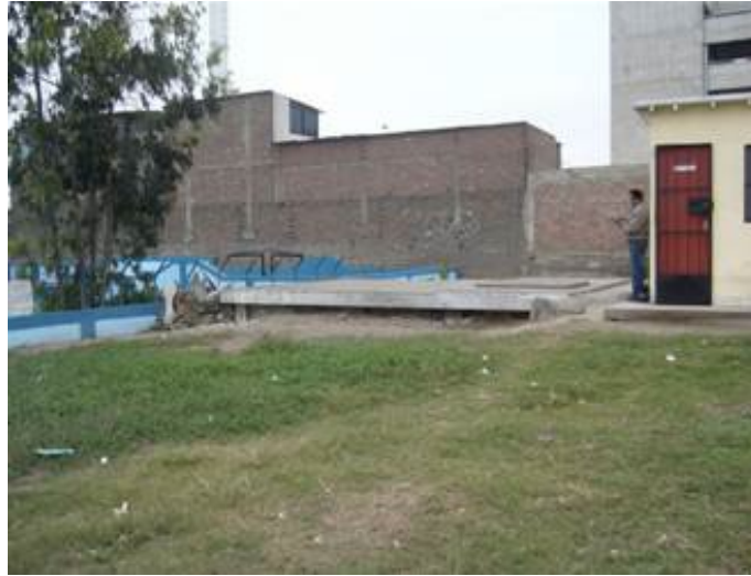
Figura 28. Vista del pozo P-203
