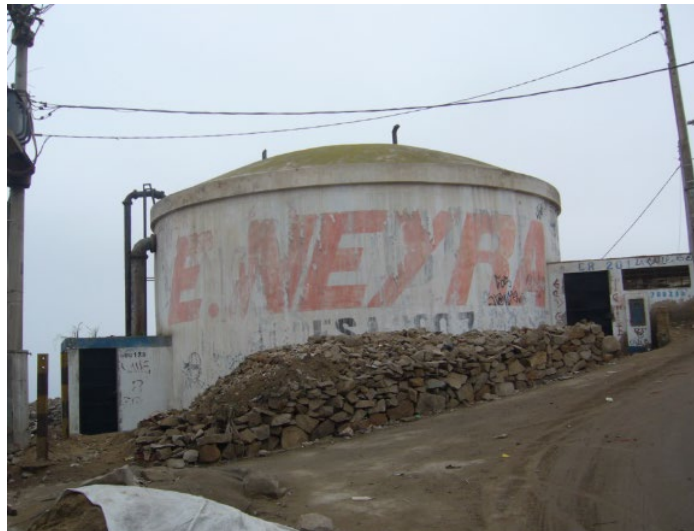
Figura 47. Vista exterior Reservorio RE-89B
