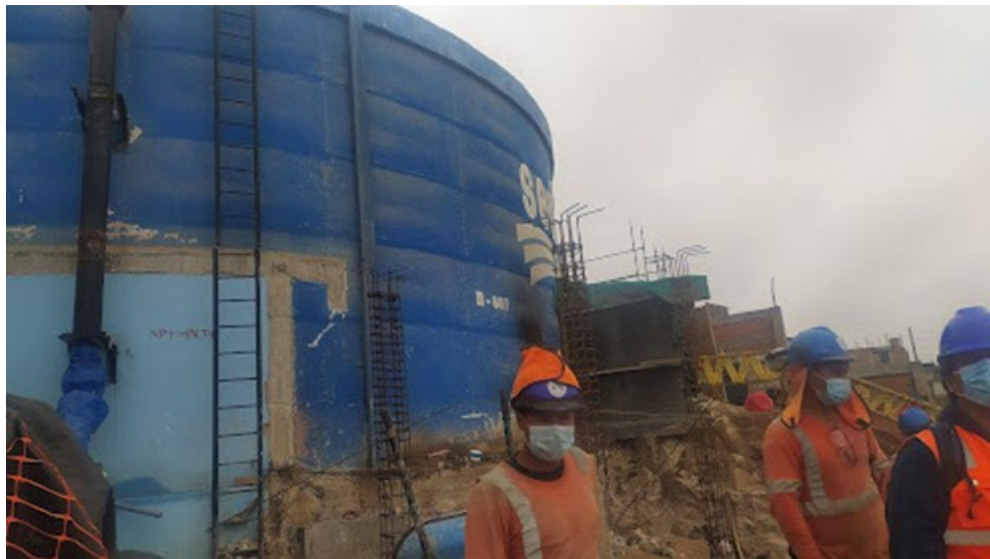
Figura 59. Vista de Reservorio RE-97B
