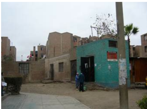
Figura 30. Vista del pozo P-206
