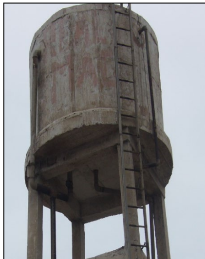
Figura 62. Vista de Reservorio RE-97D
