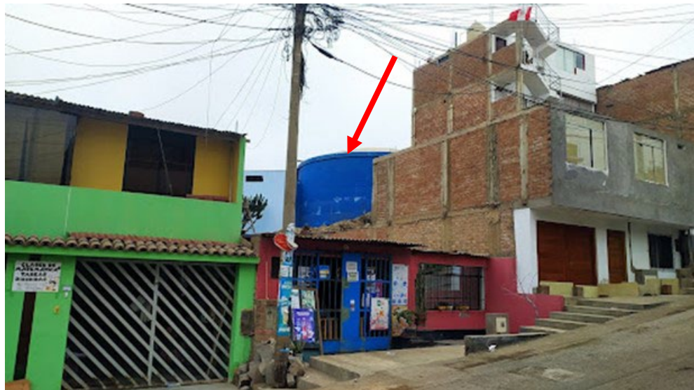
Figura 57. Vista de Reservorio RE-97A
