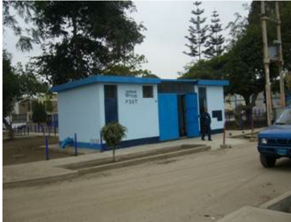
Figura 36. Vista del pozo P-387
