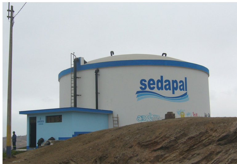
Figura 43. Vista de Reservoirio RE-88A
