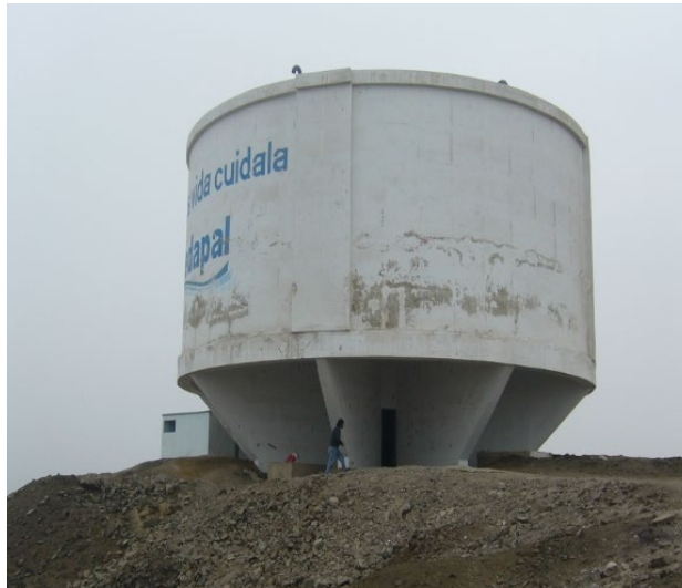
Figura 63. Vista de Reservorio RA-123 a
