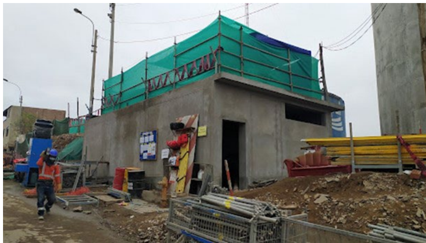
Figura 60. Vista de Reservorio RA-97C Fuente: Propia
