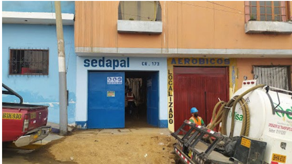
Figura 56. Vista de Reservorio RE-97A
