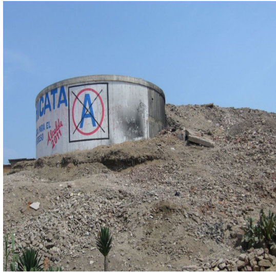
Figura 50. Vista de Reservorio REE-1
