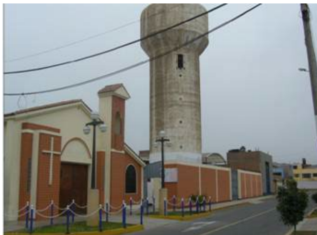
Figura 33. Vista del pozo P-233
