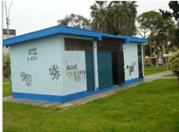
Figura 37. Vista del pozo P-654
