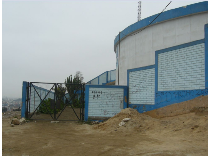
Figura 67. Vista de Reservorio RA-303A
