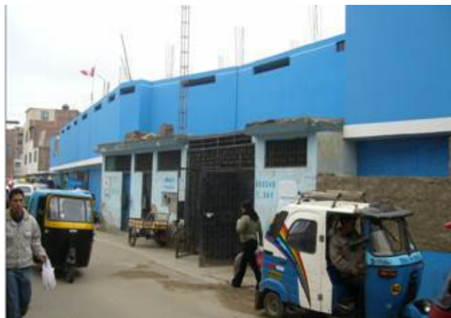
Figura 34. Vista del pozo P-301
