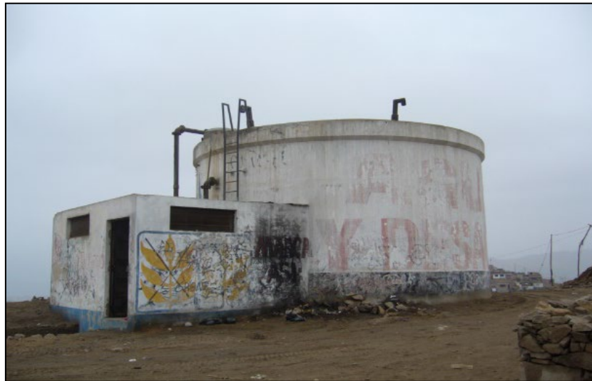
Figura 49. Vista de Reservorio RE-89C
