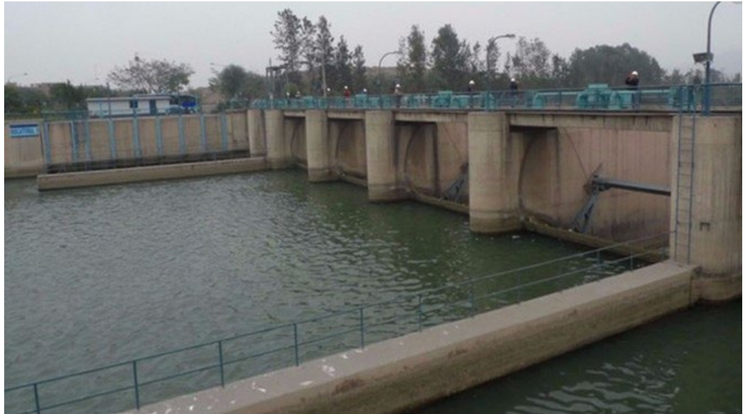
Figura 19. Captación Planta de tratamiento Atarjea
