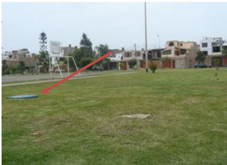
Figura 35. Vista del pozo P-335
