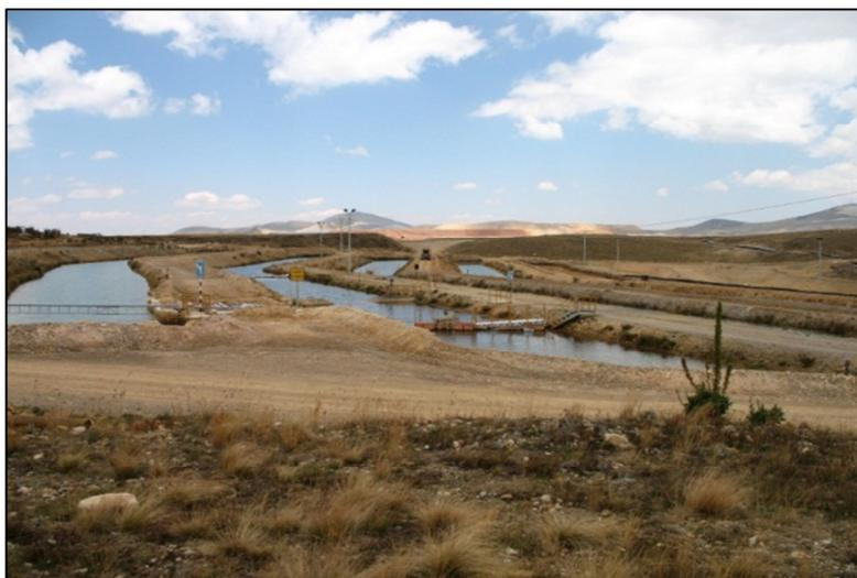
*Figura 39.* Serpentín de retención de sedimentos. MYSRL.
