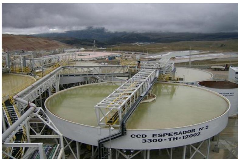
**Figura 10.** Circuito de decantación a contracorriente (CCD). Minera Yanacocha.
