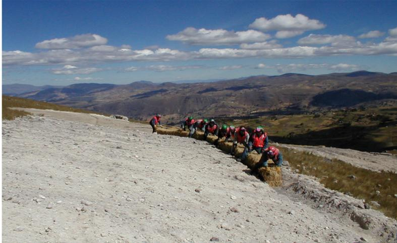
*Figura 37.* Control de la erosión por construcción de barreras de contención.
