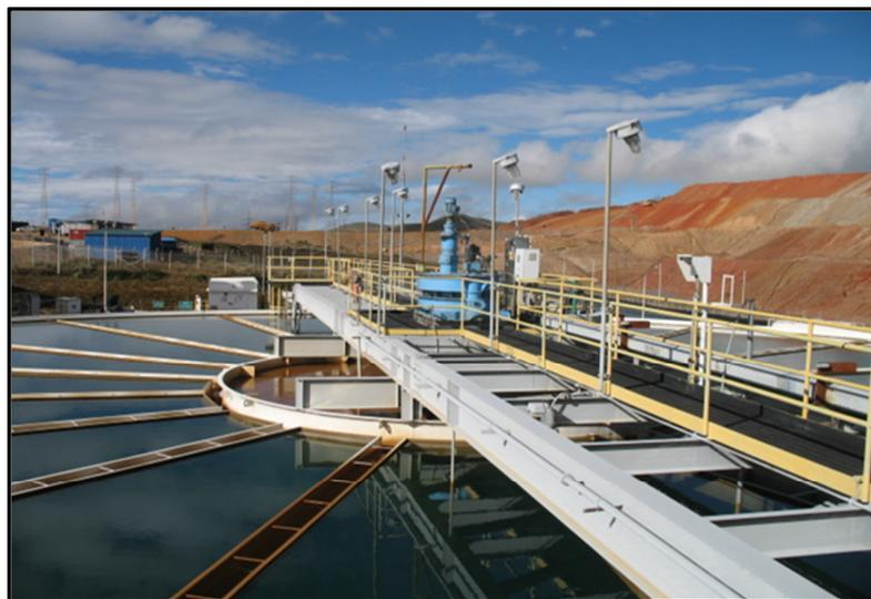
*Figura 68.* Clarificación del agua tratada, en reactor clarificador.
