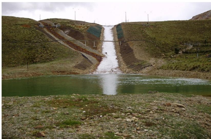
*Figura 34.* Descarga de agua tratada a canales comunales. MYSRL.
