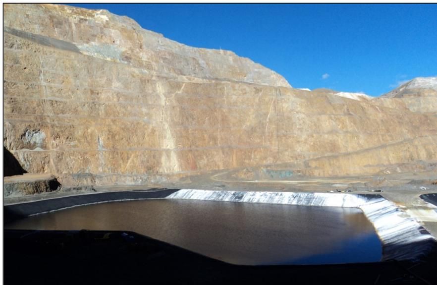
*Figura 18.* Retención de agua ácida. Tajo Yanacocha Norte, MYSRL.
