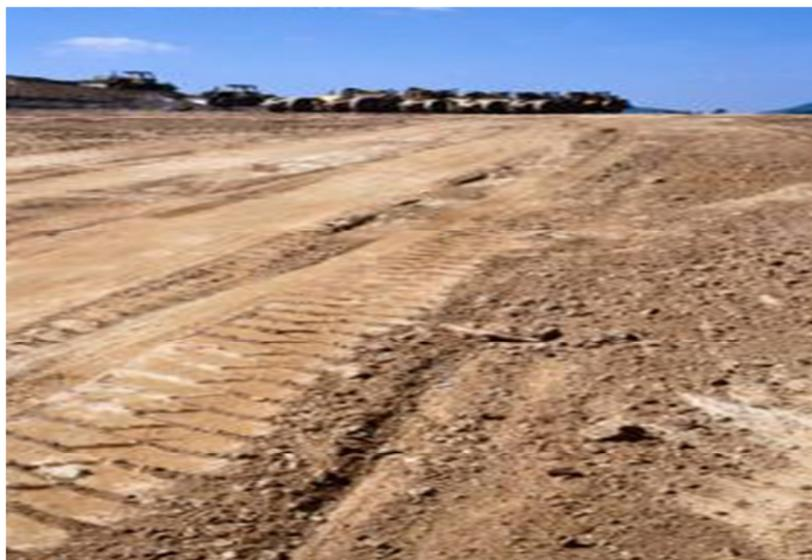
*Figura 35.* Erosión, por pérdida de protección vegetal del terreno.
