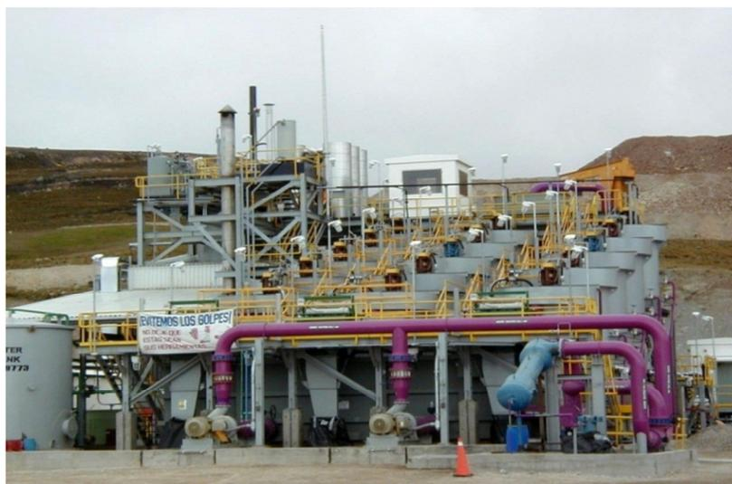
*Figura 7.* Proceso de adsorción de oro en columnas de carbón activado.
