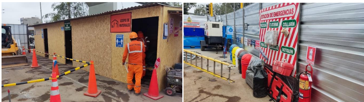
Cerramiento y su implementación en obra
