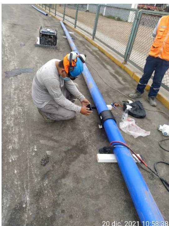
Electrofusión en tubería de agua potable HDPE DN 200
