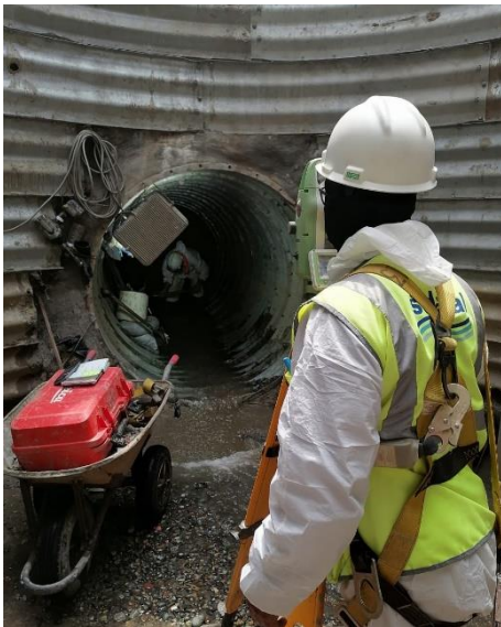
Control topográfico de la instalación de los 03 primeros anillos
