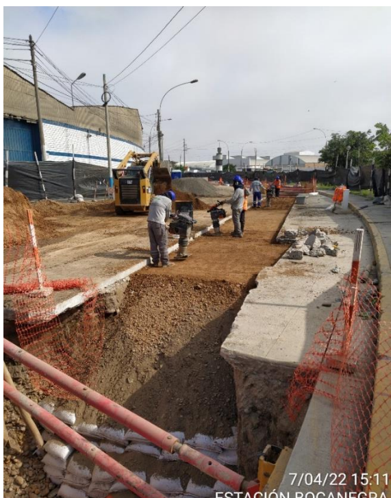
Compactación de base con afirmado para reposición de pavimento
