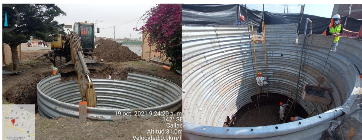
Construcción del buzón circular liner BP-13
