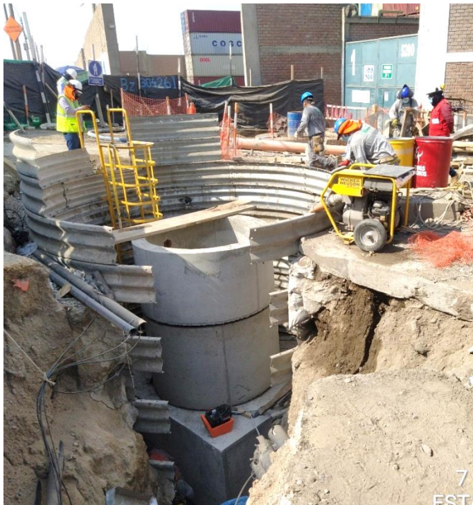
Colocación de fustes sobre la cámara húmeda del buzón BP-18
