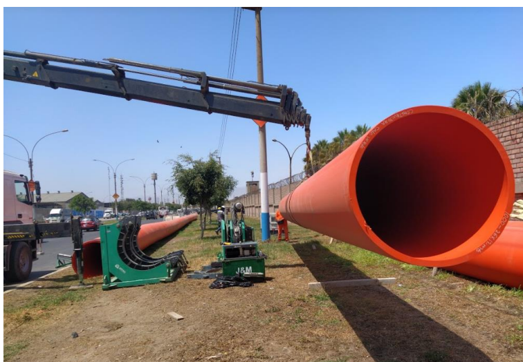
Acopio y descarga de tubería HDPE DN 1000
