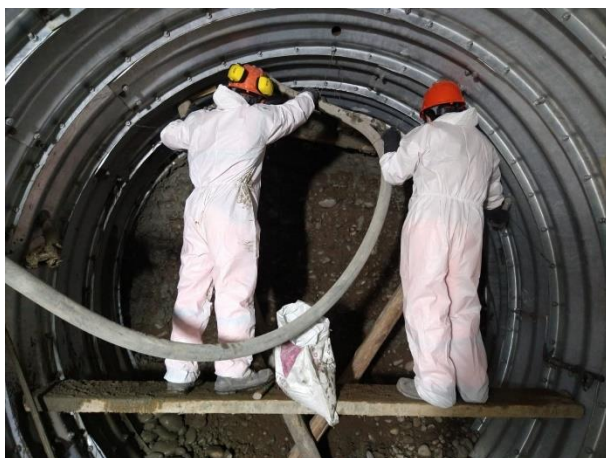
Inyección del mortero plástico alrededor de las láminas liner
