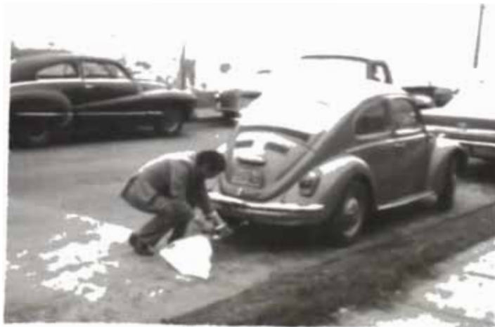
FOTOGRAFIA N° 4: MUESTREO DE MONOXIDO DE CARBONO EN LOS EFLUENTES DESCARGADOS POR EL TUBO DE ESCAPE EN AUTOMOTORES CIRCULANTES EN LA CIUDAD - METODO DE LOS DETECTORES COLORIMETRICOS -
