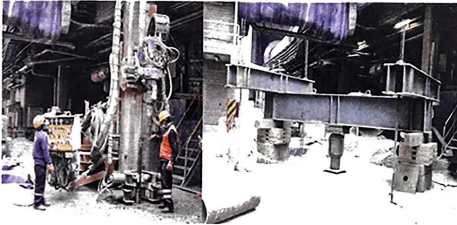
*Figura 18: Anclajes instalados para marco de reacción.*
