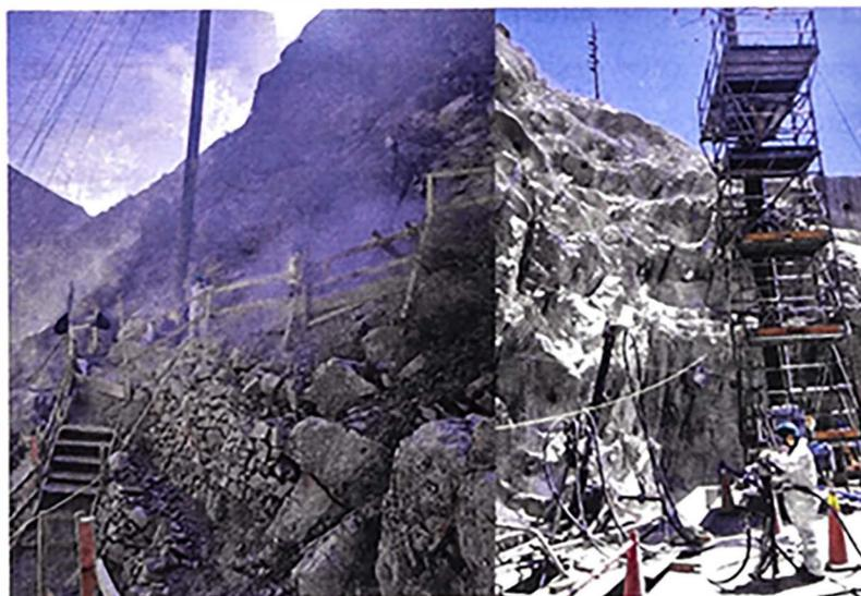
Figura 29: Postes L121-7 y L121-8 siendo reforzados con anclajes adicionales.
