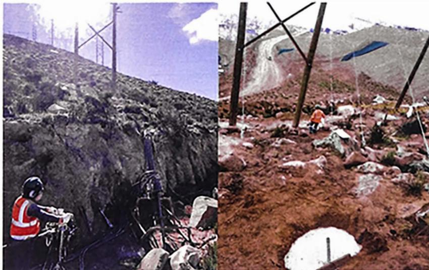
Figura 27: Instalación de anclajes adicionales en pi-poste L6-4.
