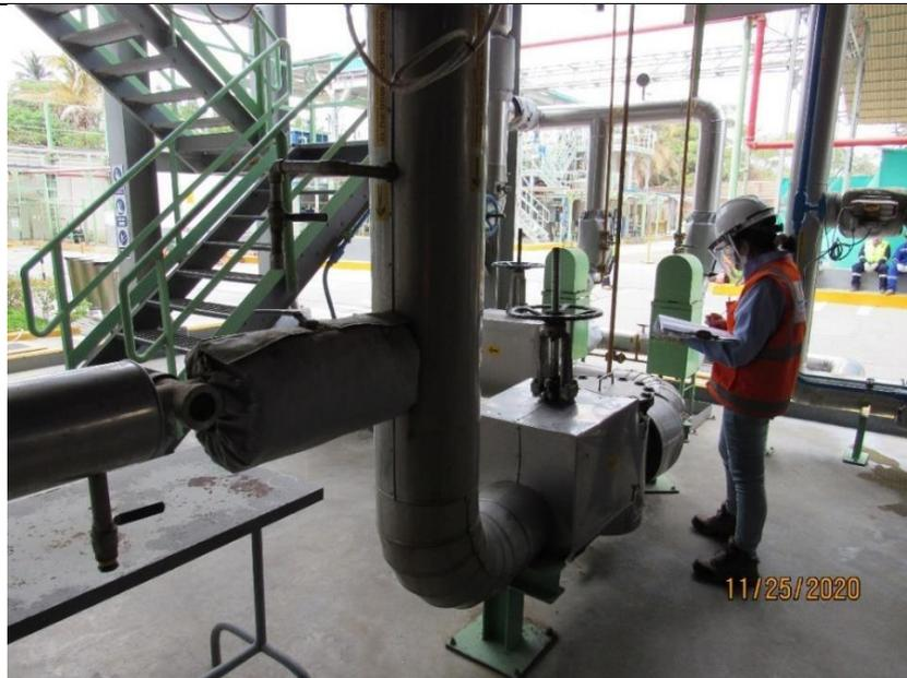
La fotografía N°02 muestra el ruteo de las tuberías, realizado en el primer piso del área de Hidrólisis a través de su plano P&ID.
