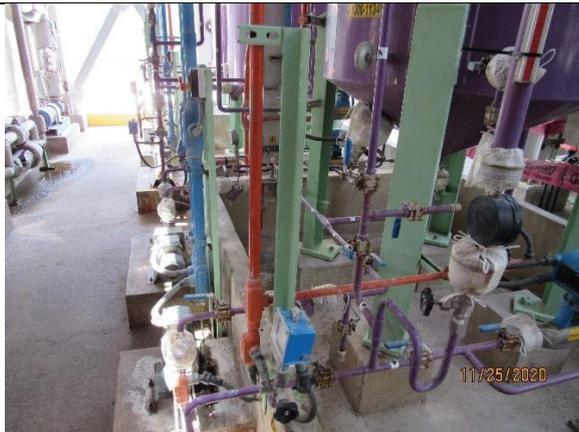
**La fotografía N°11** muestra el ruteo realizado a las tuberías y equipos del tanque de soda cáustica en el primer nivel del área de Neutralizado.
