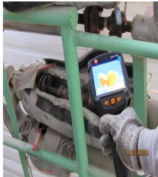
En las fotografías N°50 y N°51 se muestra la medición de temperatura de las trampas de vapor mediante la cámara termográfica.
