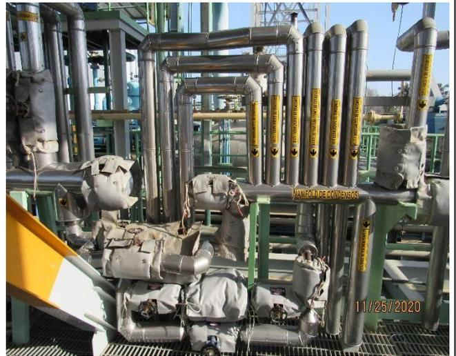
**En las fotografías N°13 y N°14 se muestran las observaciones de la ausencia de líneas y válvulas, realizadas en los manifold de distribución de vapor y en el de condensos, respecto a la revisión de planos de DSM Marine Lipids.**
