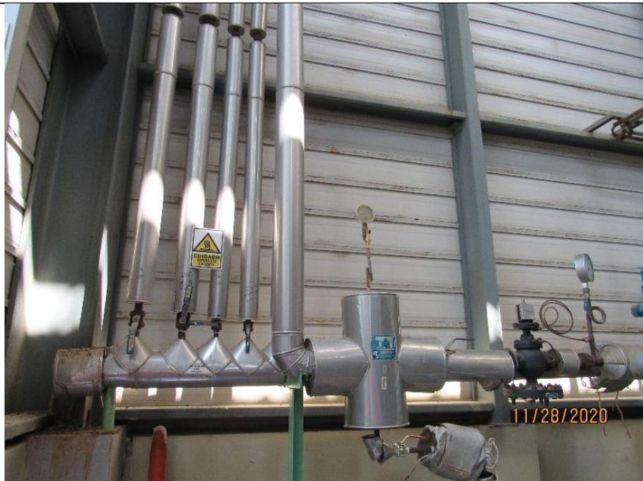
**En la fotografía N°44 se muestra la identificación de las líneas de salida del manifold Z-0700-004 respecto al plano P&ID del área.**
