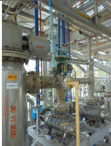
En la fotografía N°60 se muestra la identificación de las líneas de entrada y salida del intercambiador de calor H-0500-117.
