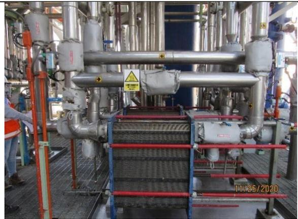
**La fotografía N°12** muestra el ruteo realizado a los intercambiadores de placas y sus respectivas conexiones en el segundo nivel del área de neutralizado.
