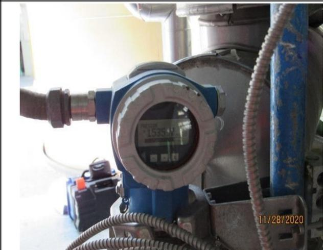
En las fotografías N°52 y N°53 se muestra la revisión de los transmisores de presión y temperatura para el posterior análisis de los valores que indican.
