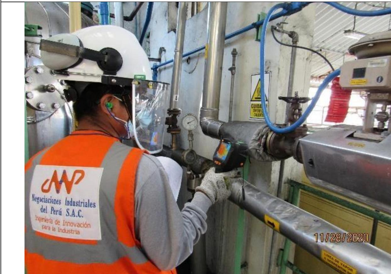
En la fotografía N°54 se muestra la medición de la temperatura de la entrada de vapor al área.
