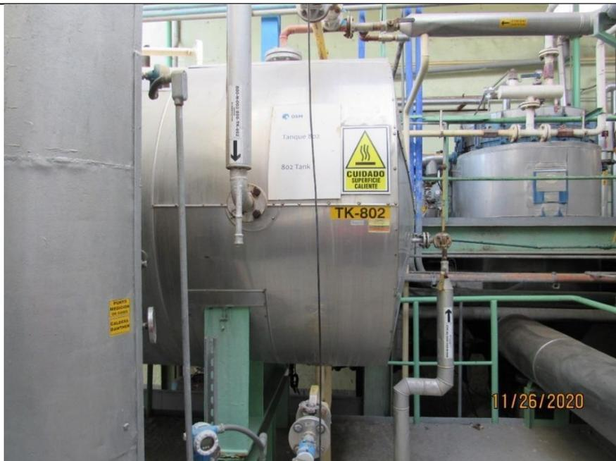
En la fotografía N°63 se muestra la identificación del tanque desairador V-0800-802, así como de sus conexiones.
