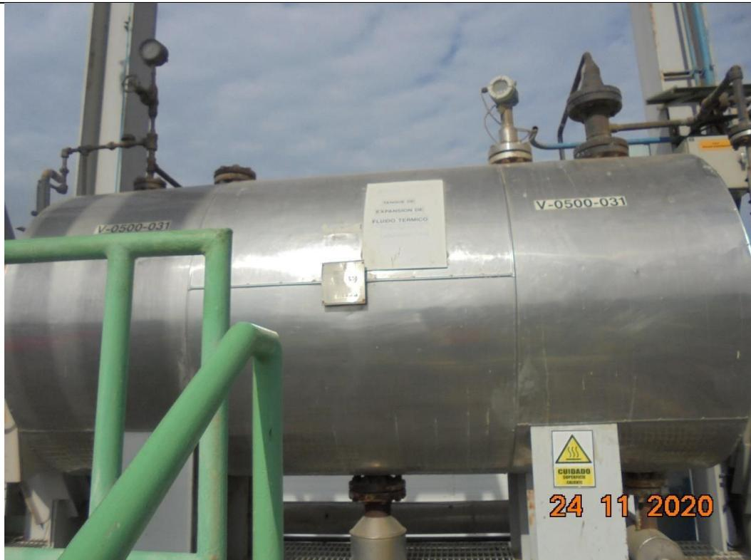
**En la fotografía N°59 se muestra la identificación general de las conexiones e instrumentación del tanque de expansión V-0500-031.**
