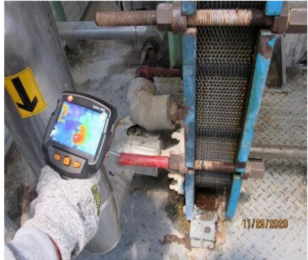
En las fotografías N°48 y N°49 se muestra la medición de temperatura de las líneas de entrada y salida del intercambiador de placas mediante la cámara termográfica.
