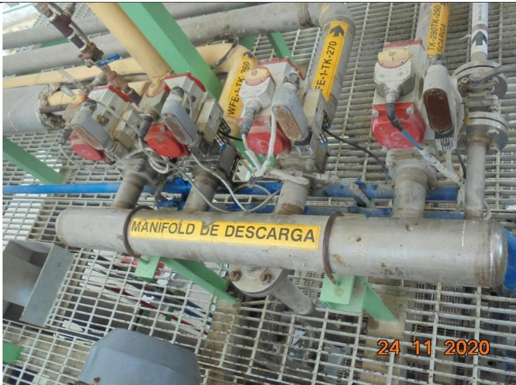
En la fotografía N°61 se muestra la identificación de las líneas de entrada y salida del manifold de descarga Z-0500-102.
