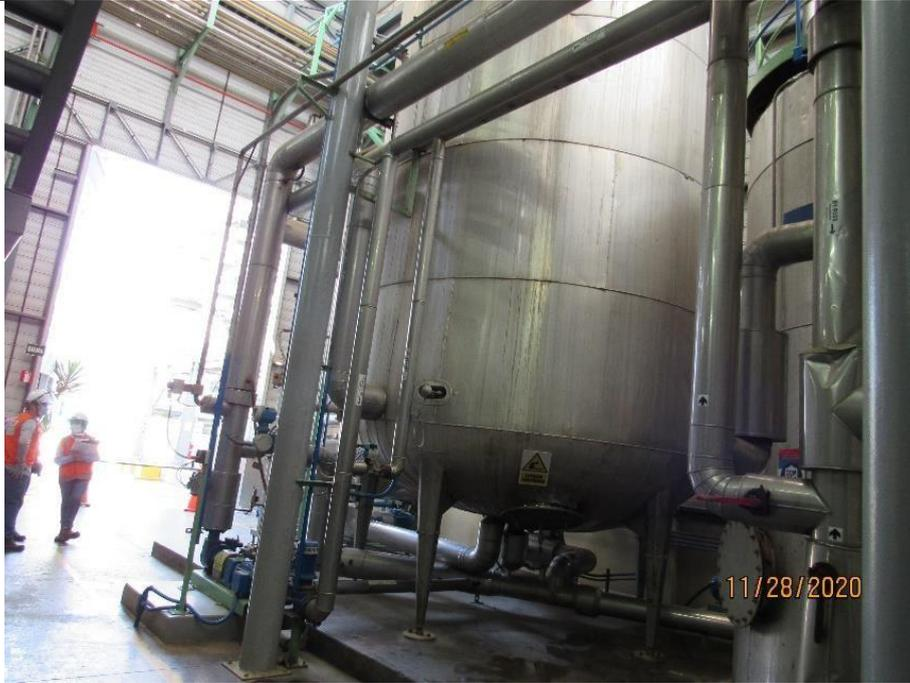
**En la fotografía N°43 se muestra la identificación general del Cristalizador y de sus conexiones respecto al plano P&ID del área.**
