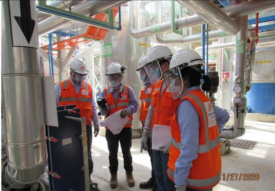
**En la fotografía N°39 se muestra el uso de la cámara termográfica para medir la temperatura del intercambiador de placas.**
