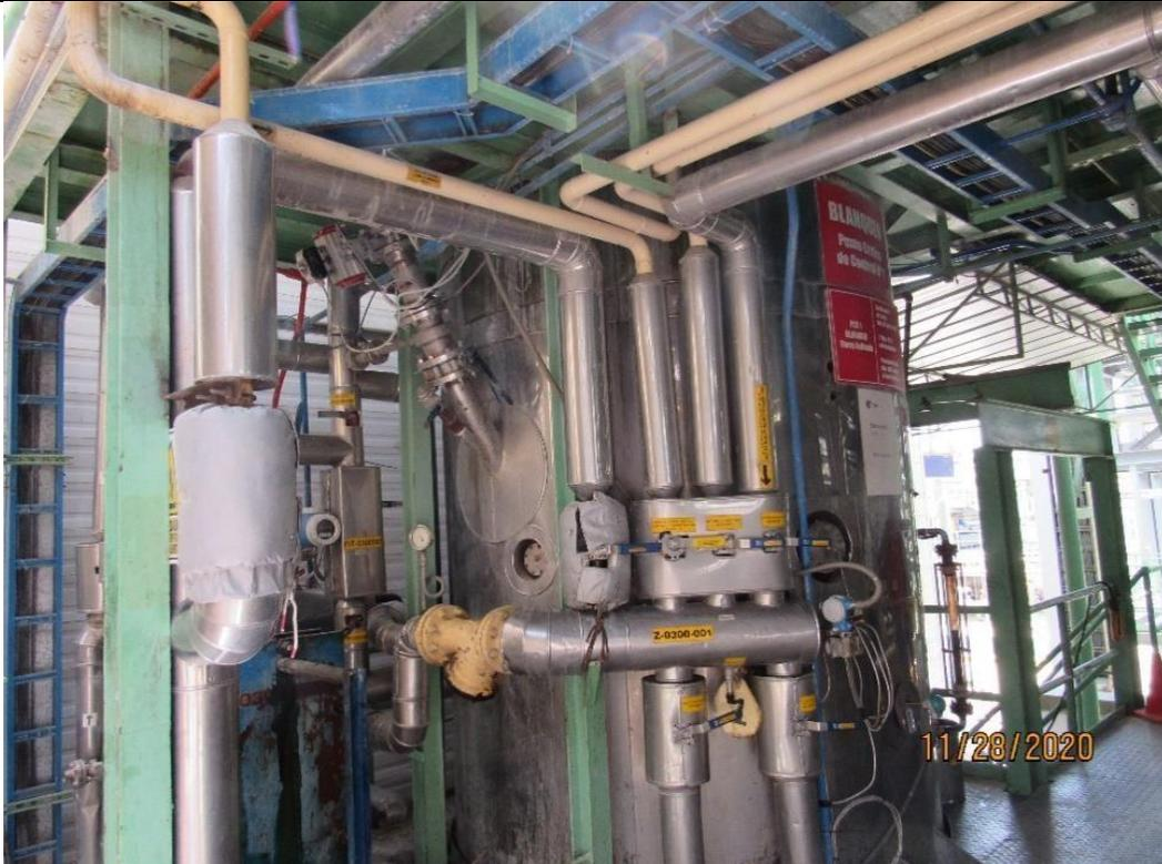
En la fotografía N°47 se muestra el reconocimiento general del área, iniciado con la identificación del Blanqueador, así como de sus líneas de salida y entrada, y su instrumentación.
