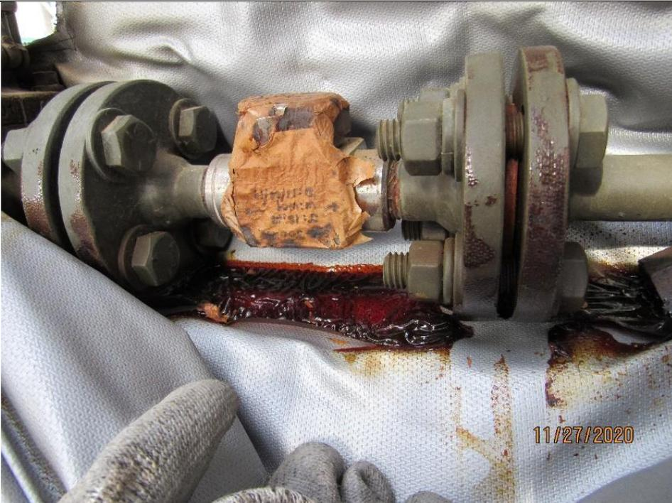
**En la fotografía N°40 se muestra la identificación de las trampas de vapor del área Merlín para su posterior clasificación: mecánica o termodinámica.**
