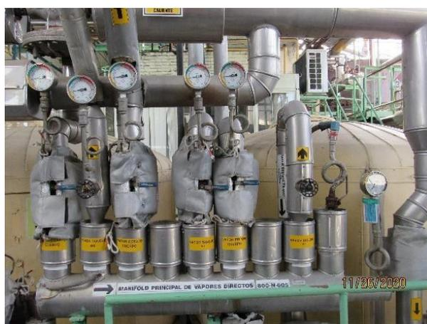
En las fotografías N°65 y N°66 se muestra el reconocimiento de las entradas y salidas de los manifold de vapor de los sistemas de vacío y de vapores directos.
