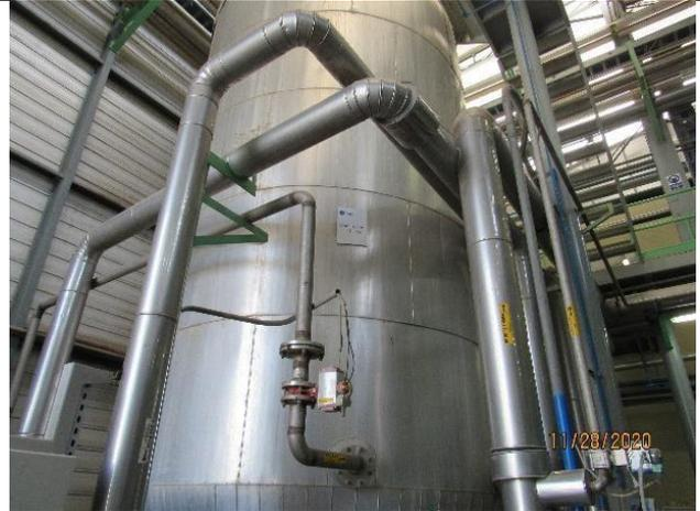
En las fotografías N°45 y N°46 se muestra el ruteo de las líneas de salida y entrada al Cristalizador respecto al plano P&ID del área.
