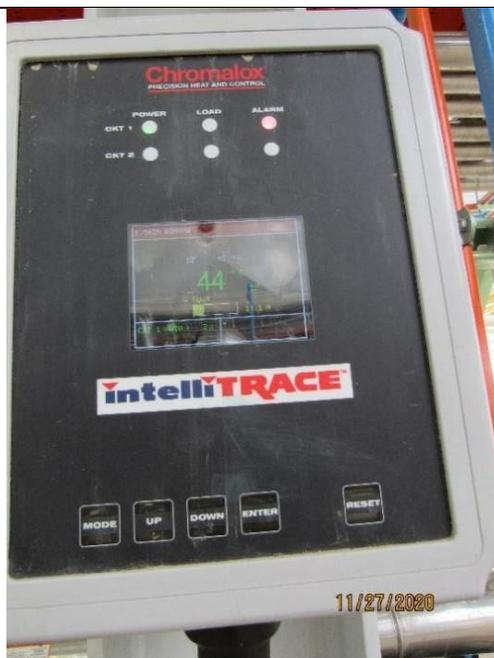
**En la fotografía N°41 se muestra la identificación del controlador digital de trazas de calor y la lectura de temperatura correspondiente: 44°C.**
