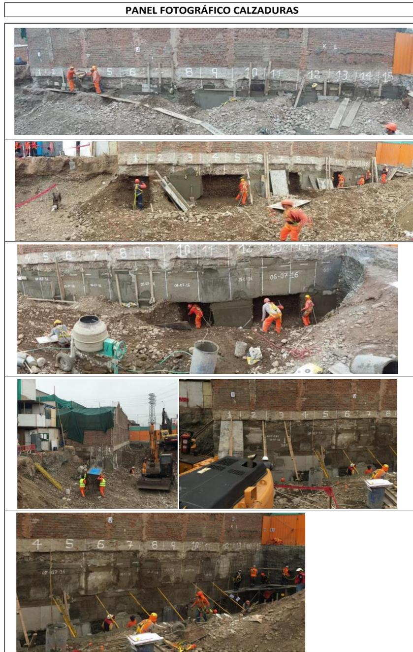
Figura N°5.33 Panel Fotográfico calzaduras.
