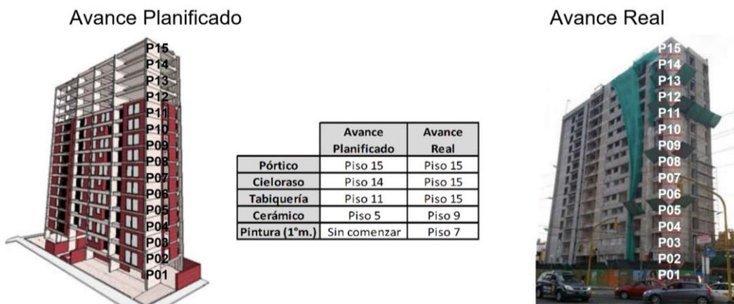
Figura N°6.15 Plan Maestro vs Avance Real al 15/03/17.
