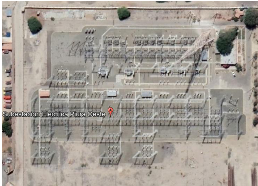
Figura N° 32 Vista de la Subestación Piura 220/60/10 kV
