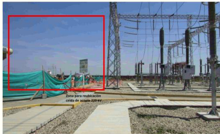
Figura N° 35 Zona para ampliación de barras y reubicación de campo de acople 220 kV.
