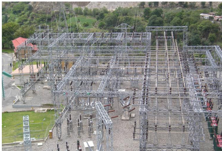
Figura N° 11 Pórtico tipo Box
