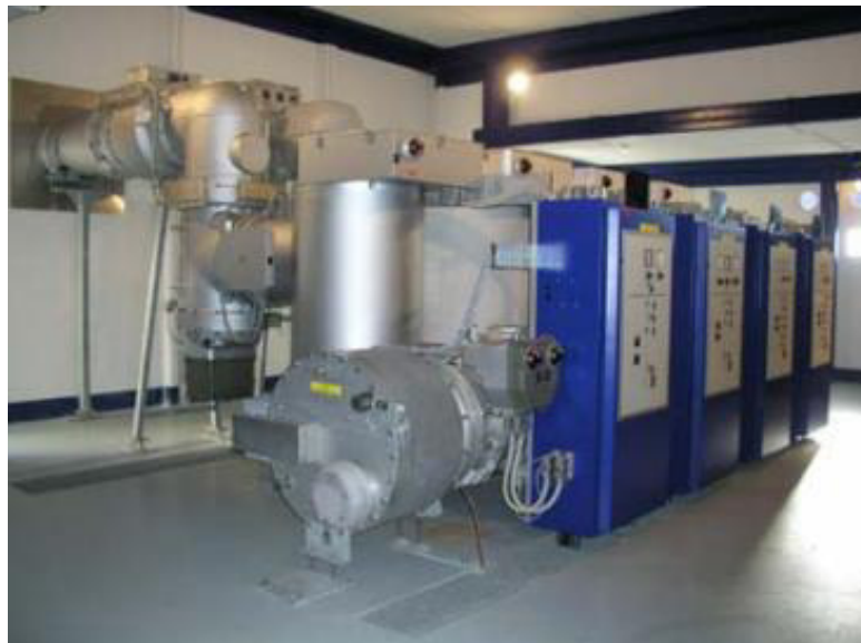
Figura N° 6 Subestación blindada
