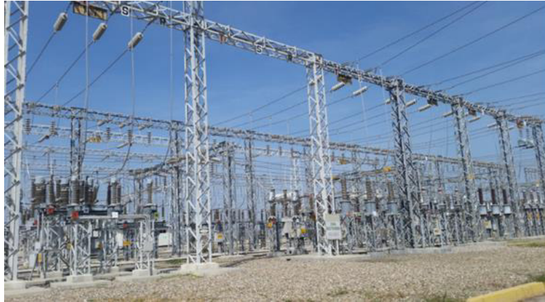
Figura N° 10 Pórtico tipo Dead End
