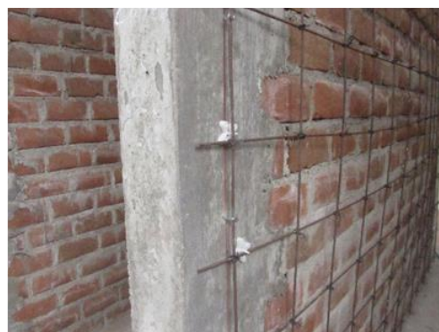
Figura N° 176. Instalación de alcayatas de \varnothing 2 1/2'' a presión en columnas de concreto.
