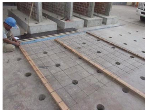
Figura N° 170. Tejido de la malla de acero \varnothing 4.7mm con alambre N°16.
