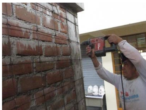
Figura N° 175. Perforación de columnas de concreto con broca 5/32'' para instalación de alcayatas de \varnothing 2 1/2''.
