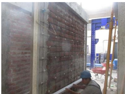
Figura N° 181. Verificación de espesor de reforzamiento con reglas de aluminio.
