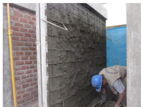
Figura N° 183. Tarrajeo de muro de albañilería confinada con mortero de reforzamiento cemento- arena 1:4.
