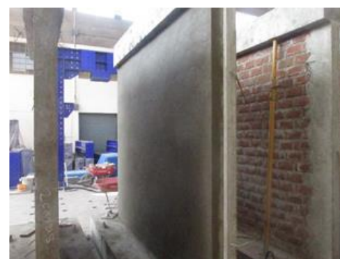
Figura N° 184. Acabado del reforzamiento de muro de albañilería confinada.
