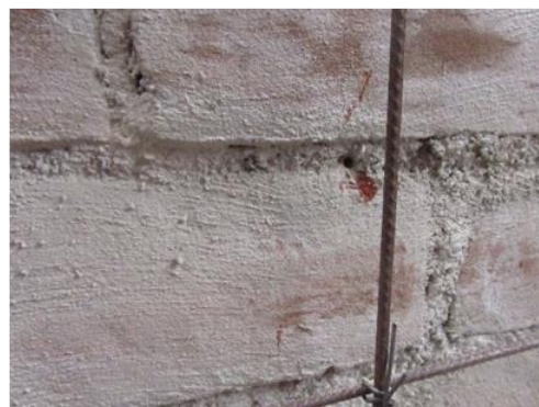
Figura N° 178. Orificio en muro de albañilería con broca 3/16'' para instalación de alambre N°8.
