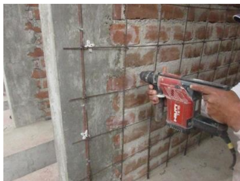
Figura N° 177. Perforación de muro de albañilería con broca 3/16'' para instalación de alambre N°8.
