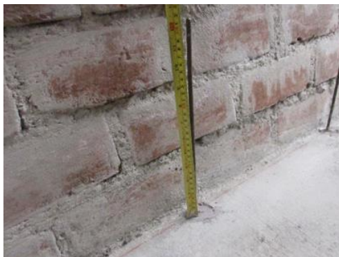
Figura N° 173. Instalación de dowels de \varnothing 6mm en base del muro.
