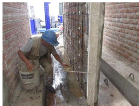
Figura N° 182. Humedecimiento de muro de albañilería con agua para tarrajeo.
