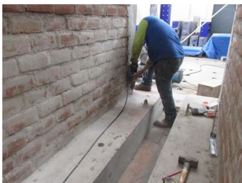
Figura N° 171. Perforación de base con broca 5/16" para instalación de dowels de \varnothing 6mm.
