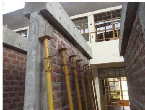
Figura N° 174. Instalación de dowels de \varnothing 6mm en viga de concreto.
