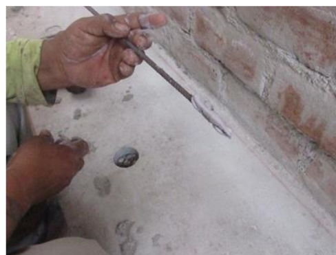
Figura N° 172. Colocación de epóxico para anclaje de dowels de \varnothing 6mm a base.
