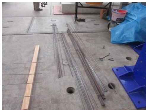
Figura N° 169. Corte y habilitación de varillas acero \varnothing 4.7mm.
