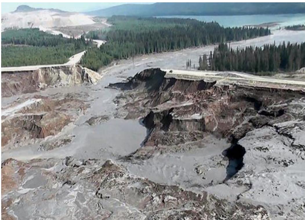
Figura 2.34 Vista de la falla de la presa Mount Polley-Canadá (2014). Fuente: Adaptado de The Bulletin (Marshall, 2018). Tailings Dam Spills at Mount Polley and Mariana . Consultado el 07 de junio del 2021 https://cutt.ly/RbZn2a1
