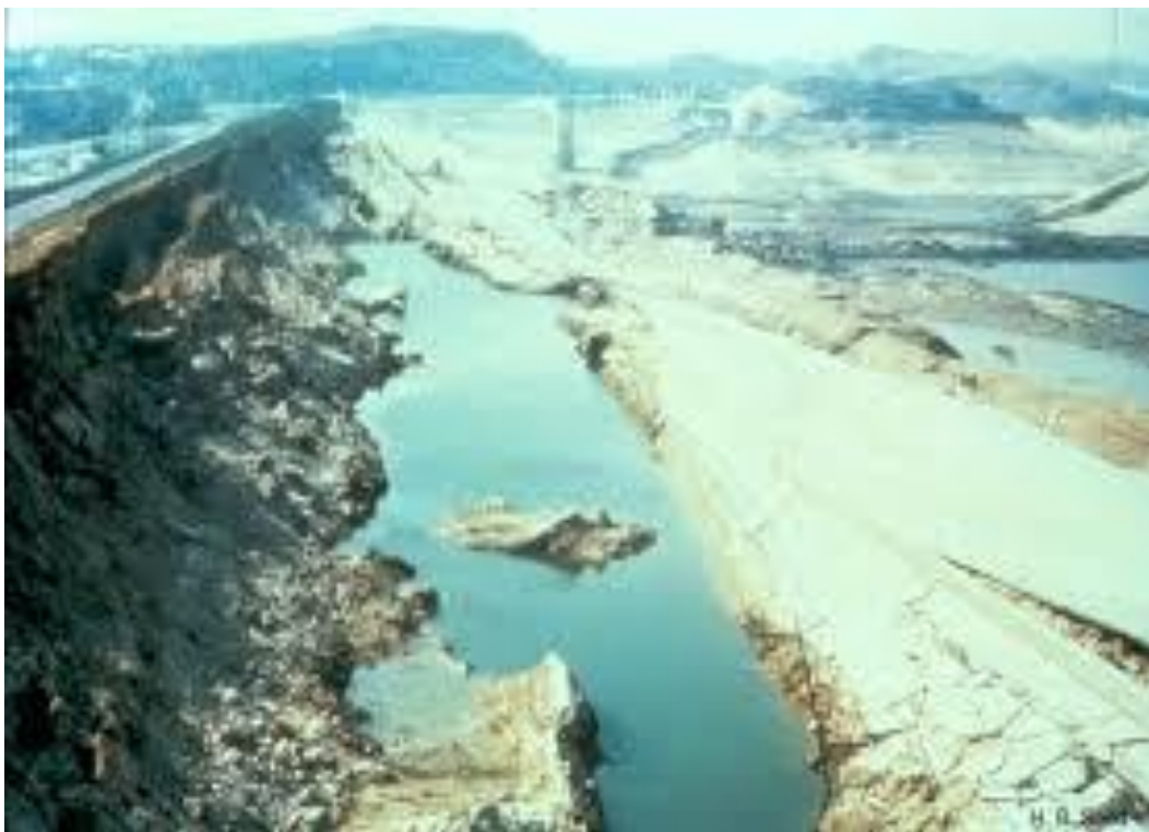
Figura 2.32 Vista de la falla de la presa San Fernando-EE. UU (1971). Fuente: Adaptado de Civil and Environmental Engineerig (s.f.). Consultado el 07 de junio 2021. https://cutt.ly/smrSzVe
