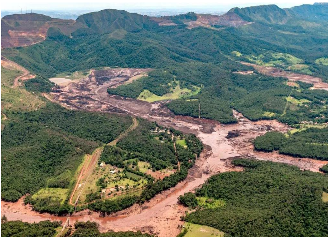
Figura 2.36 Vista del flujo de material de relave debido a la falla de la presa Brumadinho-Brasil (2019). Fuente: Adaptado de Jamasmie (2020). La respuesta de los mineros al desastre de la presa de Brasil sigue siendo débil . Consultado el 07 de junio del 2021. https://cutt.ly/fmyoCxE
