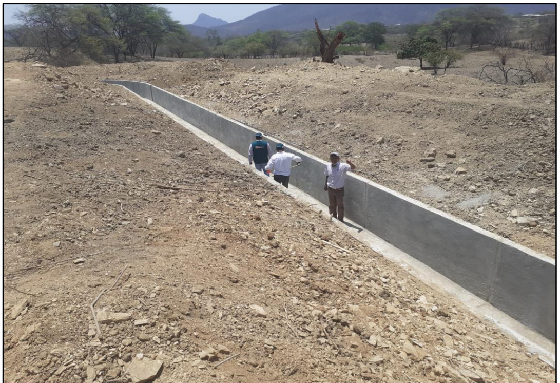
PERSONAL DEL PSI VERIFICANDO LAS DIMENSIONES DEL CANAL PIEDRA EL TORO.
