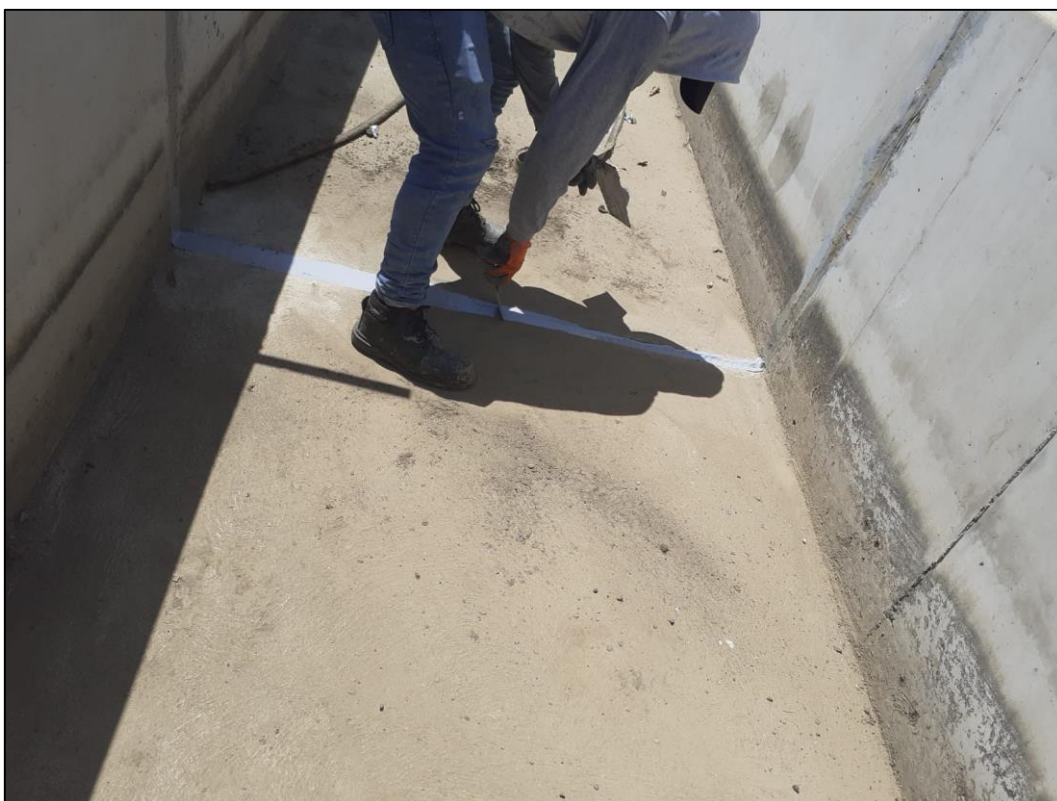
Figura 15. Trabajos de sellado de juntas con material elastomérico Fuente: Elaboración Propia
