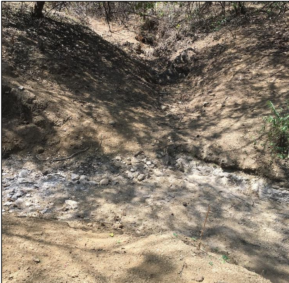
ALCANTARILLA DE CARRETERA EN MARGEN DERECHA QUE SE ACTIVA EN ÉPOCA DE LLUVIAS, ACTUALMENTE LAS AGUAS EVACUAN AL CANAL DE TIERRA, REQUIERE DE LA CONSTRUCCIÓN DE UNA CANOA EN LA PROGRESIVA KM. 5+187.
