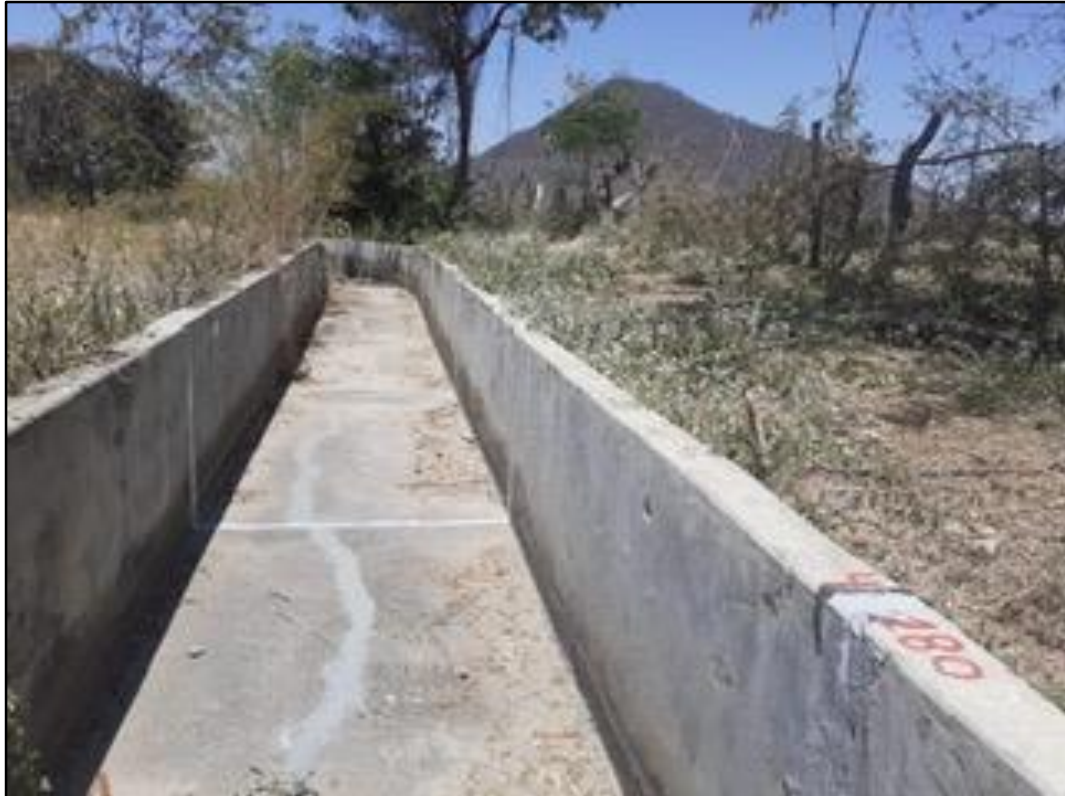
Figura 18. Sellado de fisuras y juntas en el canal de concreto existente desde el km. 0+000 al km. 4+375 Fuente: Elaboración Propia
