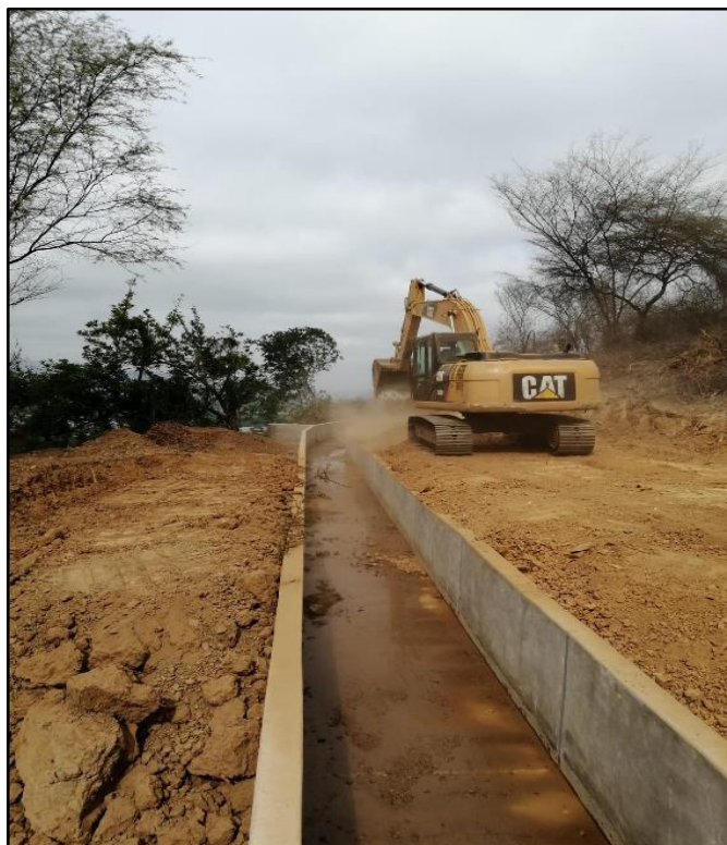
TRABAJOS DE RELLENO DE LOS ESPALDONES DE LA CAJA DEL CANAL CON EXCAVADORA Y RETROEXCAVADORA.
