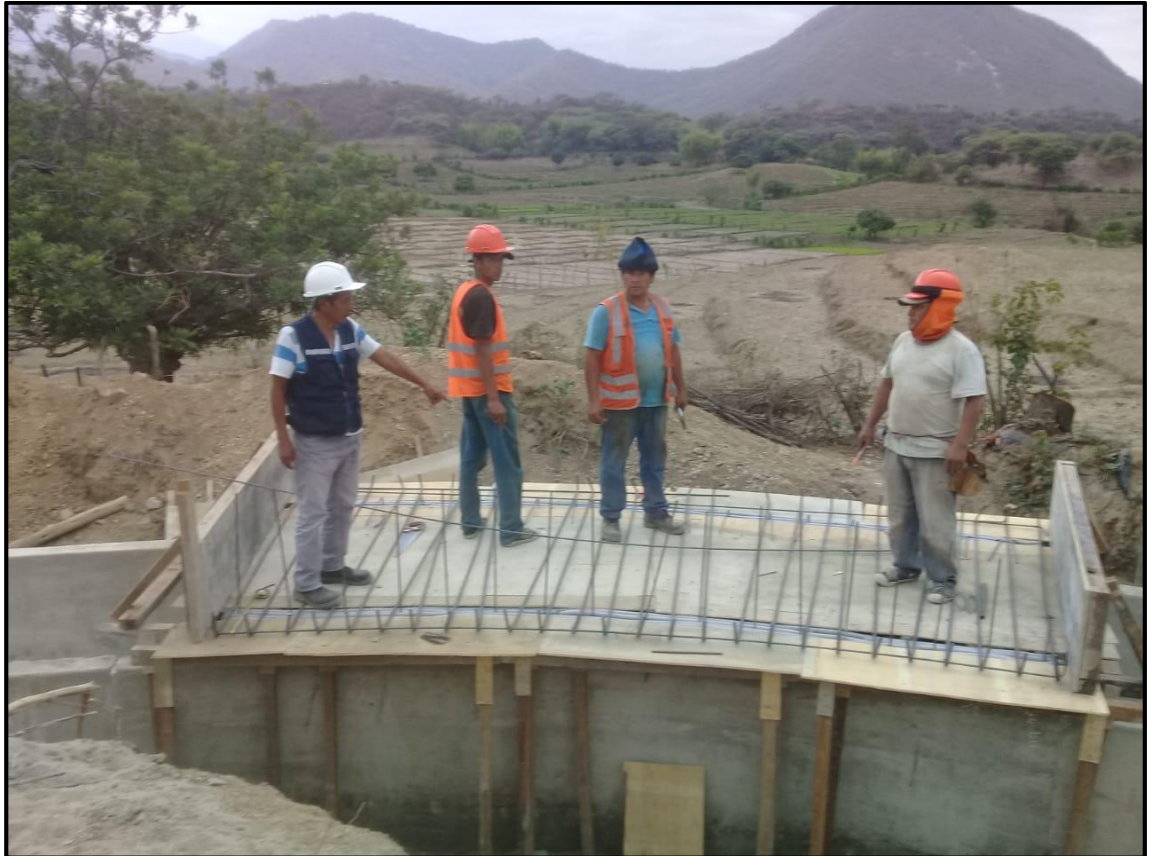
CONSTRUCCIÓN DE LA ESTRUCTURA DEL PUENTE PEATONAL
