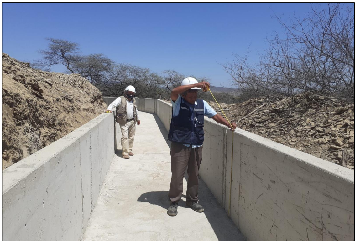
VERIFICACIÓN DE MEDIDAS DE LA SECCIÓN DEL CANAL RESIDENTE CON EL SUPERVISOR
