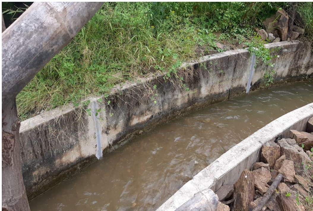
Figura 41. Muestra juntas de concreto, rellenas con material elastomérico, en perfecto estado y funcionando correctamente, km 8+050.
