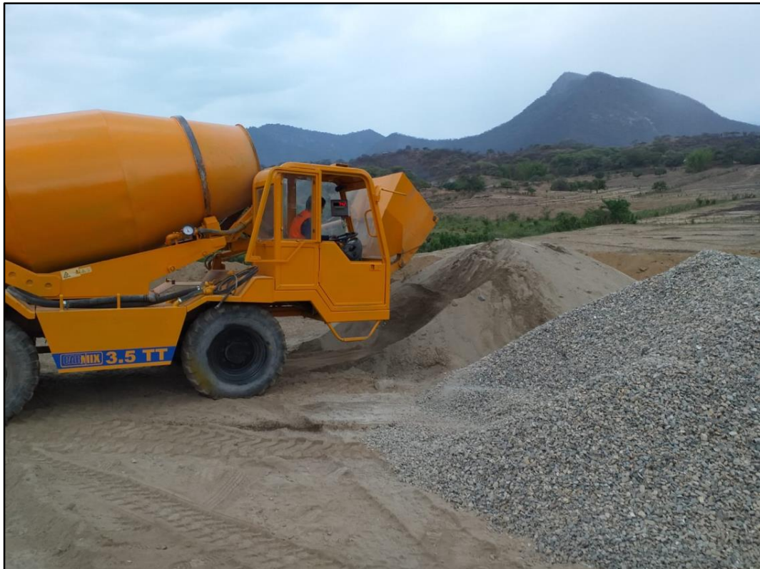
Figura 14. Preparación del concreto con el carmix 3.5 TT
