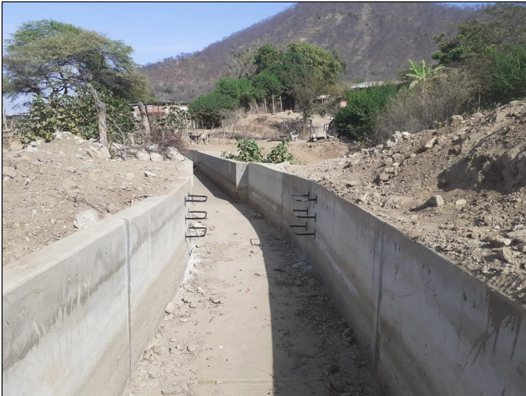
Figura 17. Trabajos de sellado y de colocación de los escalines en los muros del canal a ambos lados
