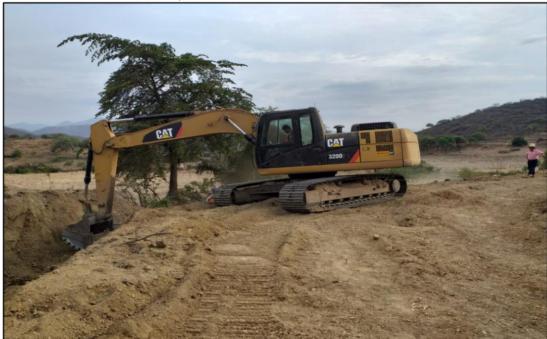
EXCAVADORA CAT 320-D A DISPOSICIÓN DE LA OBRA REALIZANDO TRABAJOS DE MOVIMIENTO DE TIERRAS Y HABILITANDO CAMINO DE ACCESO EN LA MARGEN DERECHA DEL CANAL.
