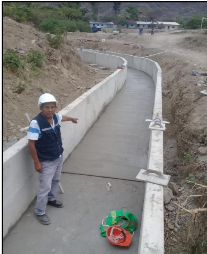
ACABADO DE PISO TERMINADO EN EL CANAL PIEDRA EL TORO.
