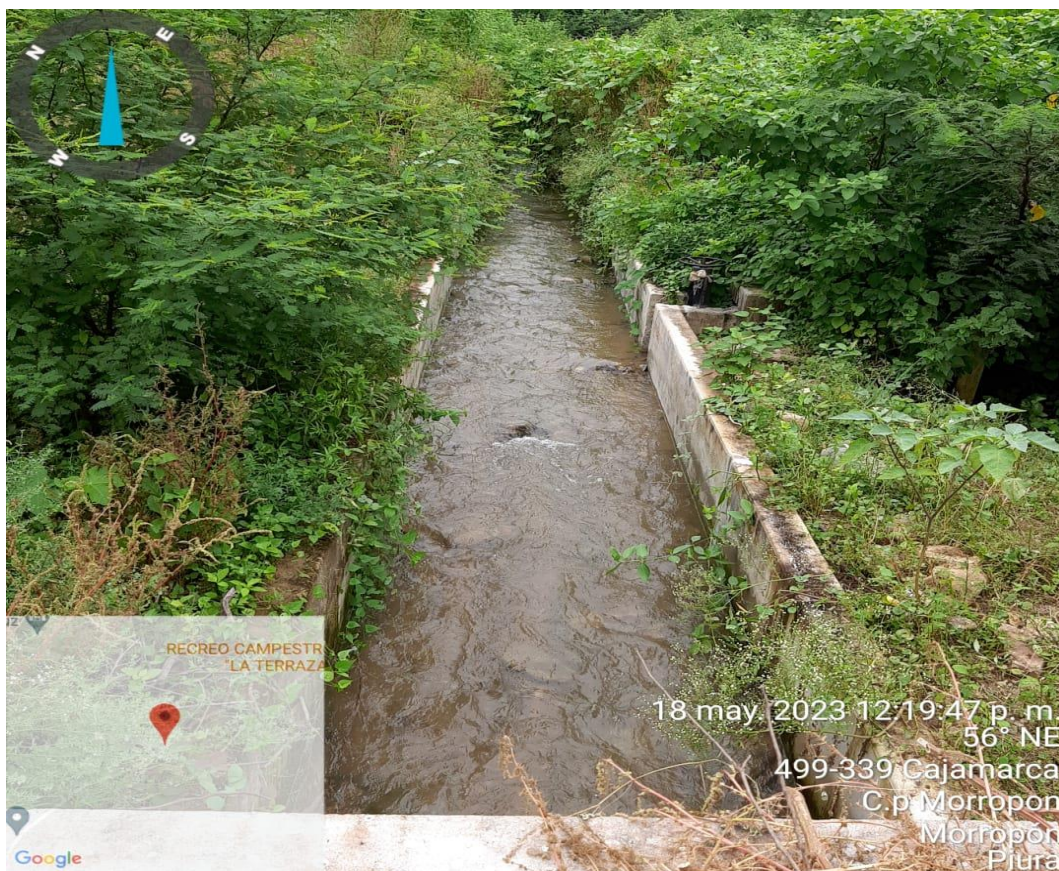
Figura 33. Muestra canal en funcionamiento, que requiere limpieza de maleza en ambas márgenes del canal, véase compuerta lateral progresiva 7+964, se observa camino de vigilancia totalmente cubierto por vegetación.
