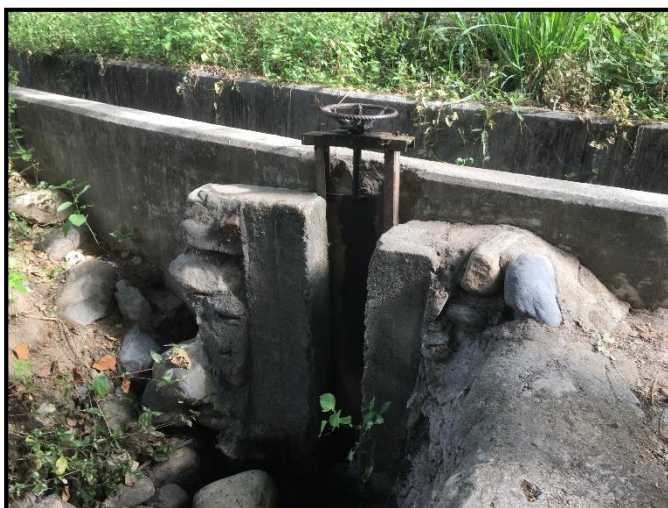
Figura 21. Canal de concreto existente y toma lateral existente Fuente: Elaboración Propia
