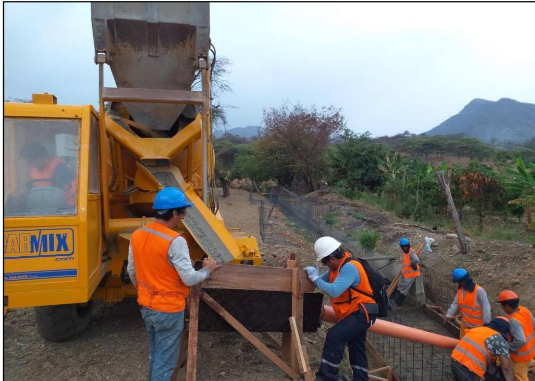
VACIADO DE CONCRETO DEL CARMIX AL CANAL CON TUBERÍA PVC 8”.
