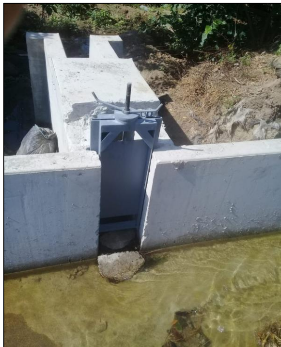
TOMAS LATERALES COLOCADO LAS COMPUERTAS
