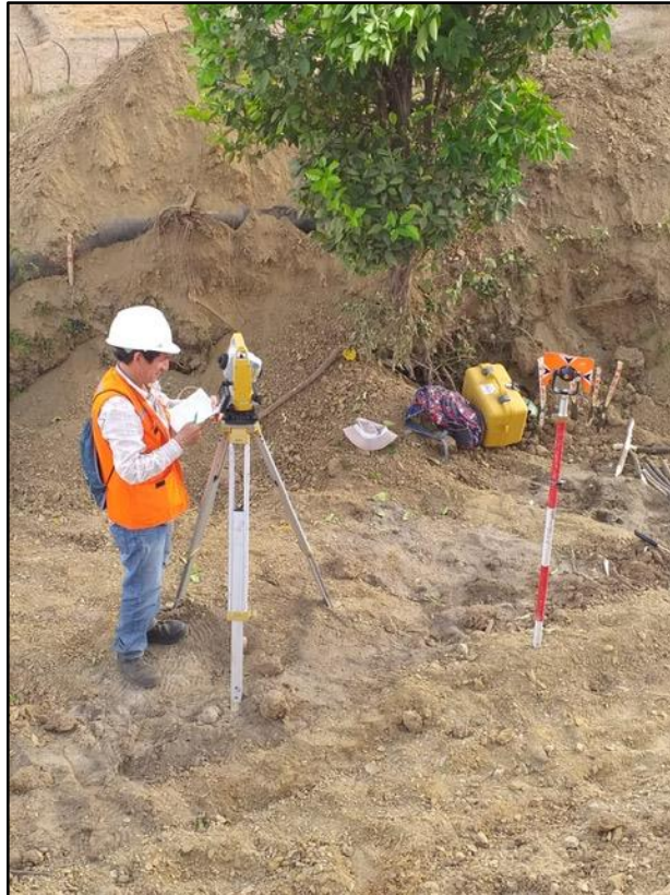
TRABAJOS DE TRAZO, NIVELACIÓN Y REPLANTEO Y TOPÓGRAFO CON SU EPP.
