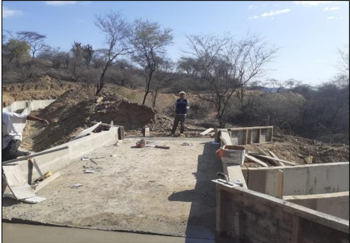
CONSTRUCCIÓN DE LA ESTRUCTURA DE CANOA EN EL CANAL PARA EVACUAR AGUAS DE LLUVIAS.
