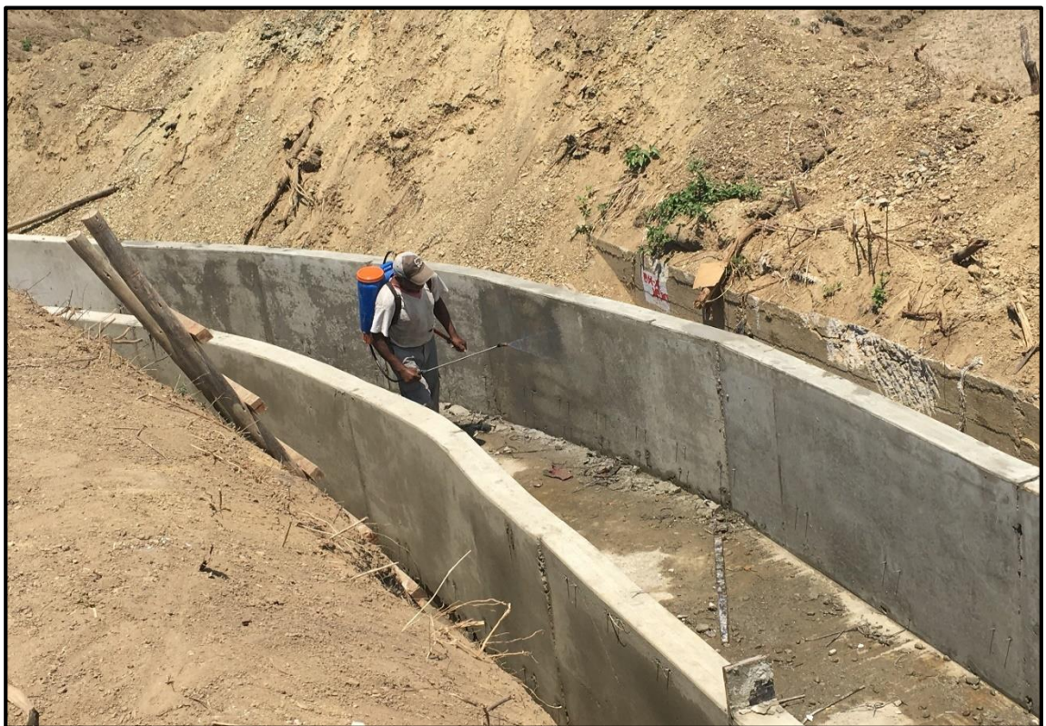
TRABAJOS DE CURADO DEL CONCRETO APLICADO INMEDIATAMENTE DESPUÉS DE DESENCOFRADO.
