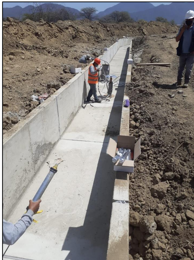
COLOCACIÓN DEL CORDÓN EN LAS JUNTAS Y CON LA PISTOLA SE VIENE SELLANDO.
