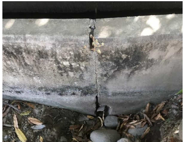
MUROS AGRIETADOS Y JUNTA DETERIORADA QUE REQUIERE DEMOLER EL PAÑO DE MURO Y NUEVO SELLADO DE JUNTA
