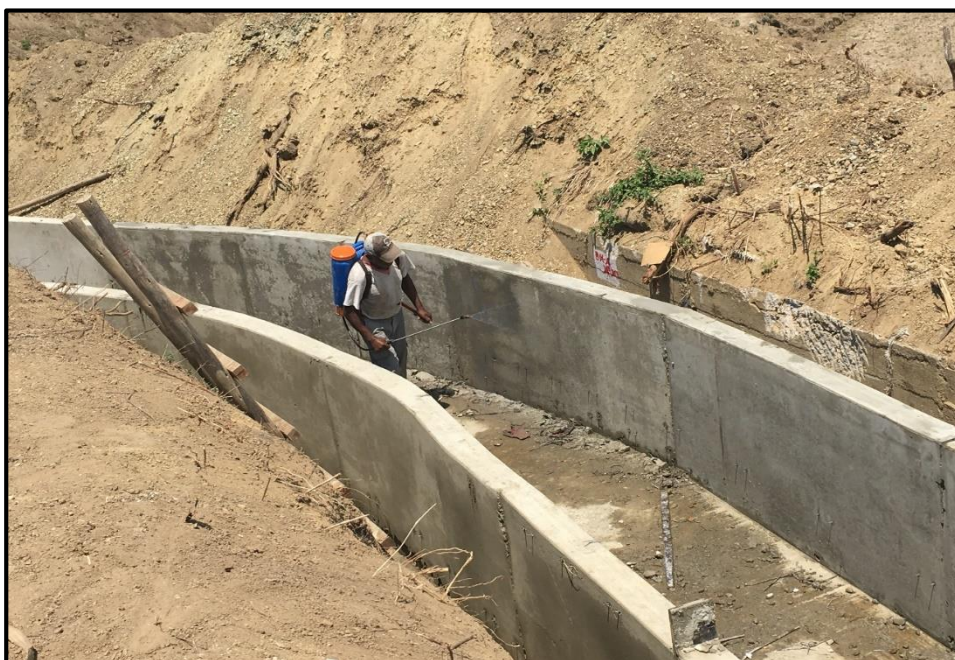
Figura 16. Trabajos de curado del concreto aplicado inmediatamente después de desencofrado
