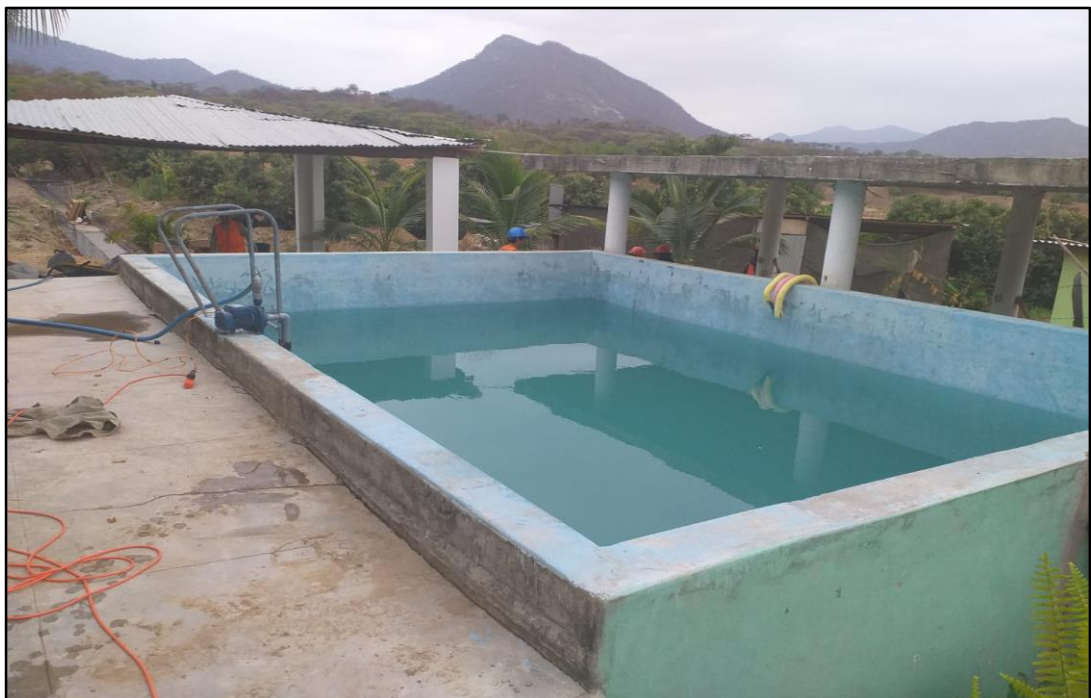
AGUA LIMPIA A DISPOSICIÓN DE LA OBRA PARA EL TRAMO DE KM. 4+375 AL KM. 5+600 (CARRETERA).
