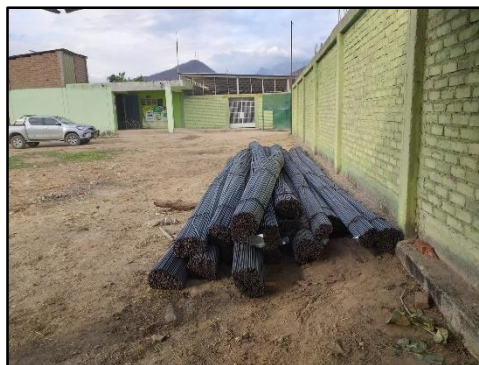
LLEGADA DEL PRIMER LOTE DE FIERRO DE 3/8: 16 ROLLOS DE 02 TON. C/ROLLO.
