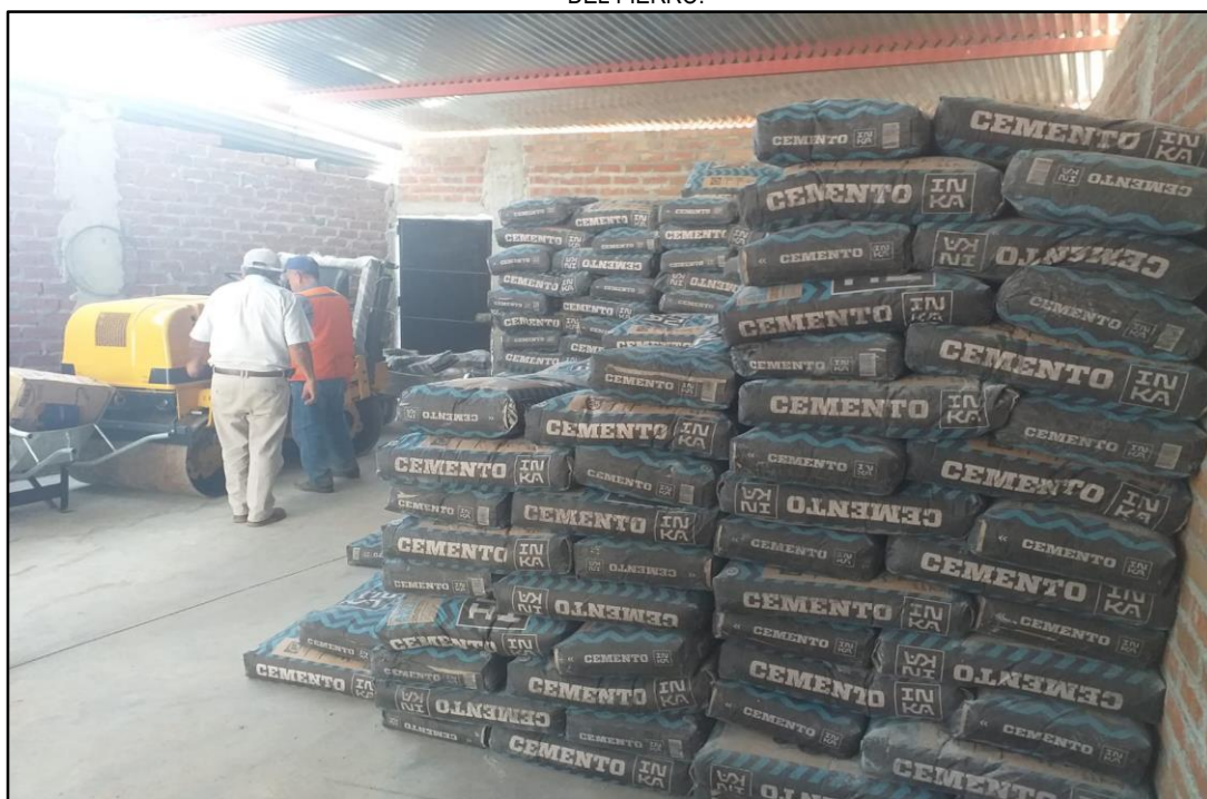
ABSTECIMIENTO DE CEMENTO DURANTE LA EJECUCIÓN DE LA OBRA.
