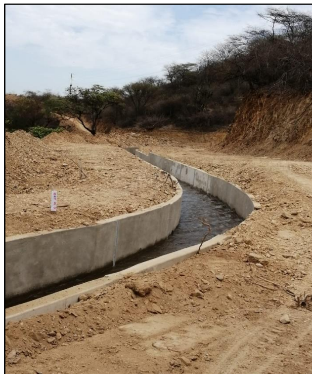
OTROS TRAMOS DE CANAL TERMINADO Y EN OPERACIÓN PARA EL RIEGO DE CULTIVOS.
