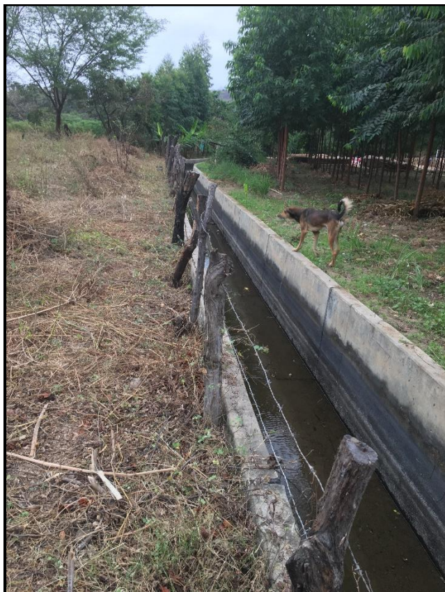
Figura 22. Cerco de púas al pie de la corona del muro concreto del canal Fuente: Elaboración Propia
