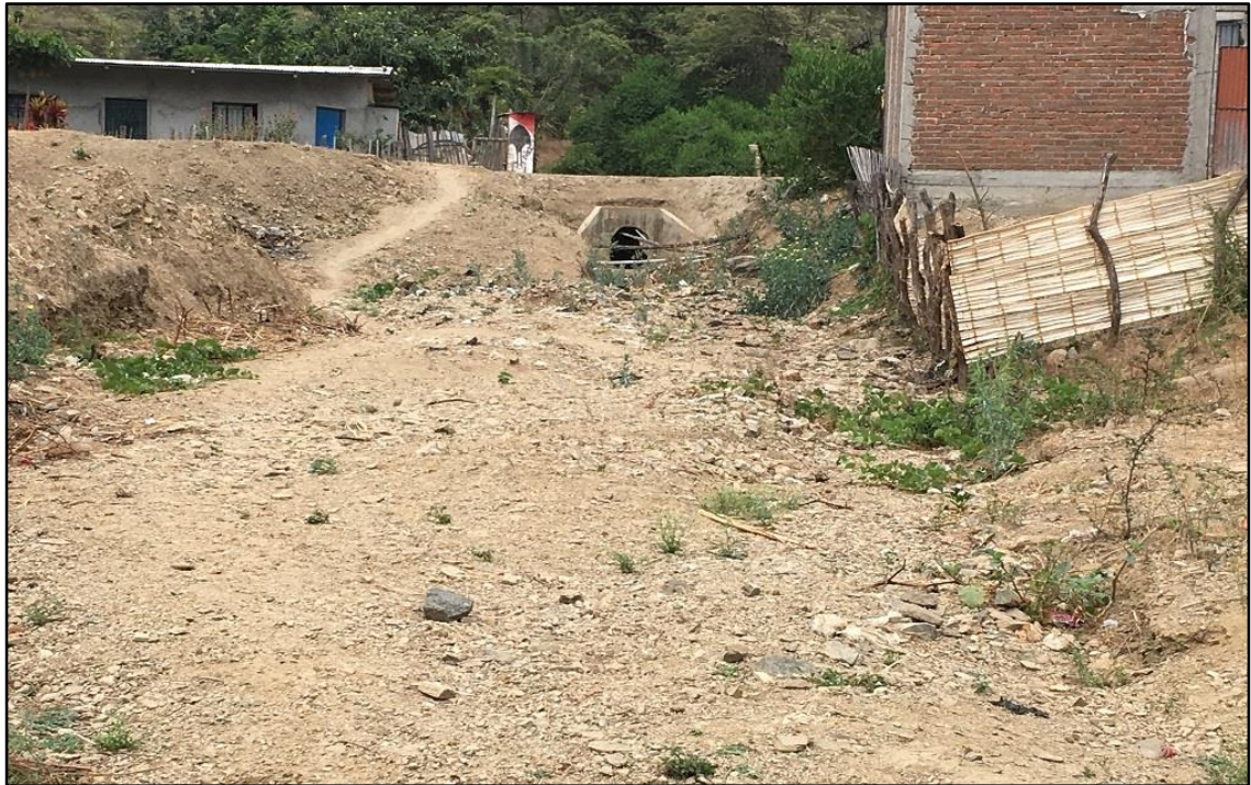
ALCANTARILLA DE CARRETERA EN MARGEN DERECHA QUE SE ACTIVA EN ÉPOCA DE LLUVIAS, ACTUALMENTE LAS AGUAS EVACUAN AL CANAL DE TIERRA, REQUIERE DE LA CONSTRUCCIÓN DE UNA CANOA EN LA PROGRESIVA KM. 5+187.
