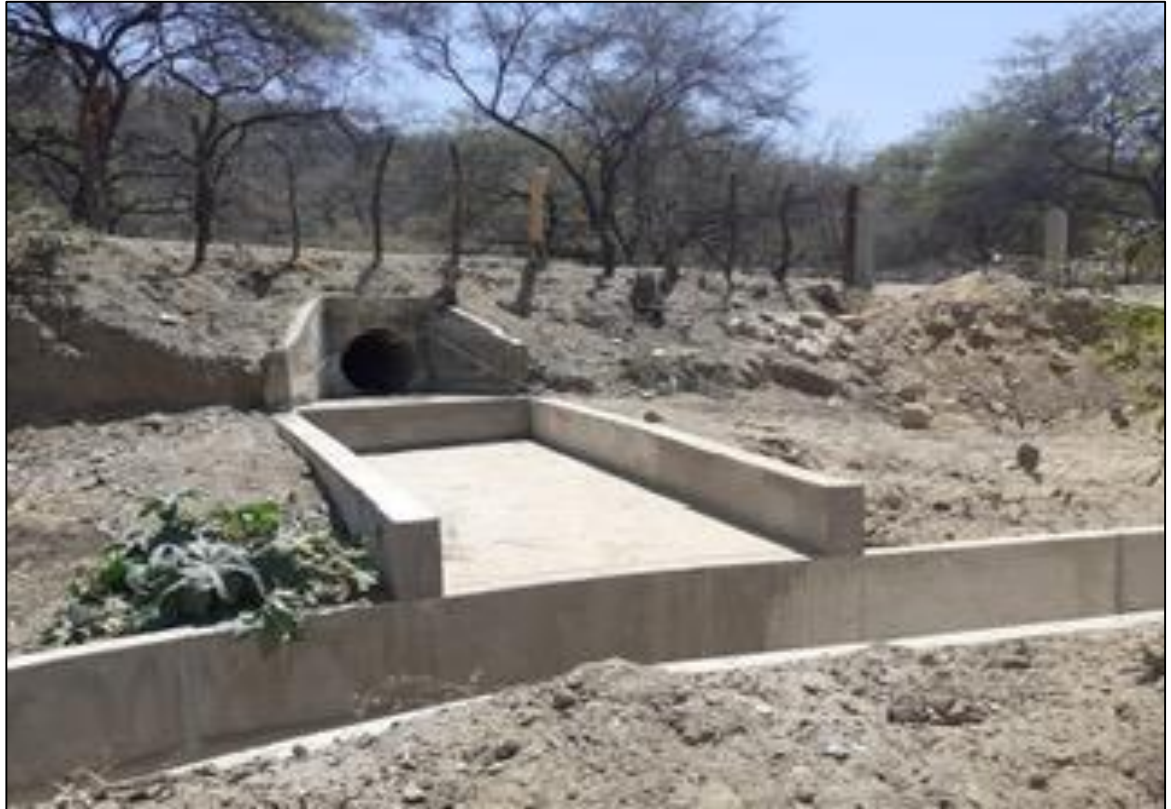
TERMINACIÓN DEL 5° VERTEDERO DE CONCRETO ARMADO
