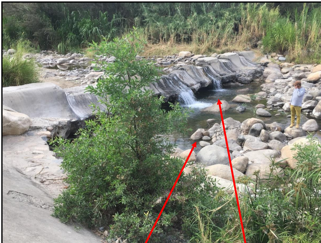
Figura 19. Bocatoma La Gallega, estado en que se encuentra al momento del diagnóstico y en la actualidad.
