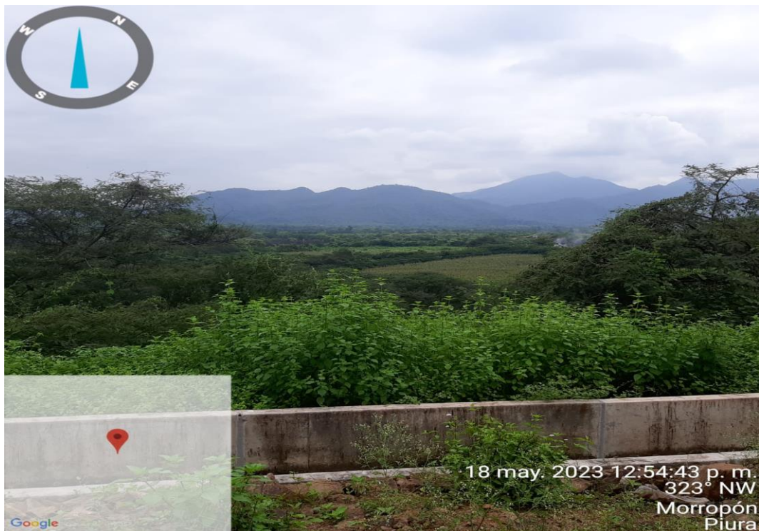
Figura 37. Muestra áreas de terreno, en producción, irrigados por agua del canal piedra el toro, km 8+000 aproximadamente.
