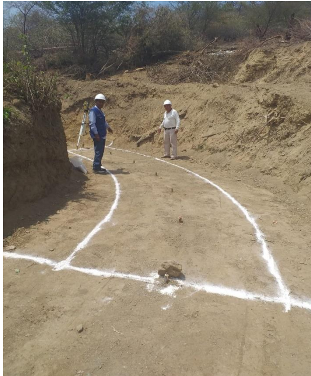
EMPLANTILLADO DEL CANAL EN LOS TRAMOS CON CURVA, RESIDENTE Y SUPERVISOR PRESENTES EN LOS TRABAJOS
