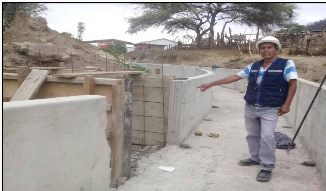
Figura 7. Toma lateral 03 y estructura de botadero en construcción Fuente: Elaboración Propia
