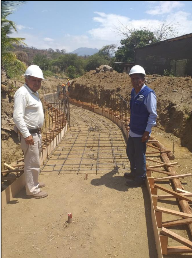
Figura 11. Colocación de los encofrados y fierro corrugado 3/8” al espaciamiento indicado en planos correspondientes
