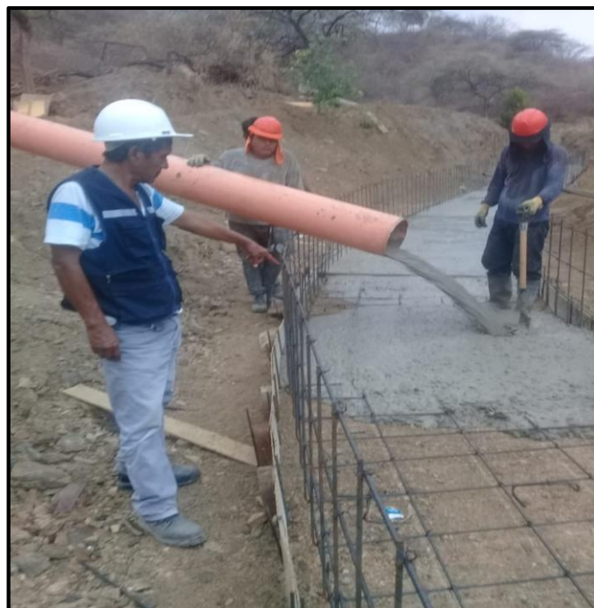
VACIADO DE CONCRETO DEL CARMIX AL CANAL CON TUBERÍA PVC 8”.
