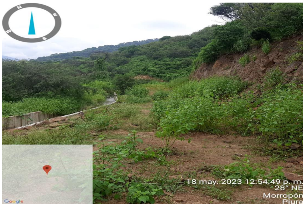
Figura 38. Muestra canal en funcionamiento y camino de vigilancia con poca vegetación, por ser terreno rocoso, km 8+100 hacia adelante.
