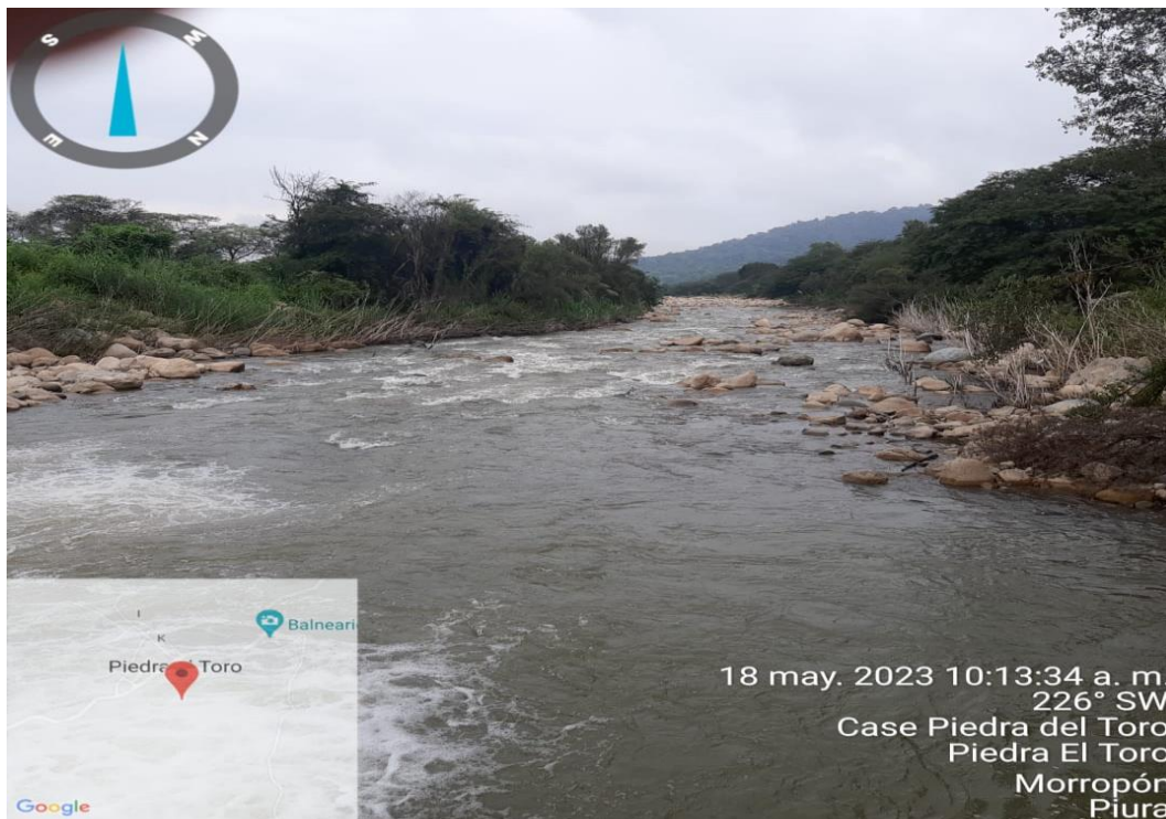
Figura 24. Muestra torrente del río la gallega, aguas abajo, mostrando material pedregoso que lo conforma y de alguna manera, lo estabiliza y evita mayores daños a la estructura.
