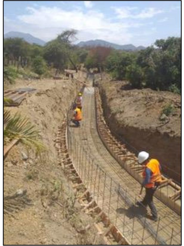
Figura 11. Colocación de los encofrados y fierro corrugado 3/8” al espaciamiento indicado en planos correspondientes
