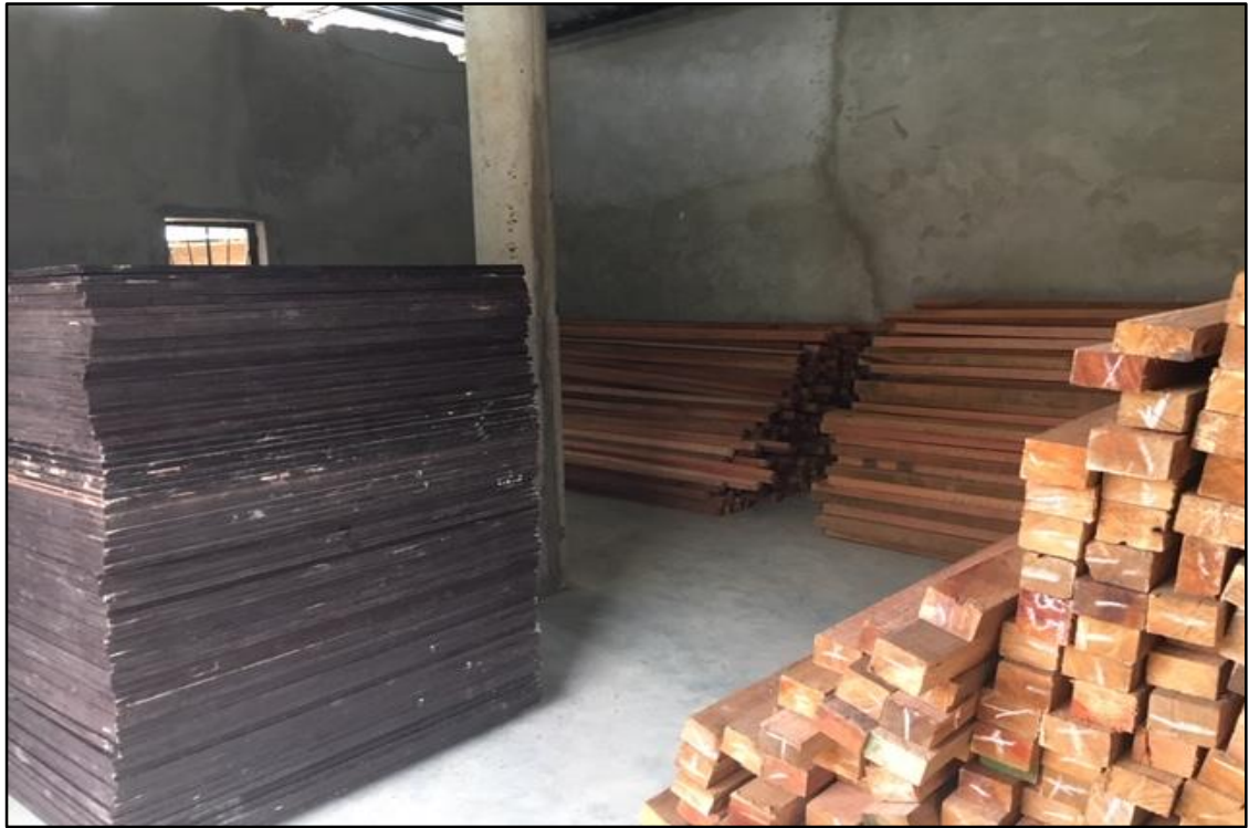
ABASTECIMIENTO DE PLANCHAS DE TRIPLAY FENÓLICO Y MADERA TORNILLO PARA LA HABILITACIÓN DE LOS PANELES PARA LOS TRABJSO DE ENCOFRADOS.
