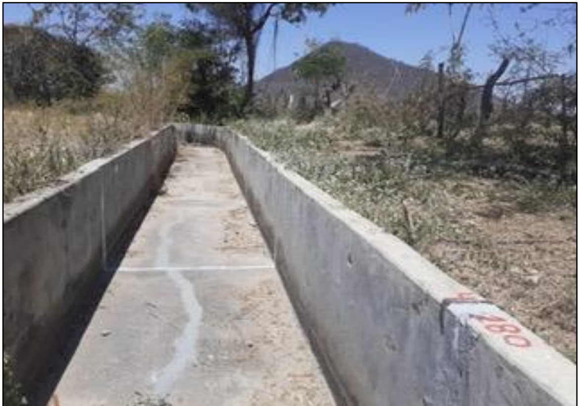
SELLADO DE FISURAS Y JUNTAS EN EL CANAL DE CONCRETO EXISTENTE DESDE EL KM. 0+000 AL KM. 4+375
