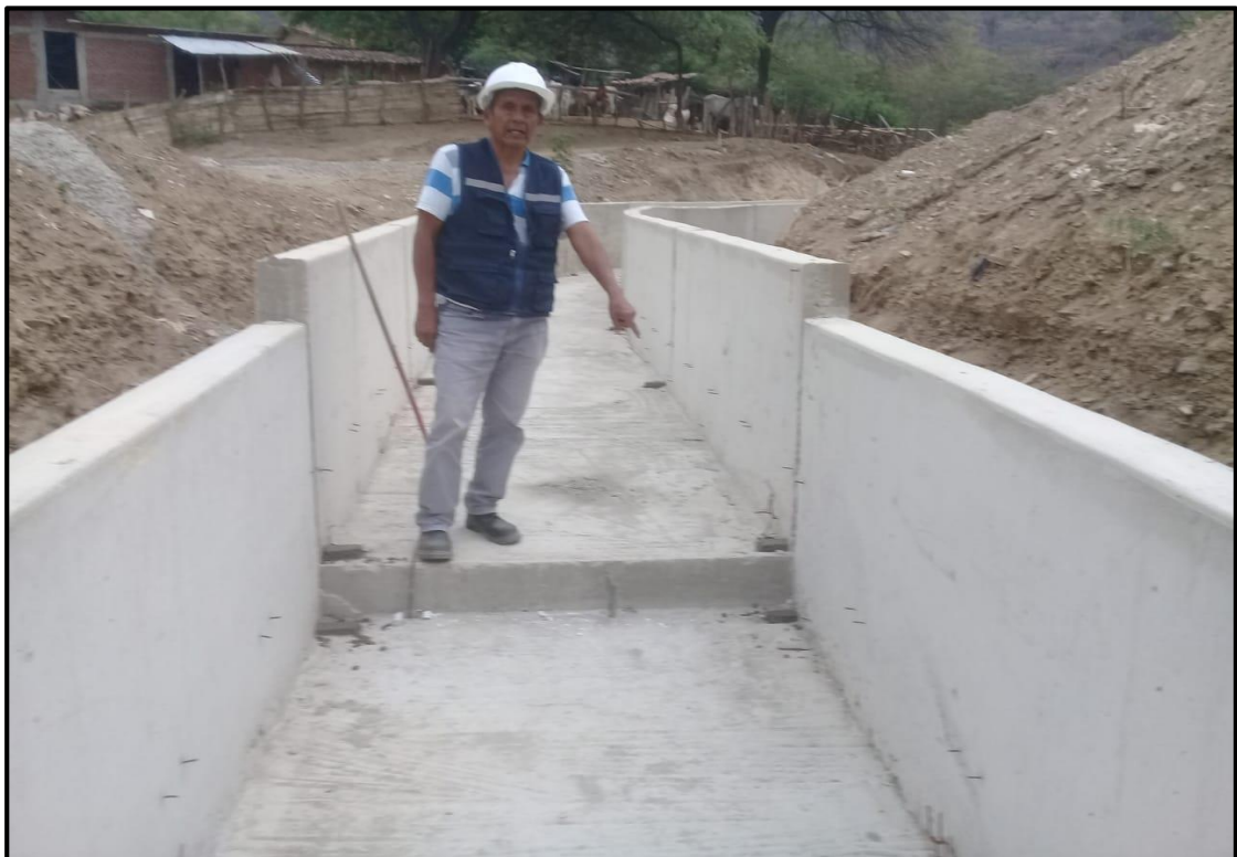
VISTA DONDE SE MUESTRA LA CÁIDA VERTICAL PARA CONSEGUIR FLUJO SUBCRÍTICO Y LA TOMA LATERAL PUEDA CAPTAR EL AGUA AGUAS ABAJO.
