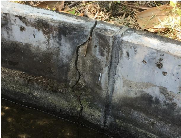
MUROS AGRIETADOS Y JUNTA DETERIORADA QUE REQUIERE DEMOLER EL PAÑO DE MURO Y NUEVO SELLADO DE JUNTA
