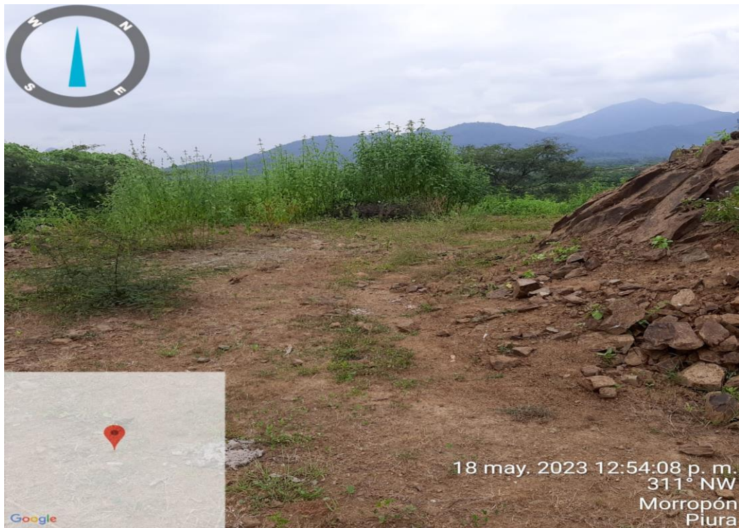
Figura 36. Muestra camino de vigilancia, km 8+050, relativamente limpio de maleza, no habiendo crecido, por ser plataforma rocosa.
