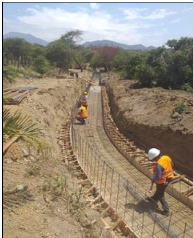
COLOCACIÓN DE LOS ENCOFRADOS Y FIERRO CORRUGADO 3/8" AL ESPACIAMIENTO INDICADO EN LOS PLANOS.
