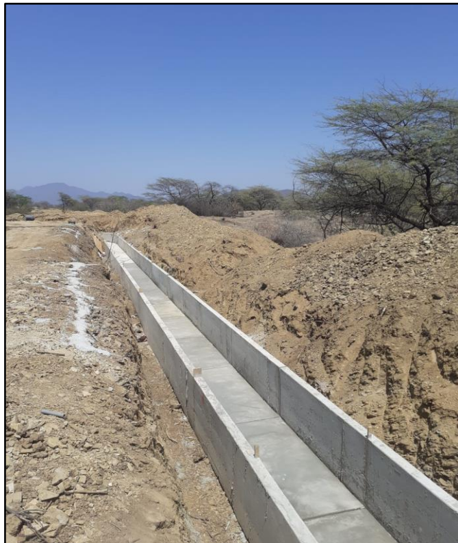
TRABAJOS DE ACABADOS QUEDA EL CANAL LISTO PARA LA COLOCACIÓN DE JUNTAS ELASTOMÉRICAS.
