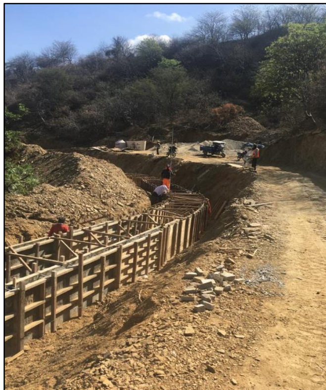
TRABAJOS DE ENCOFRADOS EN TRAMOS RECTOS Y EN CURVAS DEL CANAL.
