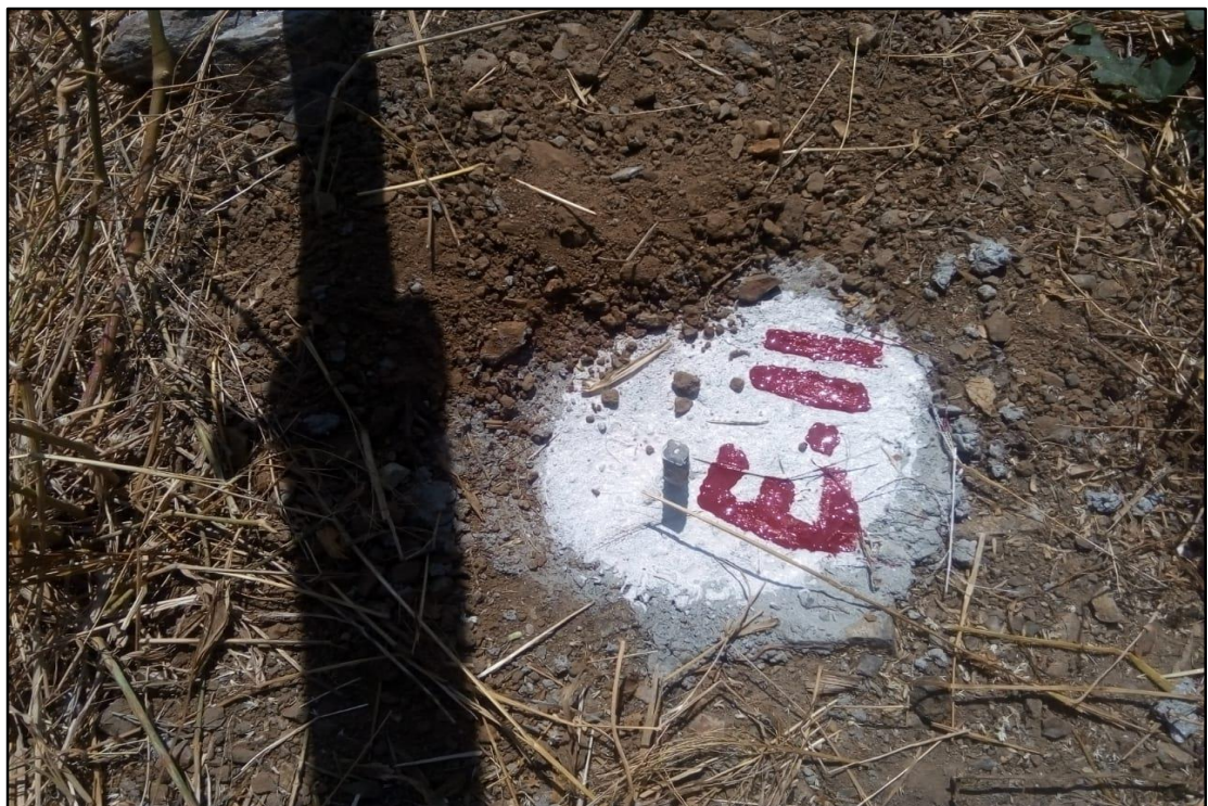
MONUMENTACIÓN DE LOS HITOS DE LA POLIGONAL DE APOYO
