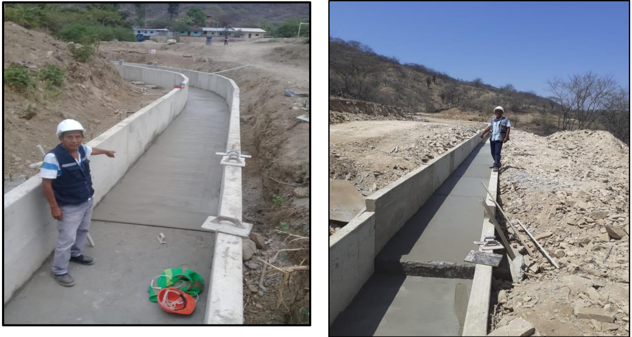
Figura 12. Acabado de piso terminado en el canal piedra el toro, véase caída vertical
