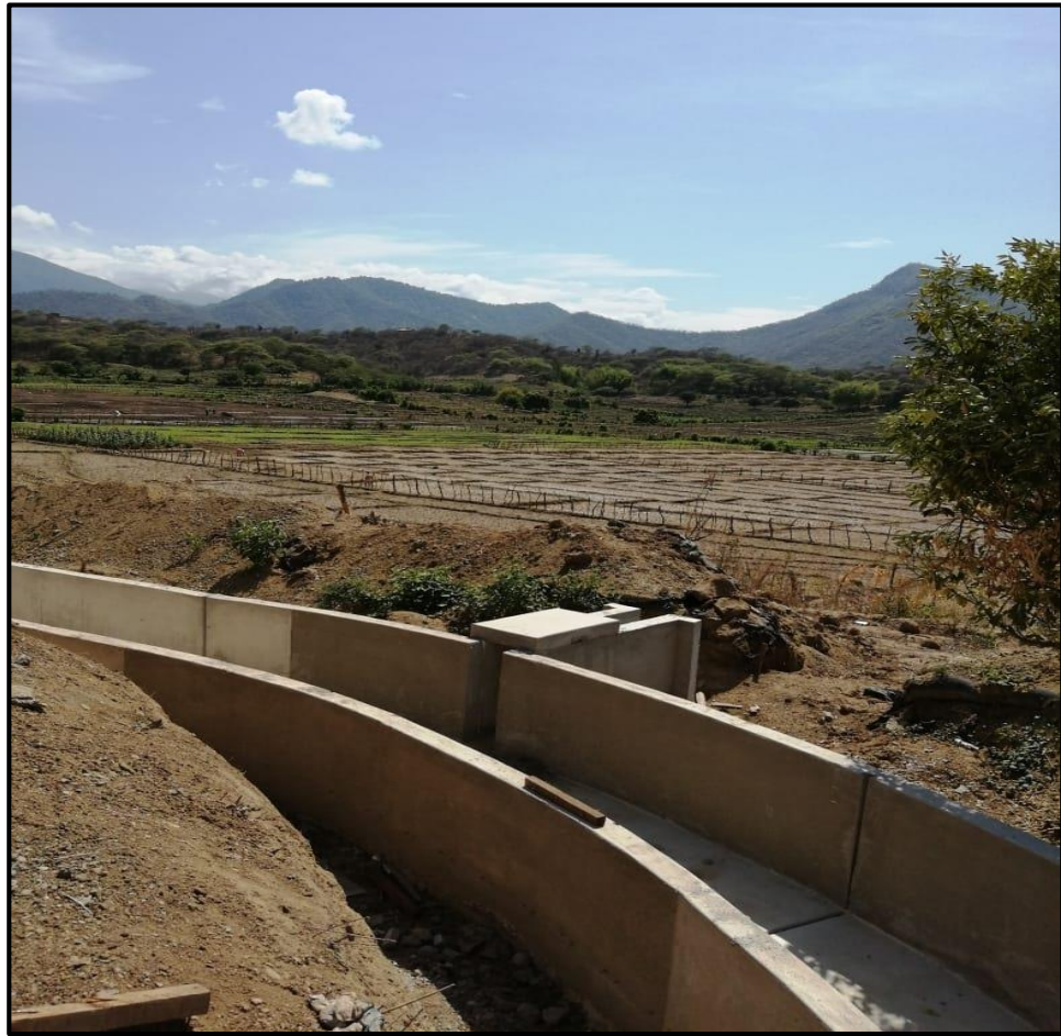
Figura 8. Construcción de Toma Lateral y Caídas Verticales Fuente: Elaboración Propia
