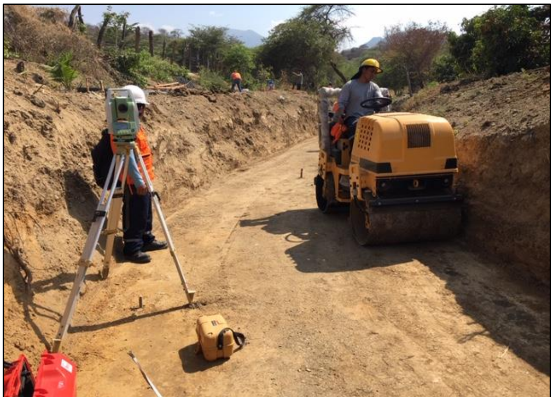
TRABAJOS DE RELLENO Y COMPACTACIÓN PARA LA SUB RASANTE DEL CANAL.
