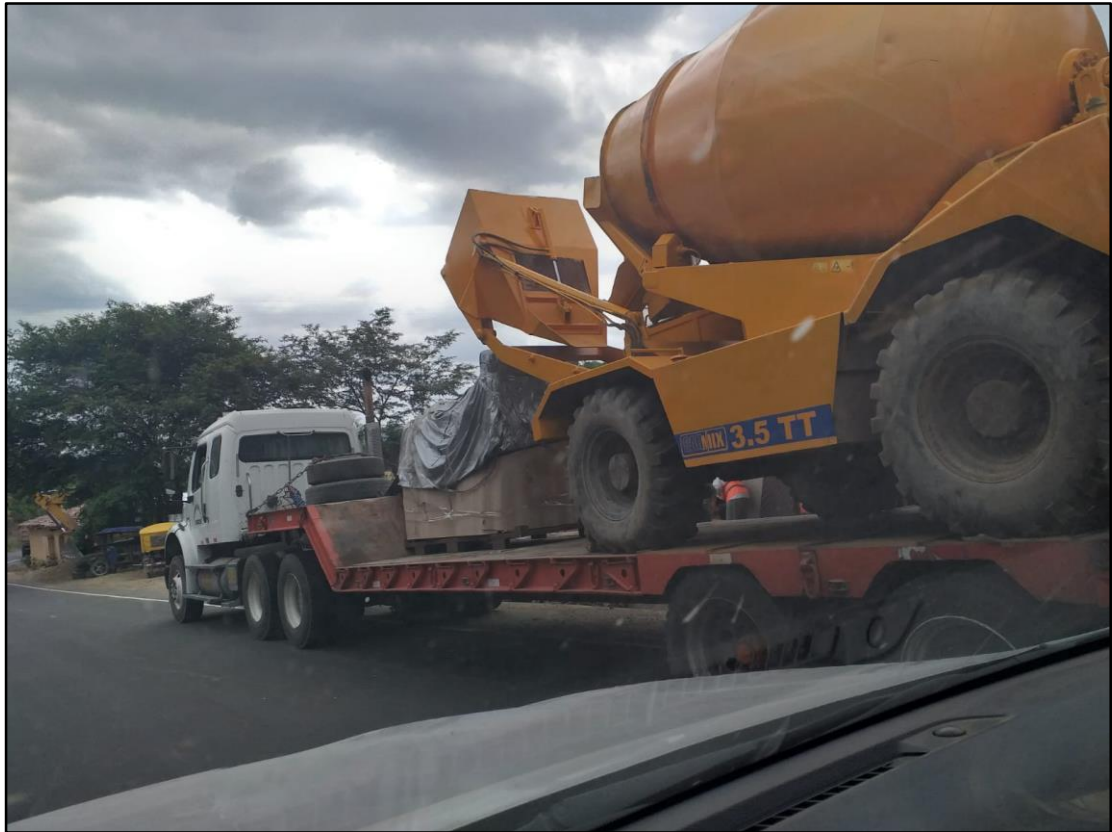
LLEGADA DEL CARMIX DE 3.50 M3 EQUIPO DE PREPARACIÓN DEL CONCRETO.
