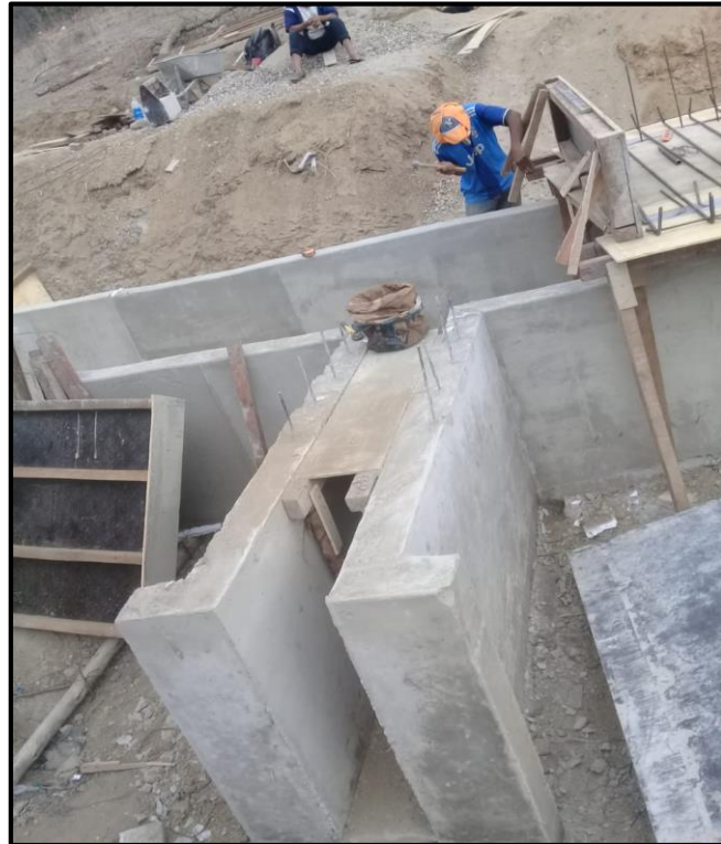
Figura 6. Construcción del pase peatonal obsérvese estructura de toma lateral, junto a pase.
